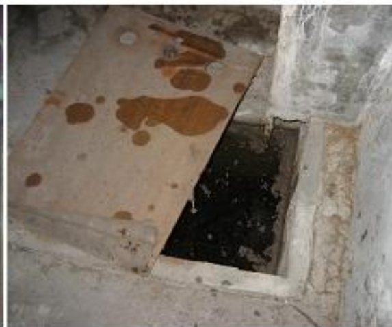
地下室污水池
