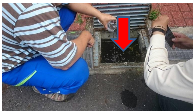
排水溝沉沙池/陰井
