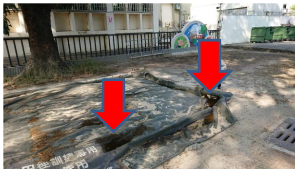
覆蓋沙池之帆布積水
