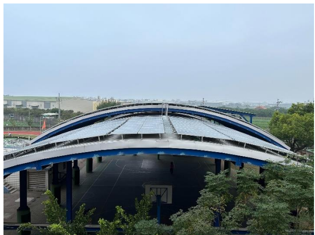
在綜合球場屋頂設置太陽能光電能板。
