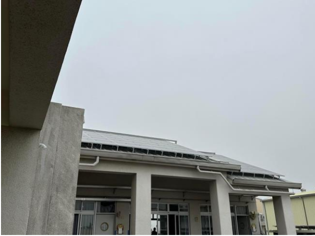
在建築物屋頂設置太陽能光電能板。
