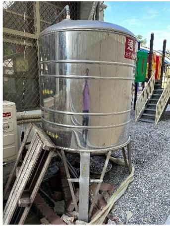
由於茶水間的水冷卻器會送出許多水冷卻熱水器，因此學校設置管路，並將這些用於冷卻的水存進此水塔中，供學生進行環境打掃時使用
