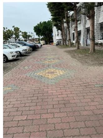
本校透水率達61.6%，道路多用透水連鎖磚鋪設，得以在雨天時，更有效地留下更多雨水成為地下水再利用
