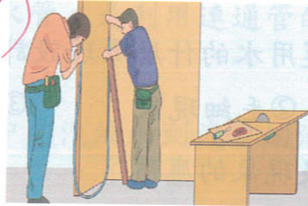
⑧ 施工時，利用水管測量水平
