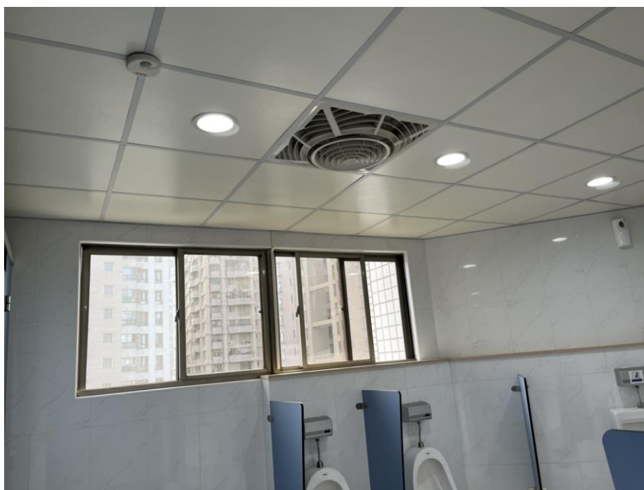
圖6 廁所排風與開窗配置（示意）
