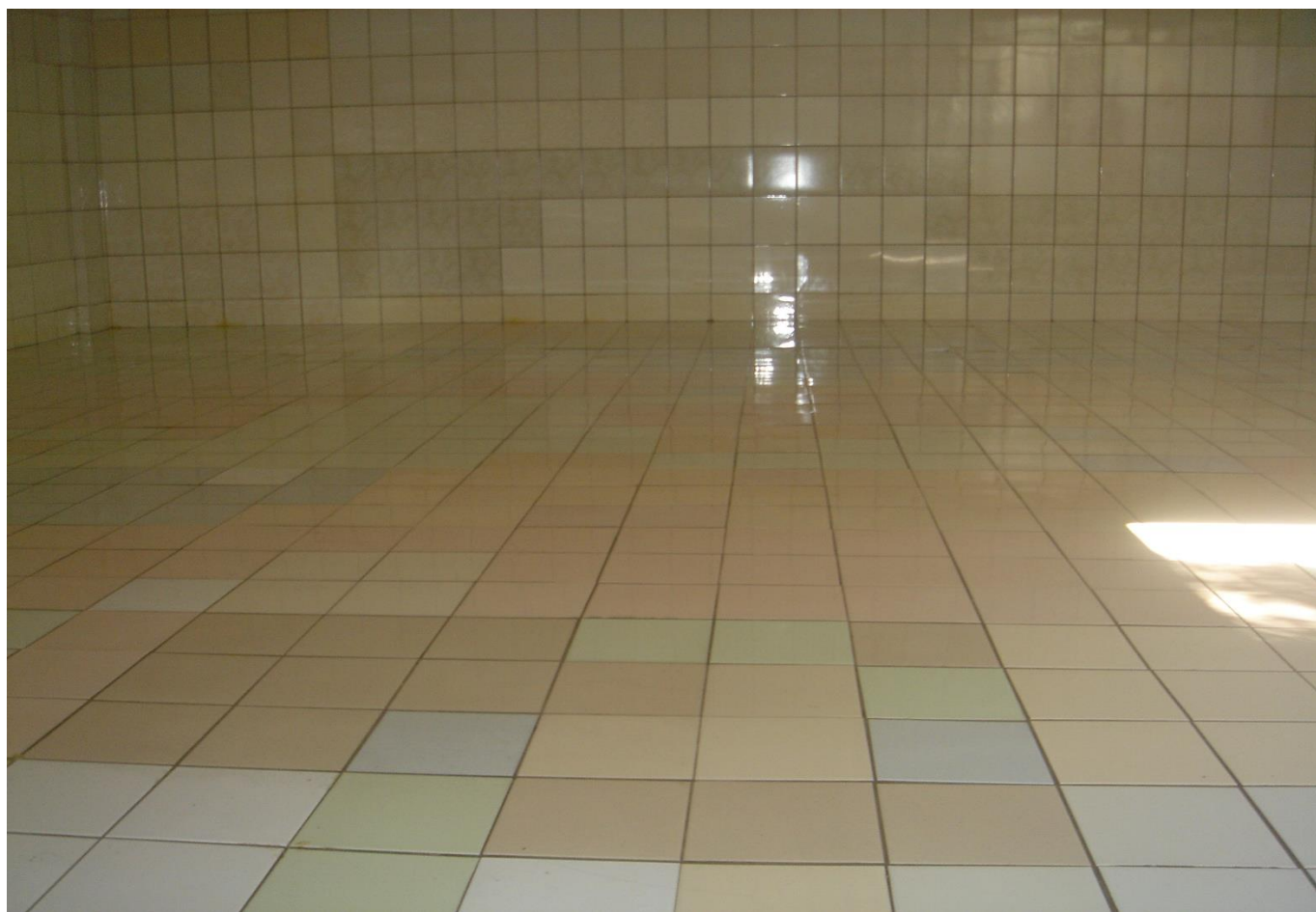
說明：清洗地下水塔。
