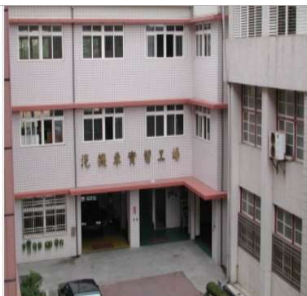
汽機車實習大樓
