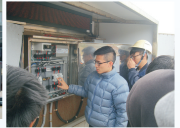
太陽光電設置考照練習場
