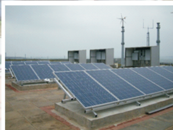
太陽光電設置考照練習場
