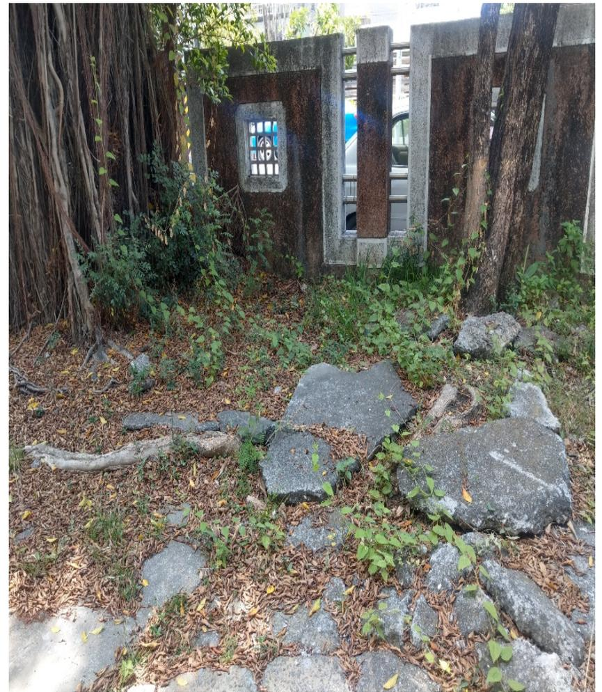
移除 2: 西側圍牆黑板樹竄根水溝及化糞池嚴重，根張腐朽，建議移除。
