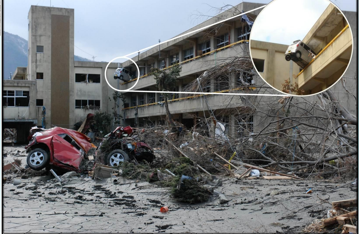
【資料-513】釜石市立鵜住居小学校の被災写真
