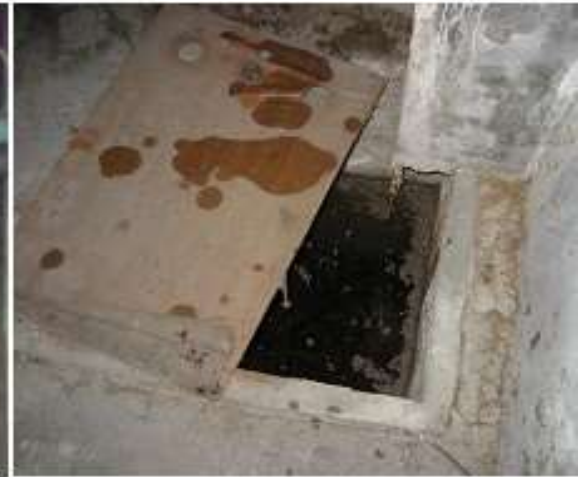
地下室污水池
