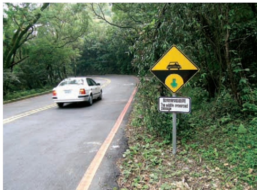
陽明山國家公園境內有全臺首創之「動物穿越道路涵洞生態廊道設施」 / 黃光瀛提供
