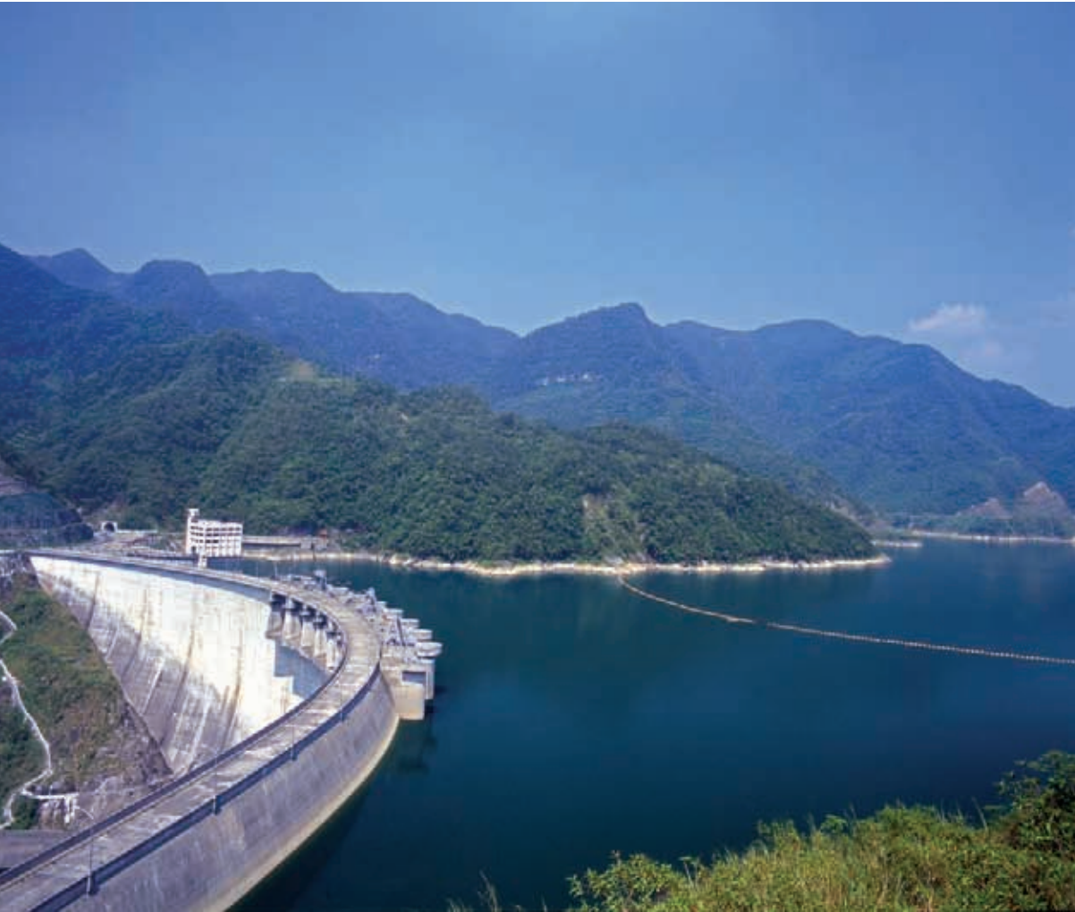
水庫可以控制河川的逕流，在需水時刻再洩放流量，圖為翡翠水庫 / 達志影像提供
