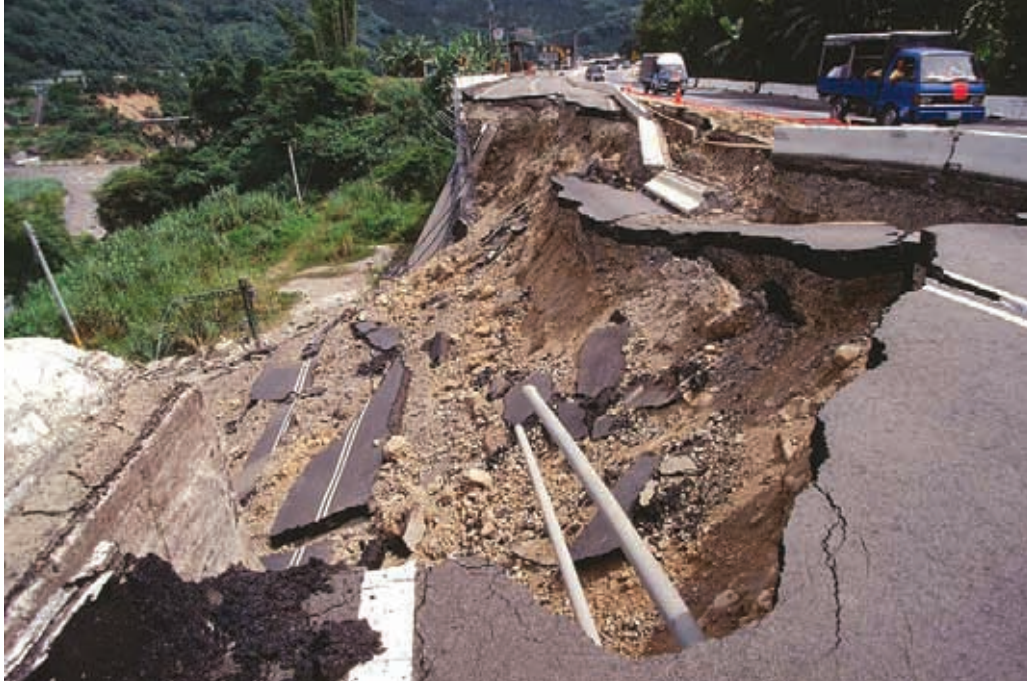
921大地震造成開往埔里的公路路基下陷的情形 / 楊佛頭提供
