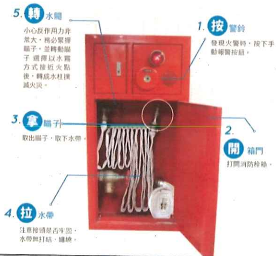
消防栓操作說明
