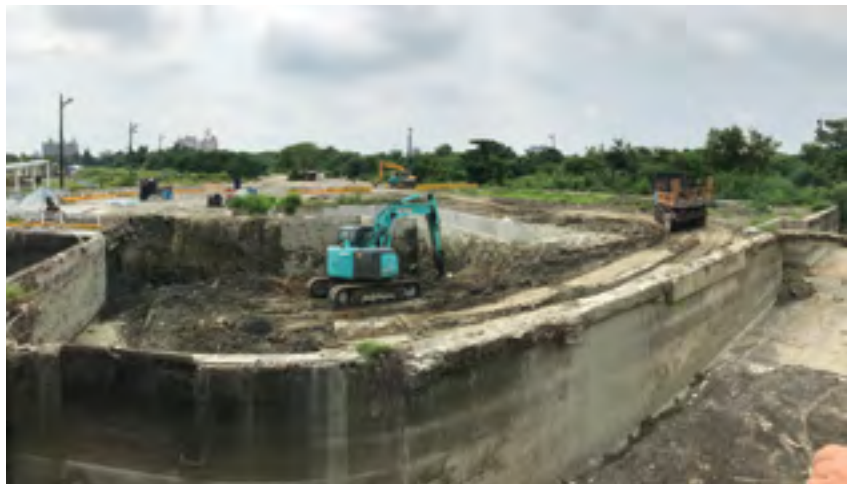
▲ 縣民公園地坑施工。
