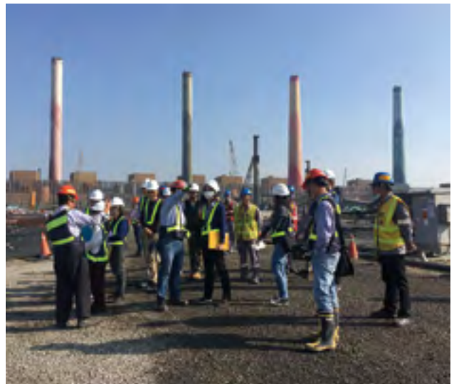
▲ 赴臺中電廠 (臺中煤倉工務所) 進行公共工程空氣污染防制管理制度輔導訪查。
