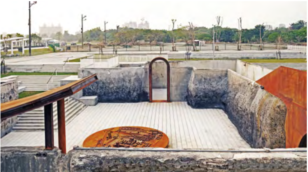
▲ 縣民公園地坑完工。
