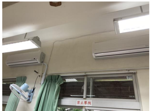
說明：冷氣裝設電力改善工程
