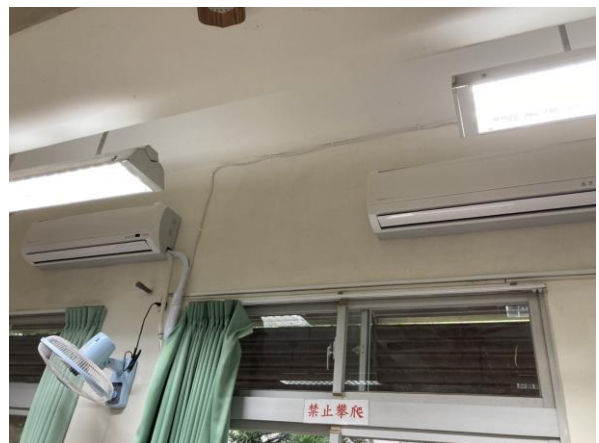
說明：冷氣裝設電力改善工程
