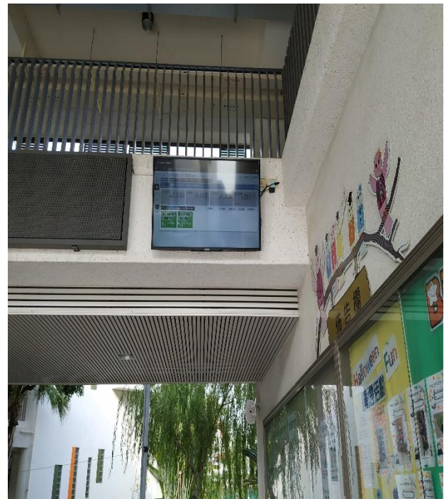
學校玄關設置大電視大電視，放映太陽光電發電系統即時統計資料
