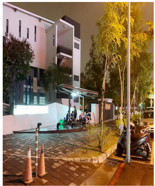
學校大門口家長接送區的候車亭設置太陽能光電板，將光能轉換為電能，於夜間照明使用。
