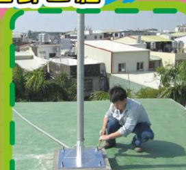
安裝避雷針支架
