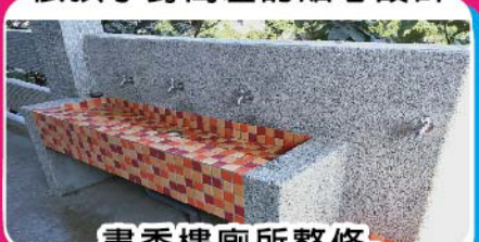
書香樓廁所整修- 美觀好用的洗手台
