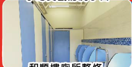
和順樓廁所整修- 乾淨舒適的如廁空間
