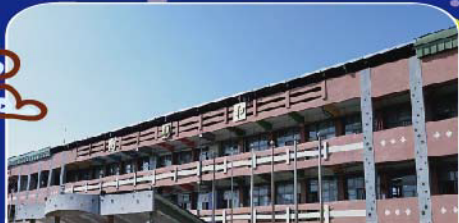
補強後-煥然一新的和順樓
