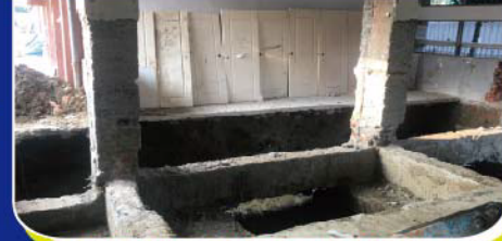
補強中-進行擴柱準備
