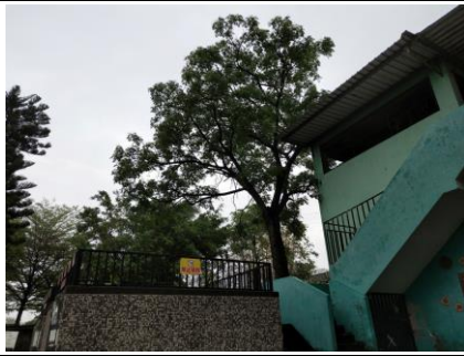
說明：落葉堆肥區中苦楝樹緊靠建物且達四樓高度
