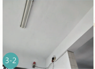
改善後-頂樓廁所天花板修復粉刷
