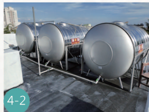
改善後-水塔更新
