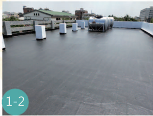
改善中-屋頂地坪防水層施作
