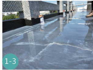
改善中-屋頂地坪防水測試
