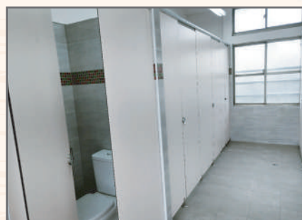
廁所整建-空間大改造(便器降板)
