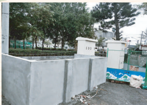
電力改善-台電配電場所(修整圍牆朝外)
