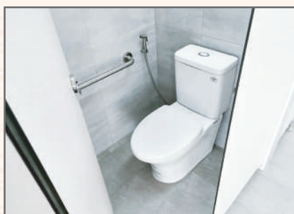
廁所整建-每樓層新增坐式便斗
