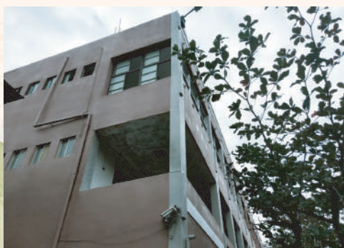
補強工程-改善斑剝老舊牆面(施工中)
