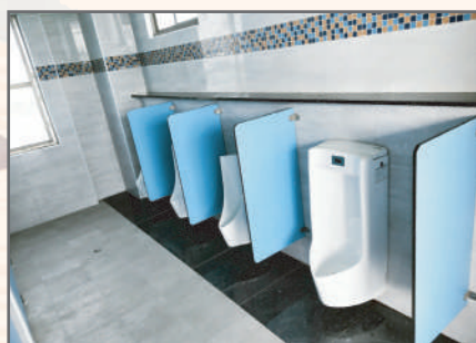
廁所整建-小便斗更新
