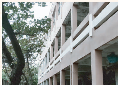
補強工程-書香樓外牆施作仿石漆(施工中)
