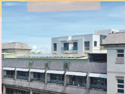
屋頂光電設施
