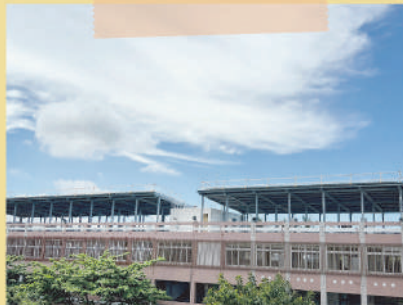
屋頂光電設施
