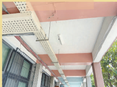
全棟油漆粉刷更新
