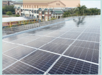
光電球場屋頂設施
