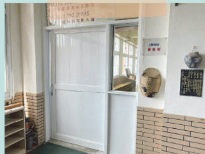
更新綜合圖書館鋁門
