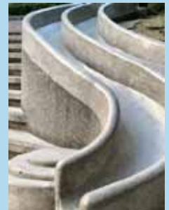
大象溜滑梯改善完工
