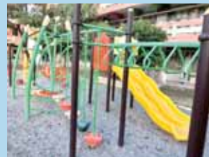
遊戲場A區-踏樁更換及器材實面補漆完成
