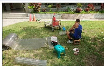
校園修繕-水溝紗網 更換
