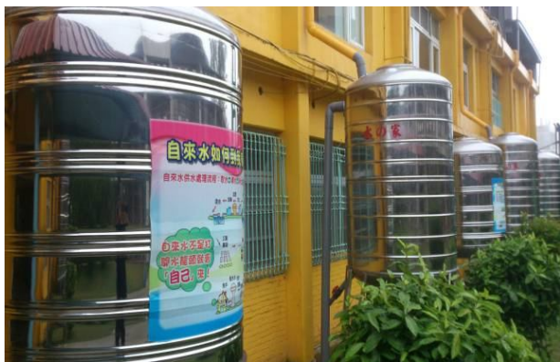
設置雨水回收桶，提供沖廁與澆灌使用
