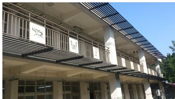
後棟教室遮陽設施，減少陽光直射室內
