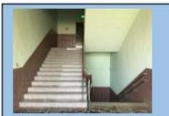
通往頂樓樓梯無人出入
