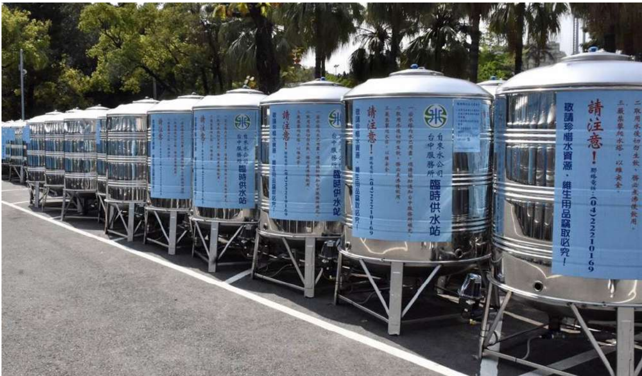
臨時供水站 / 來源水利署
