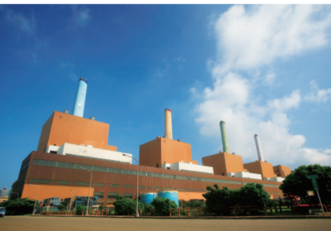
▲ 台中火力發電廠（燃煤）電廠。
