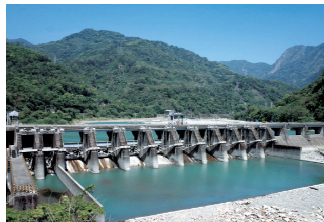
▲ 大甲溪發電廠。
