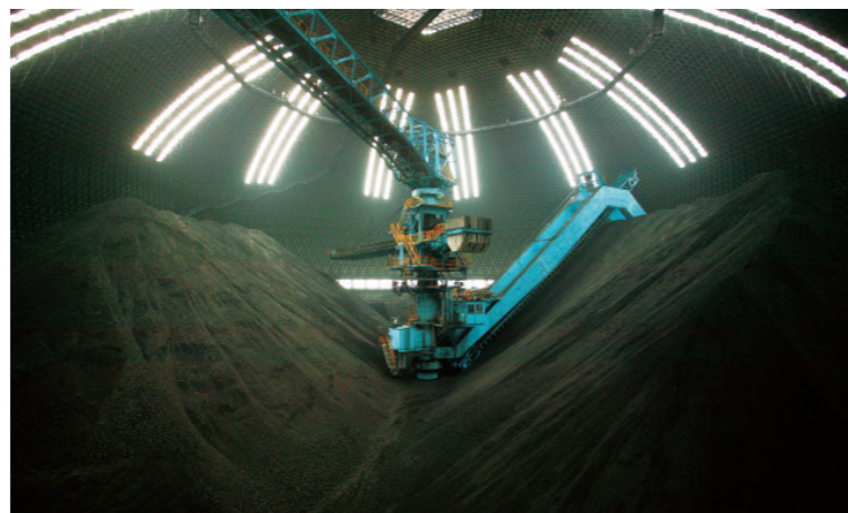
▲ 燃煤是易於運送且安全性尚佳的發電原料。
