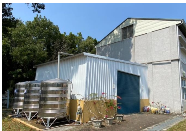
由台積電贊助設置雨水回收系統，收集雨水用來澆灌及沖廁
