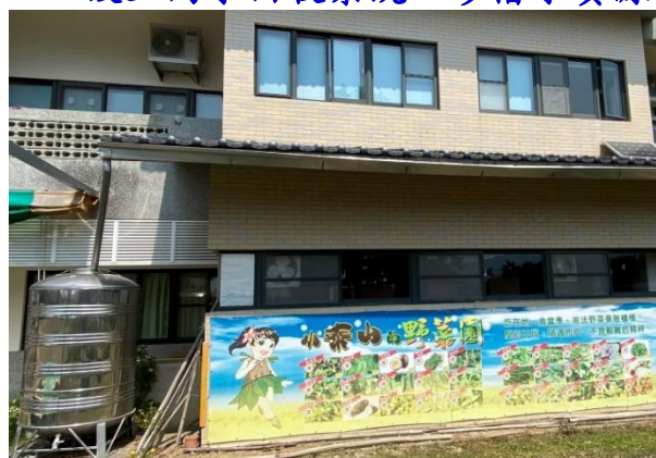
由台積電贊助設置雨水回收系統，收集雨水用來澆灌及沖廁
