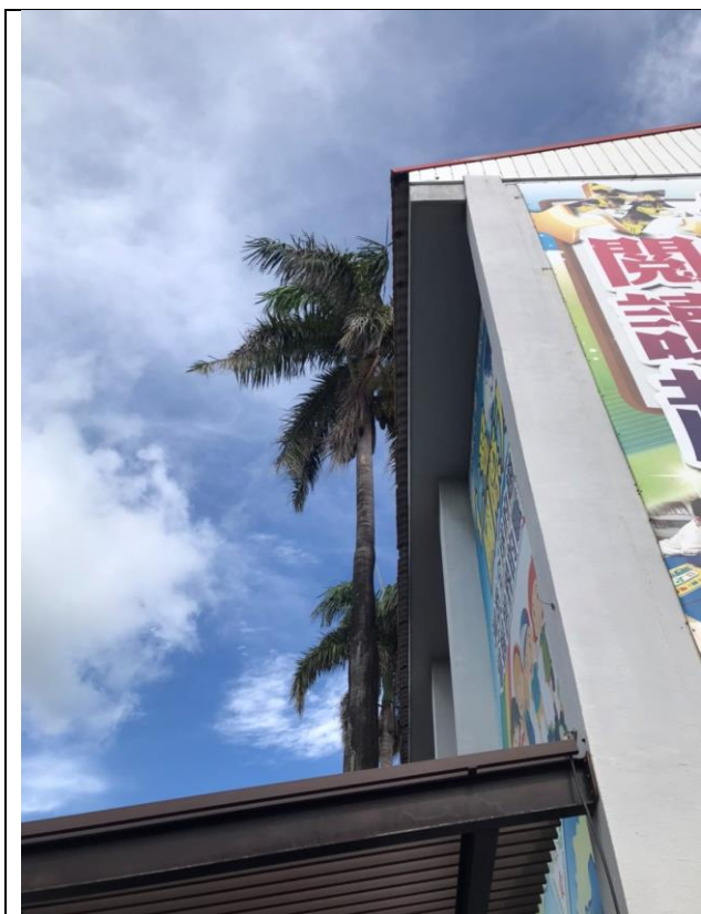
樹高超過三樓且葉柄已經伸展到設置太陽能板的空間，勢必損害設施。
