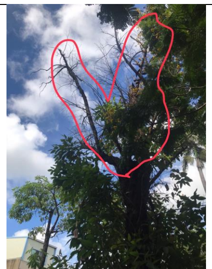
樹幹枯萎腐朽近 5 公尺 有倒塌之虞
