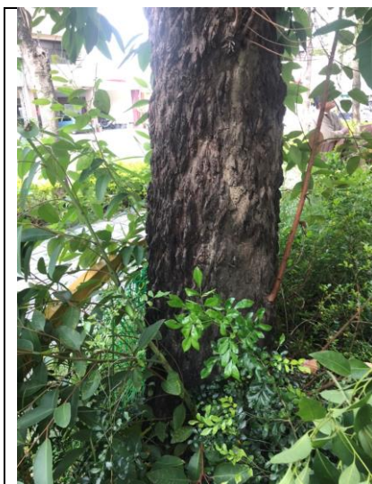
樹幹白蟻入侵嚴重
