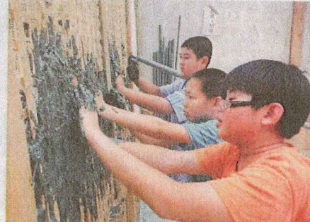
新東國小學童參與歷史建物編竹夾泥牆修復工程，認識古蹟建物構造。（記者王涵平攝）
