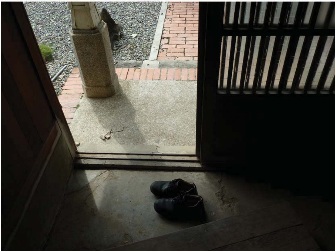
【8】上圖：校長宿舍室內居間現況照片 下圖：校長宿舍玄關現況照片
