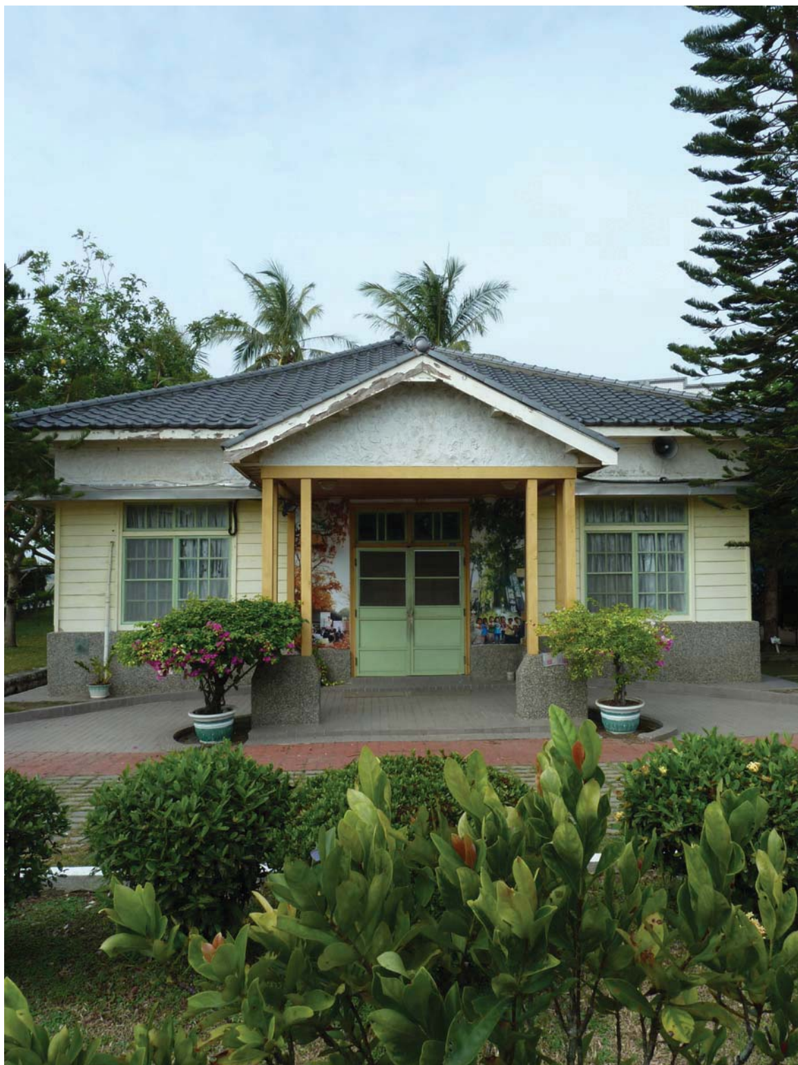
【1】木造辦公室東向入口外觀現況照片
