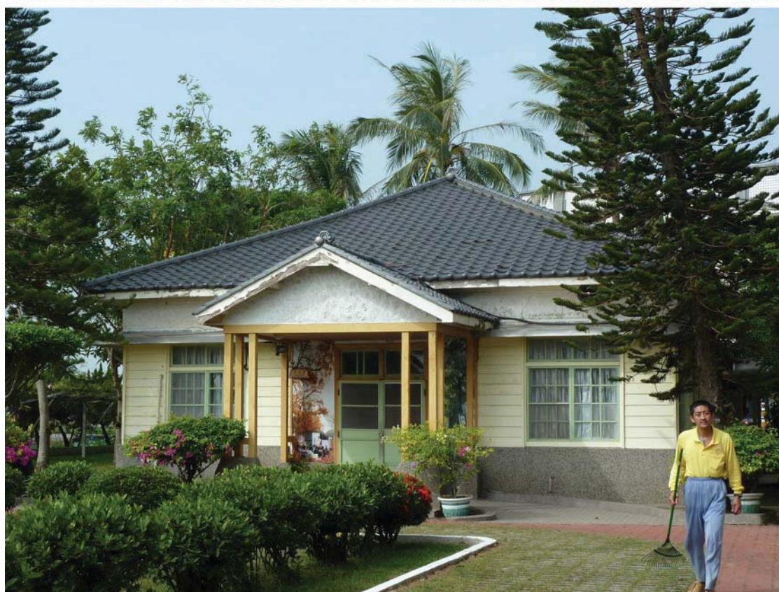
【3】上圖：木造辦公室東南角外觀照片 下圖：木造辦公室東側外觀照片
