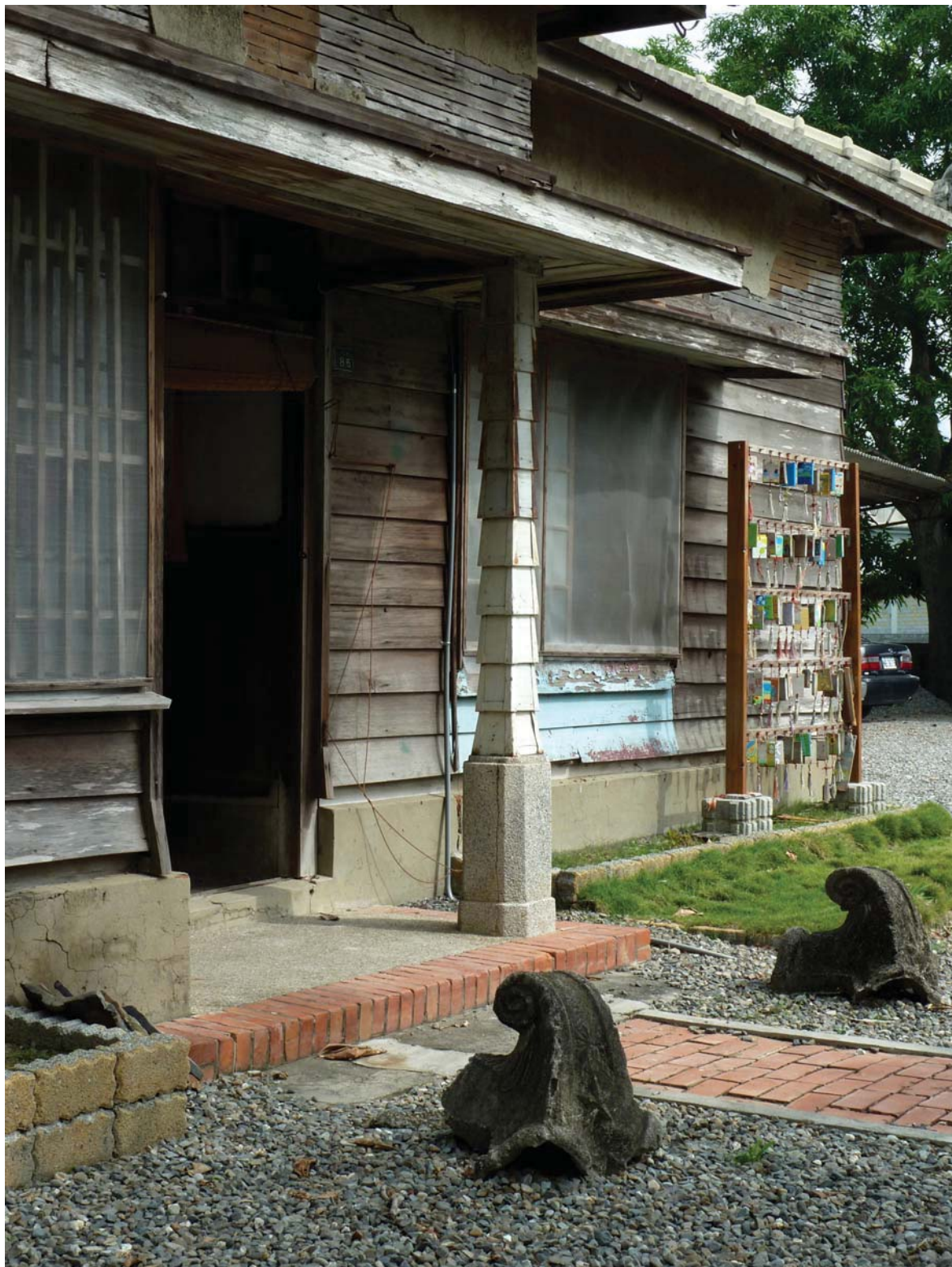
【7】校長宿舍西南角外觀現況照片
