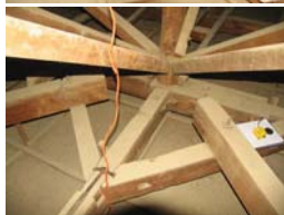
半架屋架搭接現況
