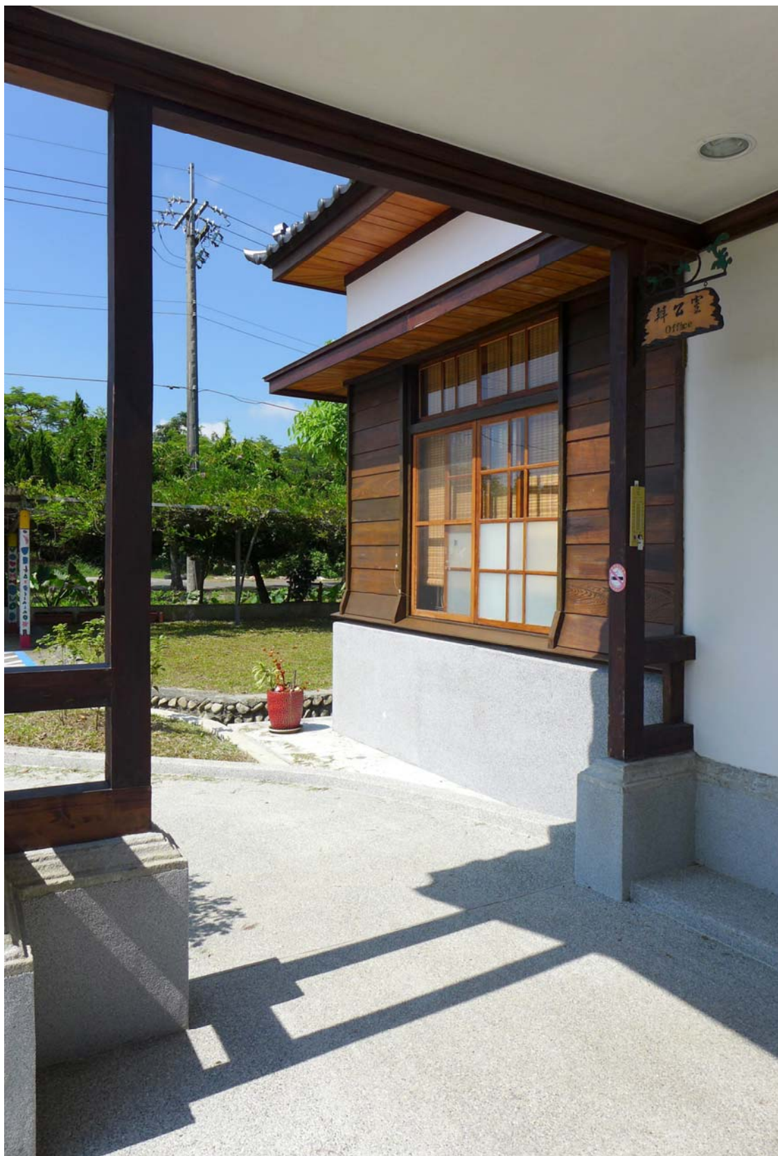
【7】木造辦公室修復後車寄外觀照片
