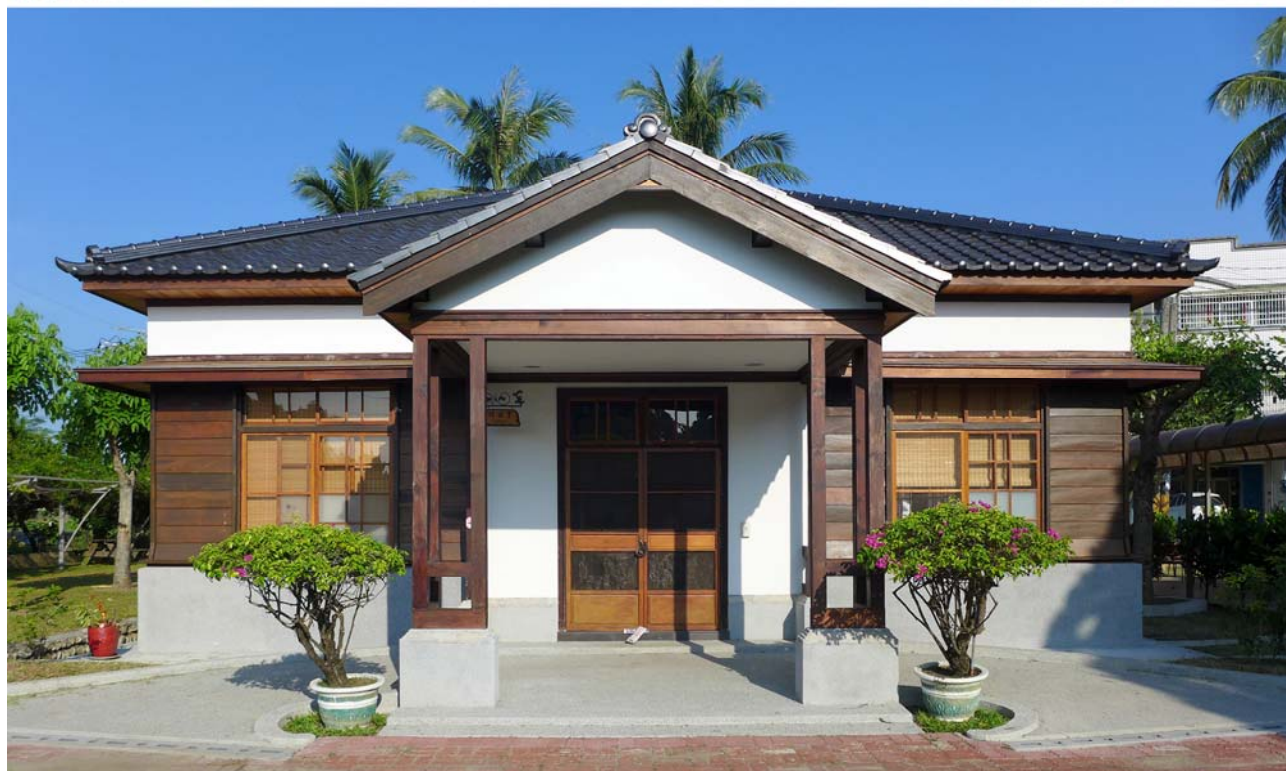
【14】木造辦公室東向外觀修復前後對照
