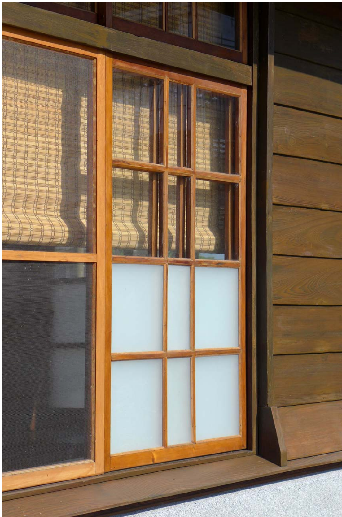
【11】木造辦公室修復後窗扇外觀照片
