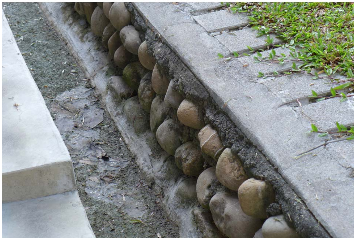
【13】木造辦公室修復後室內吊扇與犬走水溝照片
