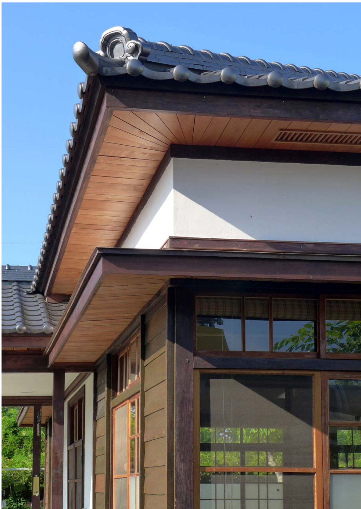
【9】木造辦公室修復後屋頂外觀照片
