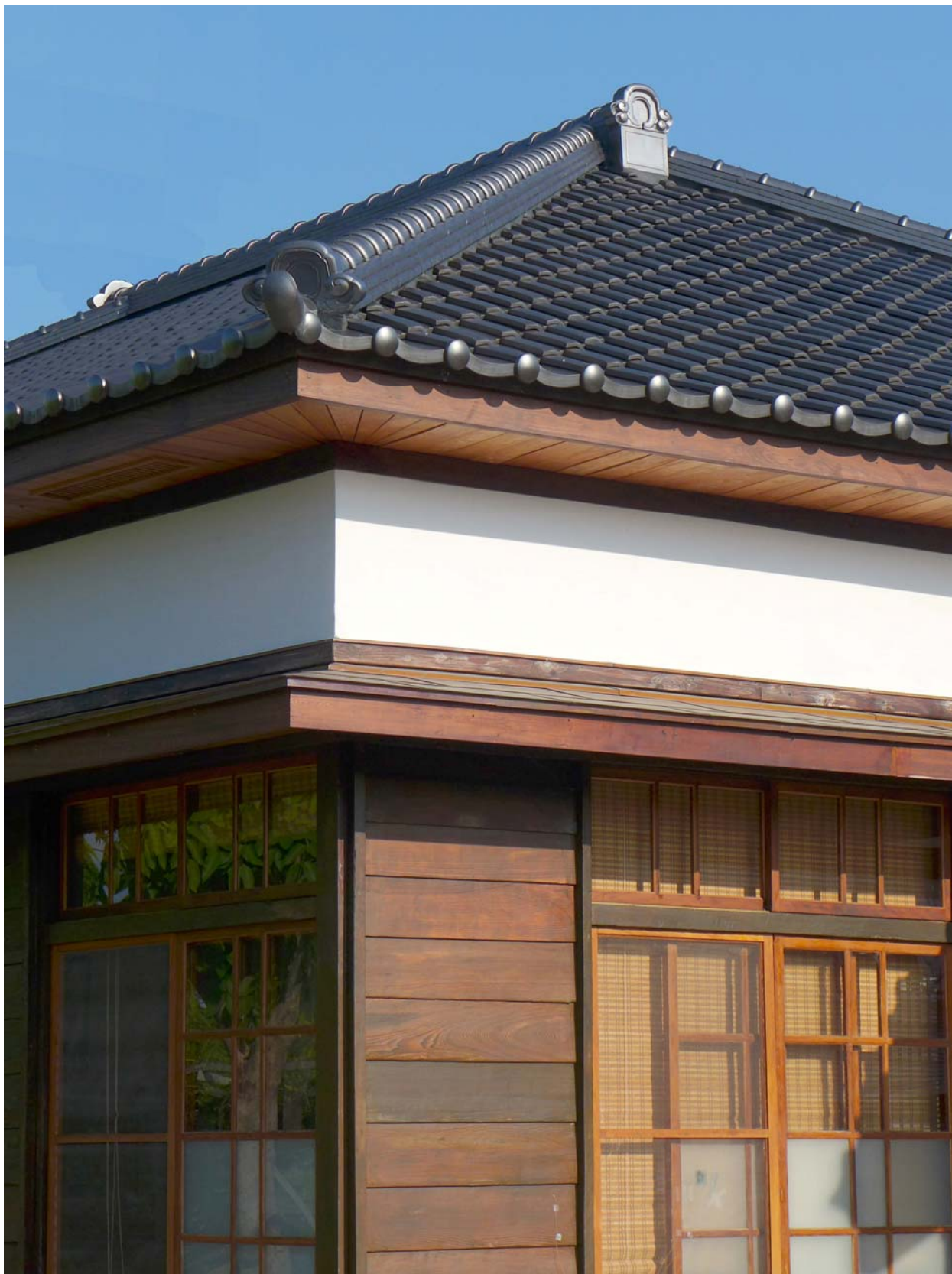
【8】木造辦公室修復後屋頂外觀照片
