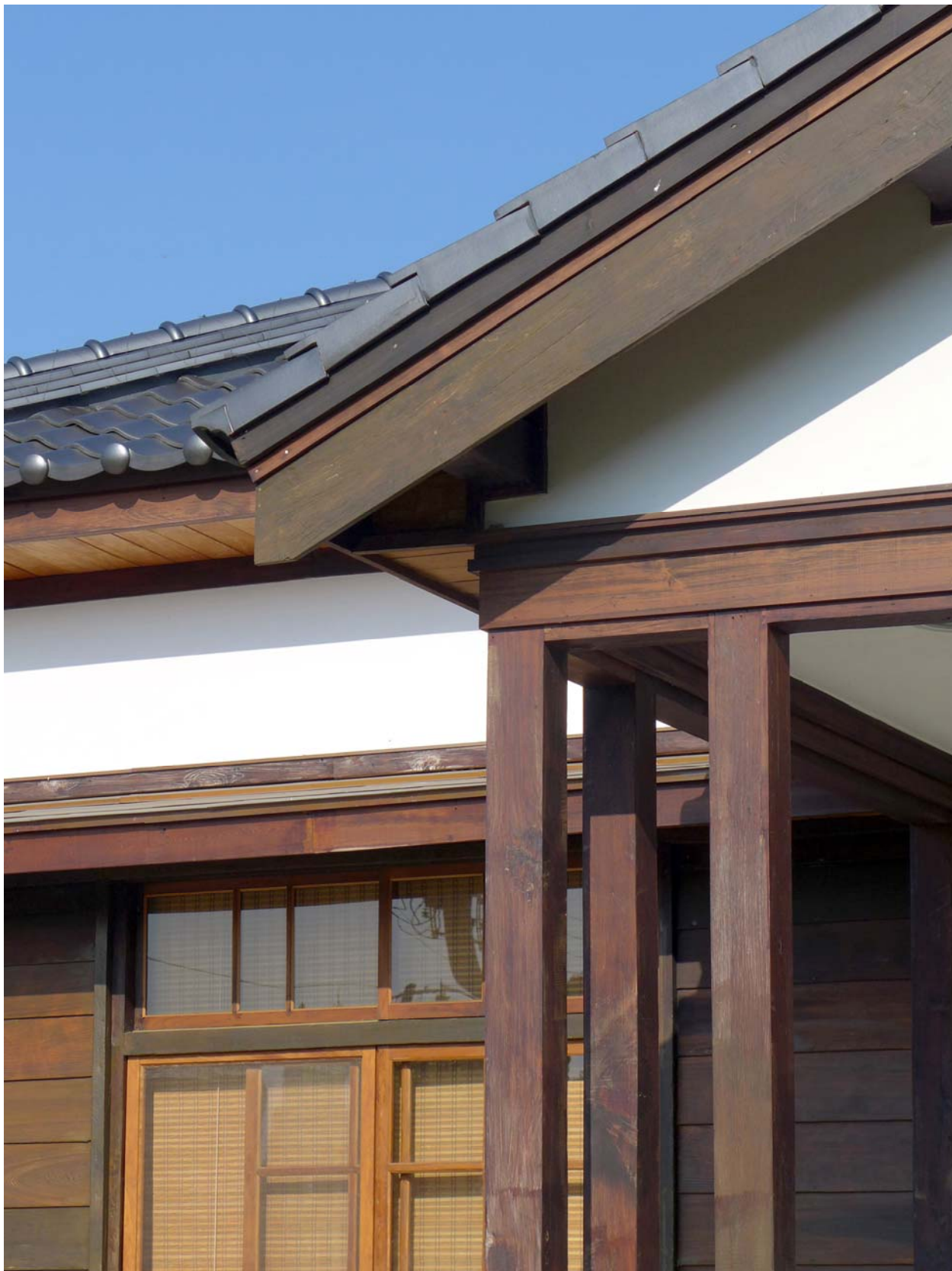
【6】木造辦公室修復後車寄外觀照片
