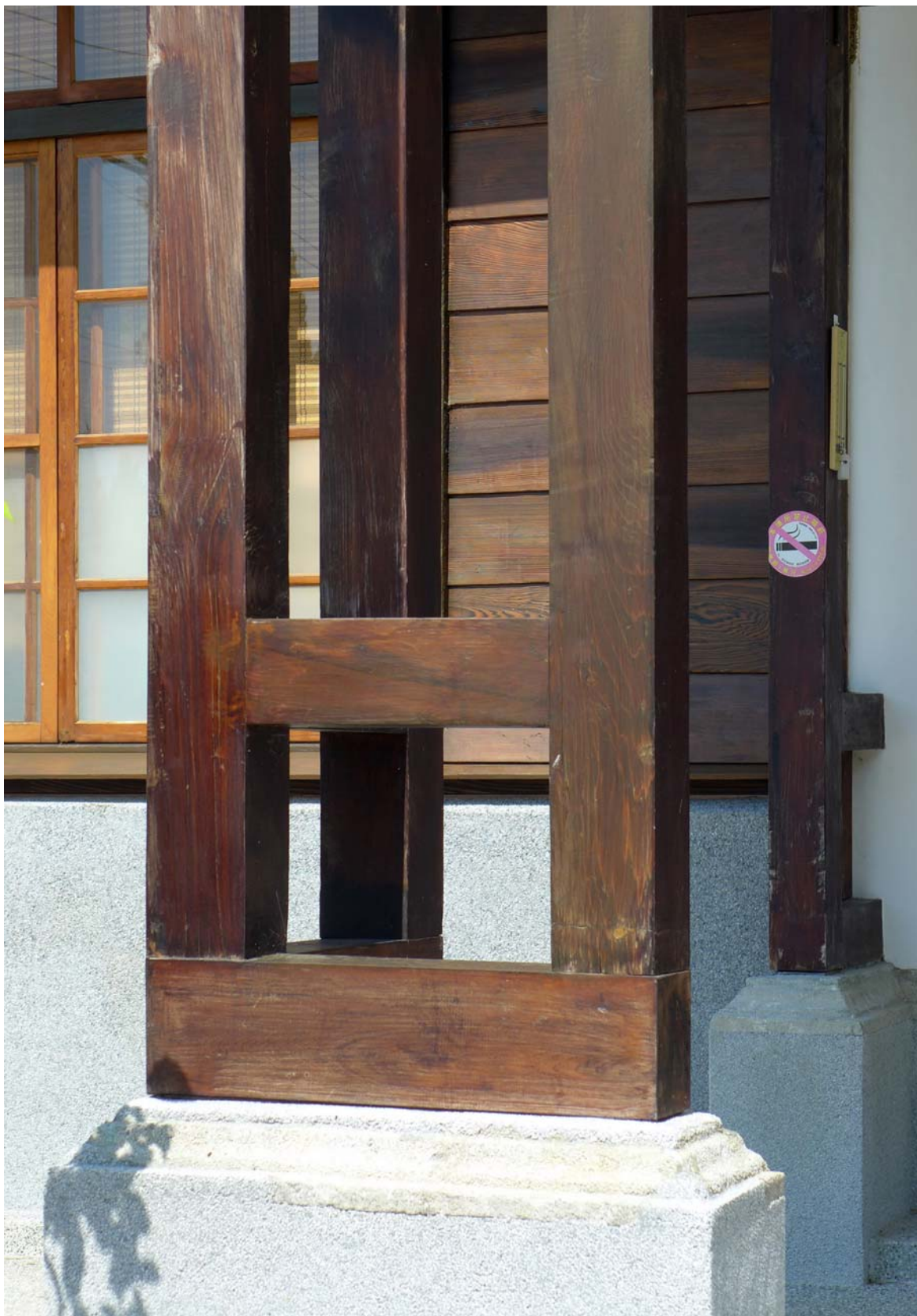
【10】木造辦公室修復後車寄軸組外觀照片
