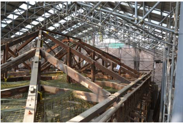
照片1-3-23 屋架施工中照片（1）。
