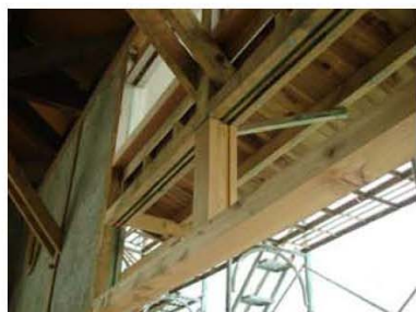
D. 橫樑（鴨居）及短吊木（吊束）仿作復原。
