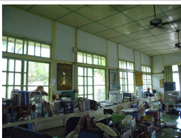
照片1-3-6修復前辦公室 1 軸組與牆體室內現況照片 (2)。
