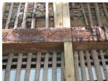
A. 以檜木屑與EPOXY拌和之材料進行修補。
