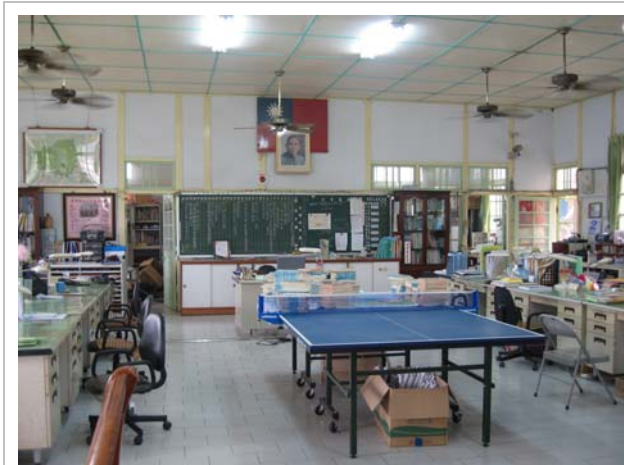
照片1-3-5修復前辦公室 1 軸組與牆體室內現況照片 (1)。
