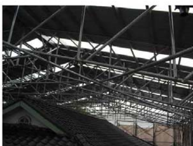
H. 組合鋼管桁架抗風拉桿。
