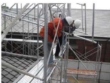
F. 鋼管桁架組立固定於施工鷹架上。
