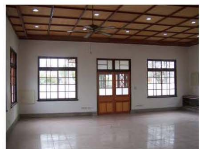
I. 木摺灰泥牆施作完成
