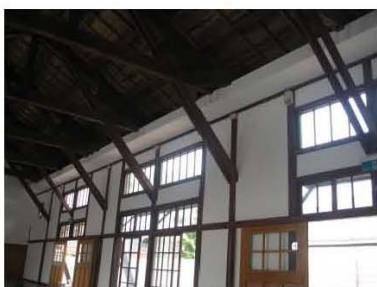
E. 編竹泥牆施作完成
