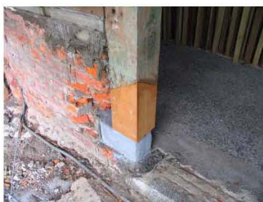
B. 先以臨時支撐撐住上方橫樑，再將損壞部位切除，回組新作之構件，隨後再卸除臨時支撐。
