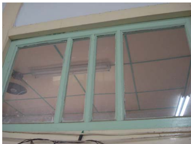
照片1-3-18 修復前辦公室室內木窗扇現況照片。
