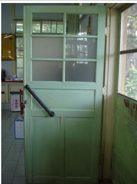
照片1-3-19 修復前辦公室 D1 木門扇現況照片。
