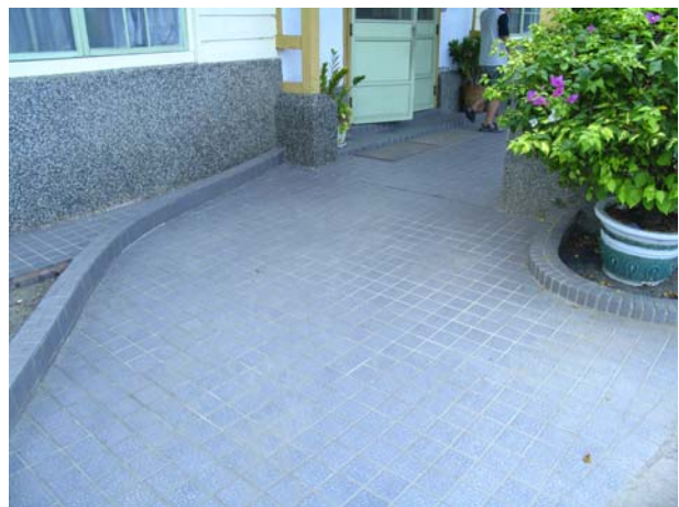
照片1-3-2 入口車寄地坪修復前照片。
