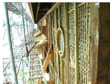
F. 軸組及雨淋板角材施作完成。
