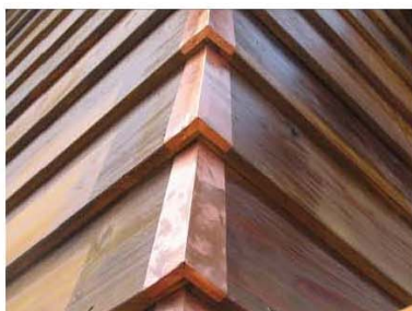
H. 雨淋板陽角包覆銅片。
