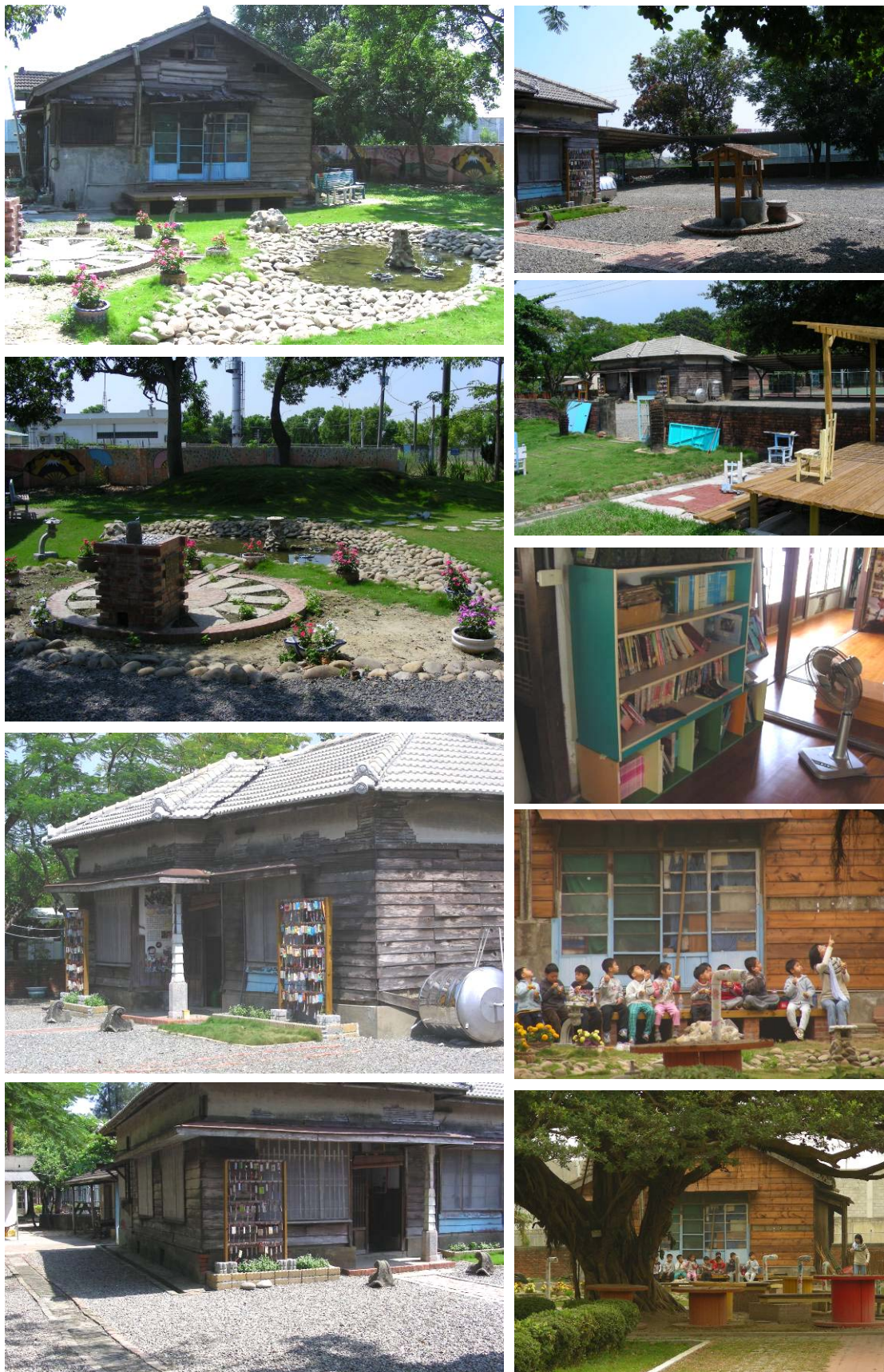
照片1-5-1 新東國小校長宿舍及教職員宿舍再利用現況
