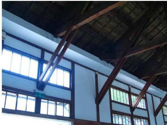
【開口橫樑修復後】
