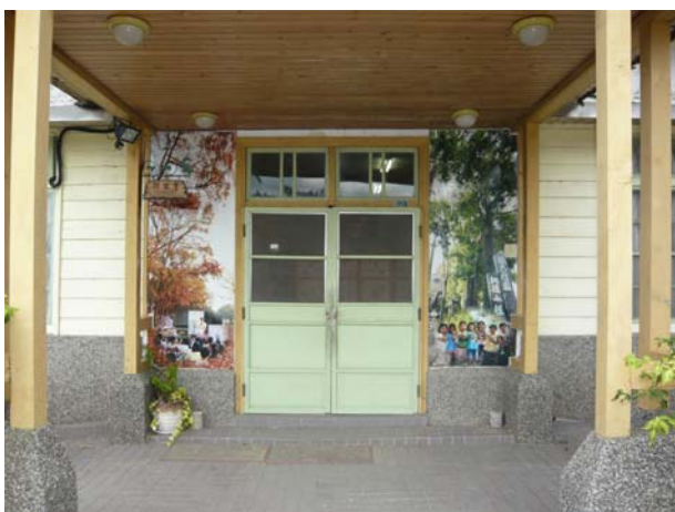
照片1-3-15 修復前辦公室 D1 木門扇現況照片。
