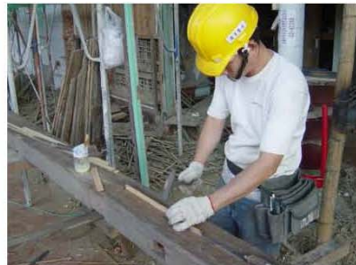
B. 軸組木料修補，裂縫大於3mm灌注EPOXY藥劑後再以木片填縫
