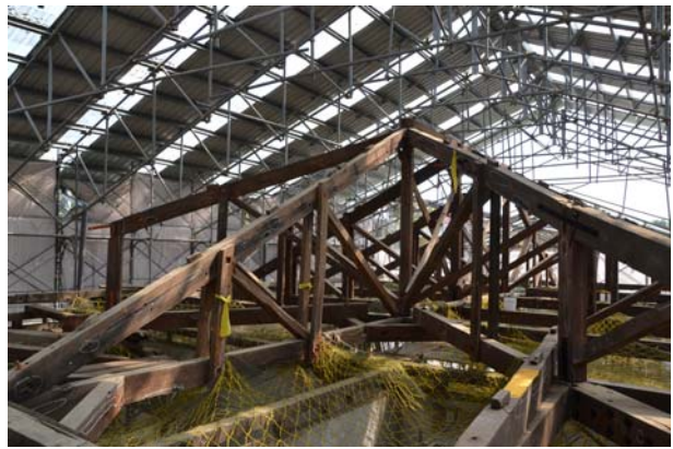
照片1-3-24 屋架施工中照片（2）。
