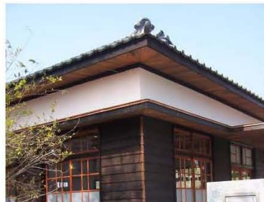
H. 木摺灰泥牆施作完成
