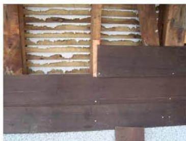
G. 雨淋板接續處以銅片進行背襯處理。
