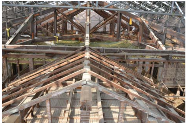
照片1-3-26 車寄屋架施工中照片（2）。
