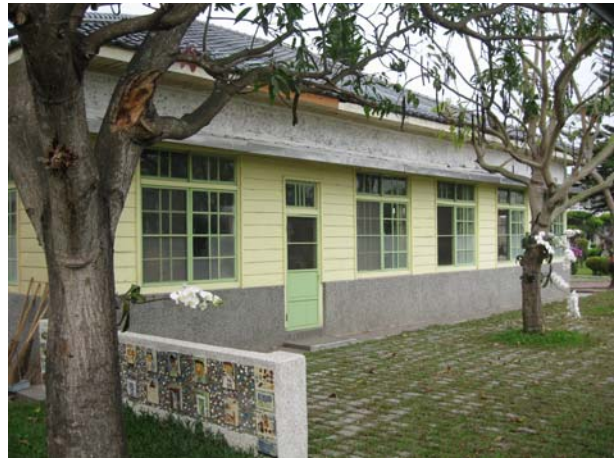
照片1-3-10 修復前辦公室外牆現況照片。
