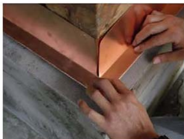
E. 基牆泛水銅片施作。
