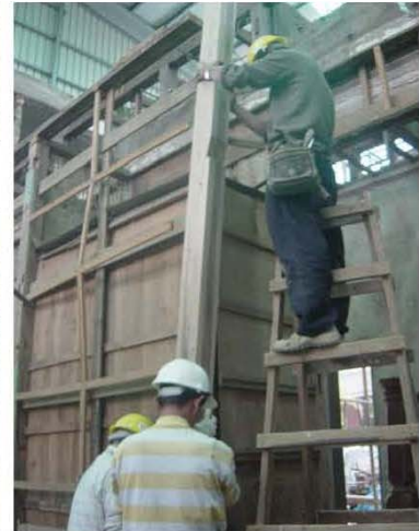
E. 軸組立柱抽換組立
