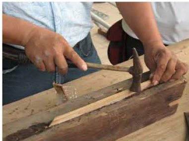
◆將填縫用木料塞入裂縫內，以鐵槌加壓使其緊密，靜置待藥劑固化
