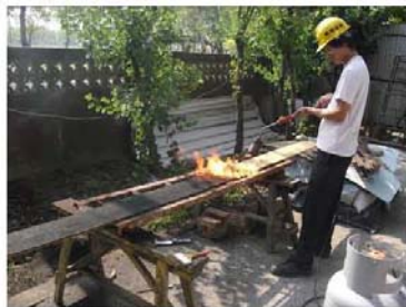
A. 雨淋板表面碳化處理。
