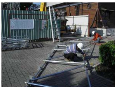
D. 組合鋼管桁架，於地地下先行將桁架組裝完成。
