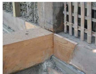
C. 以檜木板及EPOXY修補。
