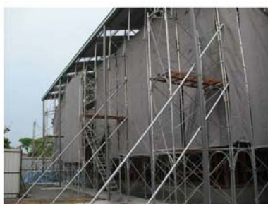
I. 保護棚架組立完成。
