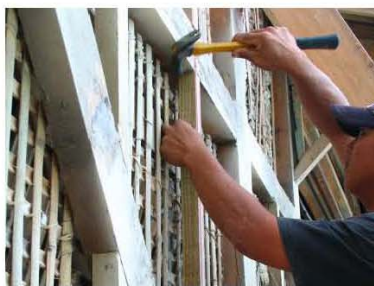
E. 外牆雨淋板角材全面新作。
