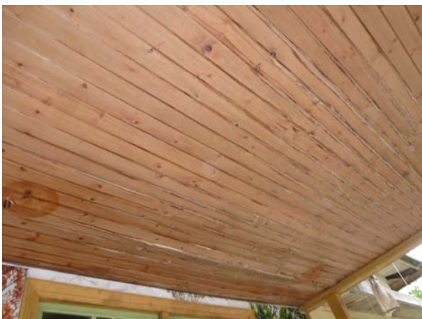
照片1-3-13 修復前辦公室車寄天花現況照片。
