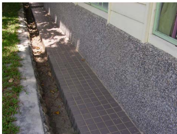
照片1-3-4犬走修復前現況照片。
