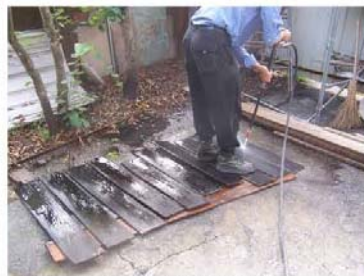
C. 再以高壓水注進行沖洗。
