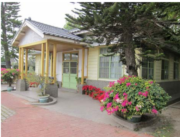
照片1-3-1 入口車寄修復前照片。
