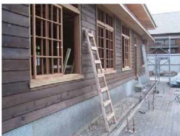
I. 外牆雨淋板施作完成
