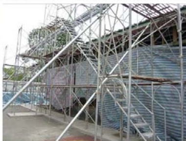
B. 鋼管鷹架組立。
