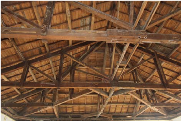
照片1-3-21 屋架修復前現況照片（1）。
