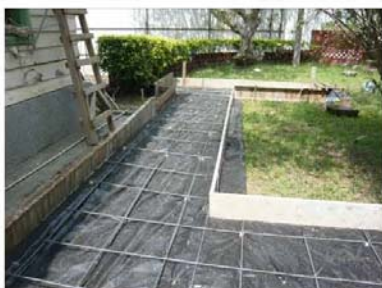
A. 保護棚架基座施作。
