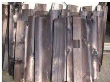
D. 置放乾燥後再進行回鋪施作。
