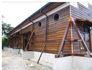
I. 雨淋板修復完成。
