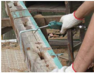
A. 以空氣壓送機將木料裂縫處進行木構件清理
