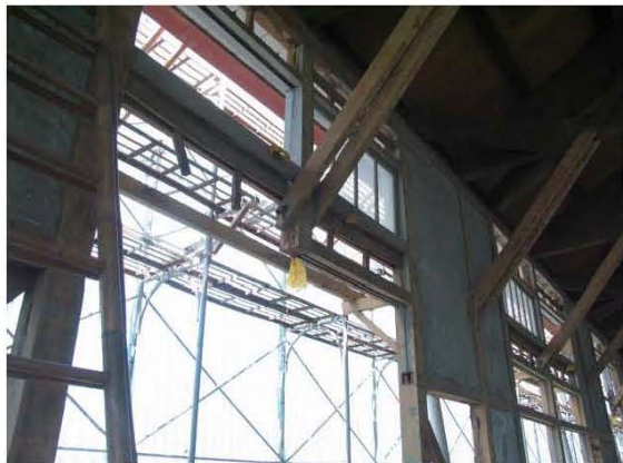
【開口橫樑修復前】
