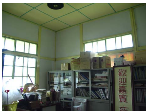
照片1-3-8修復前儲藏室軸組與牆體室內現況照片。
