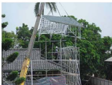
E. 鋼管桁架吊裝施作，先於地地下組裝三組為一單元，共計吊裝四次。
