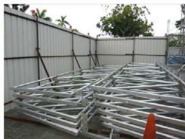
C. 組合鋼管桁架材料進場，材料為工廠加工組立完成。
