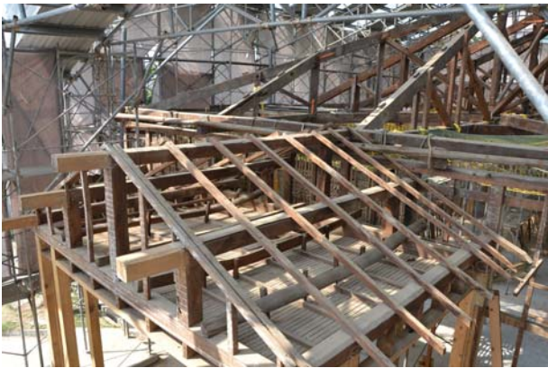
照片1-3-25 車寄屋架施工中照片（1）。
