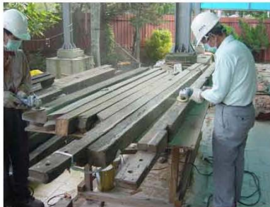
C. 藥劑固化後，將填補後多餘木料刨除，以電動圓磨機細磨木構件修補處
