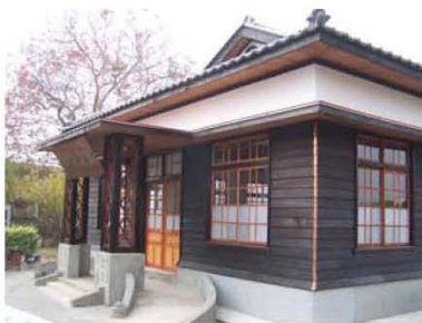
G. 木摺灰泥牆施作完成
