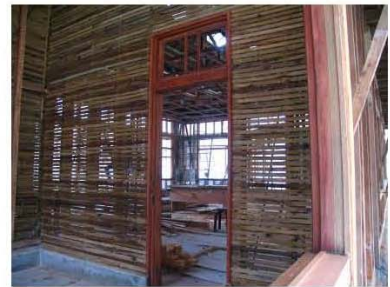
C. 牆體木摺條施作完成
