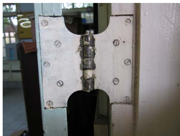
照片1-3-32 辦公室 D1 木門扇五金修復前現況照片。
