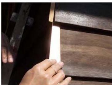
H. 雨淋板陽角以銅片進行包覆施作。
