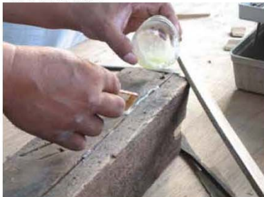
◆將EPOXY藥劑注入裂縫內
