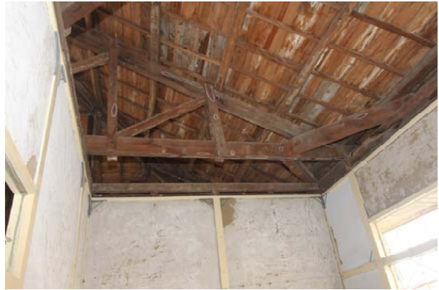
照片1-3-22 屋架修復前現況照片（2）。
