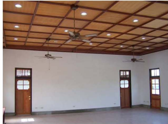
【木摺灰泥牆修復後】
