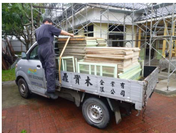
照片4-1-9 門窗扇編碼後整理運送至工廠進行剝漆作業 (1)。
