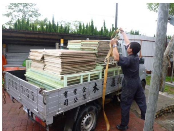
照片4-1-10 門窗扇編碼後整理運送至工廠進行剝漆作業 (2)。
