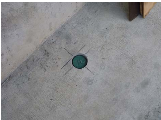
照片4-4-19 地下型餌站置放入原先鑽孔位置，共計 8 處。
