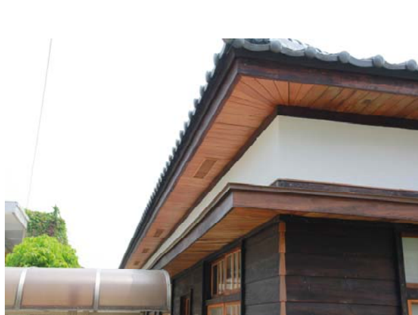
照片4-2-26 新增橫流排風口安裝施作後情形。
