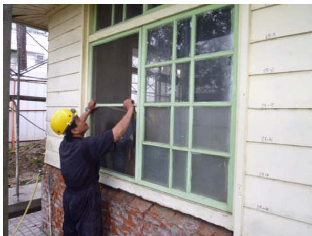
照片4-1-7 修復前窗扇進行拆卸，待剝漆作業。
