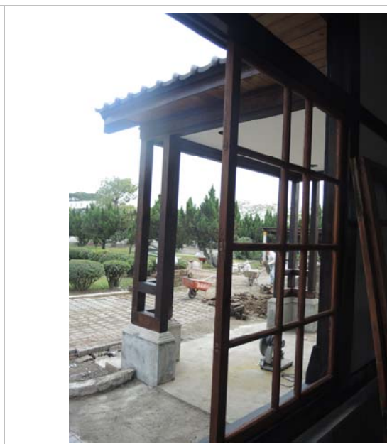
照片4-1-22 窗扇試安裝情形。
