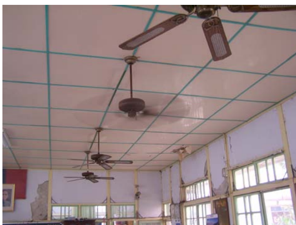
照片4-2-1 木造辦公室天花板修復前情形。
