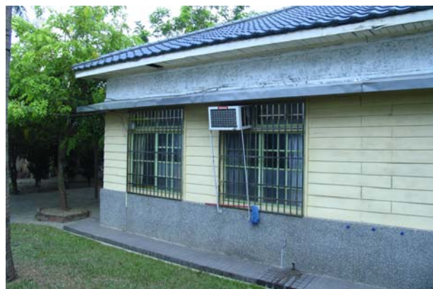
照片4-1-33 西向窗扇修復前照片。
