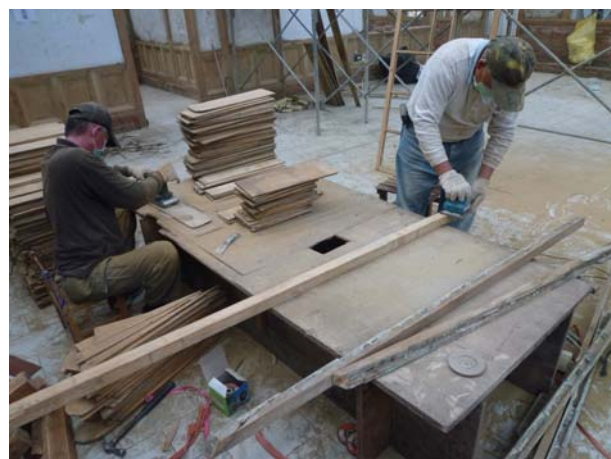
照片4-2-16 天花骨料剝漆施作。
