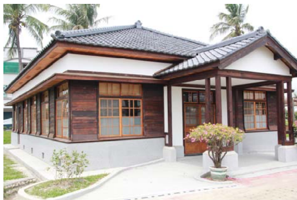
照片4-1-32 南向窗扇修復後照片。
