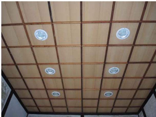
照片4-2-22 儲藏室天花設計為4分夾板貼0.2mm檜木(台檜)皮新作,天花角材竿緣為原有天花收邊桷材去漆後留用。
