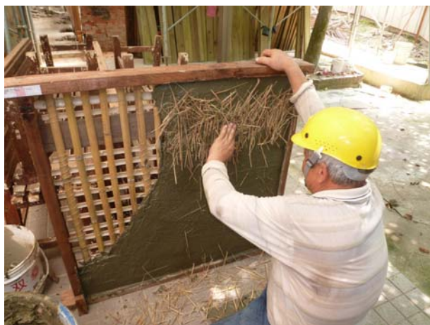
照片4-4-21 鄉土教學展示牆面施作，照片為編竹夾泥牆尺寸為 100×100cm。
