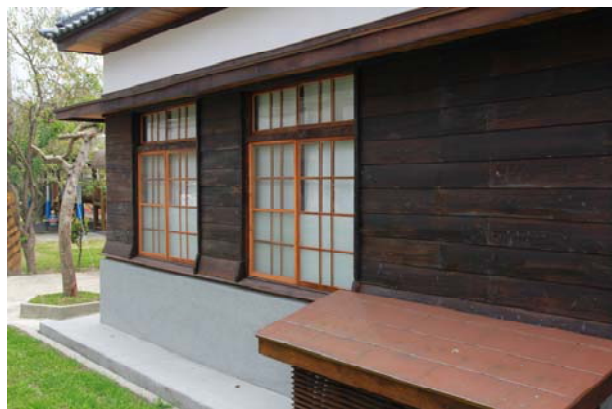
照片4-1-34 西向窗扇修復後照片。
