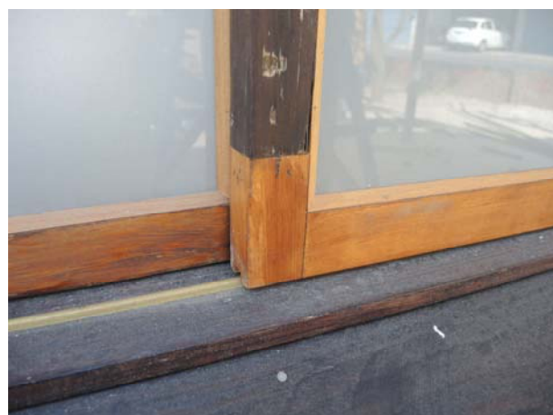
照片4-1-24 窗扇新舊料修復完成後情形。
