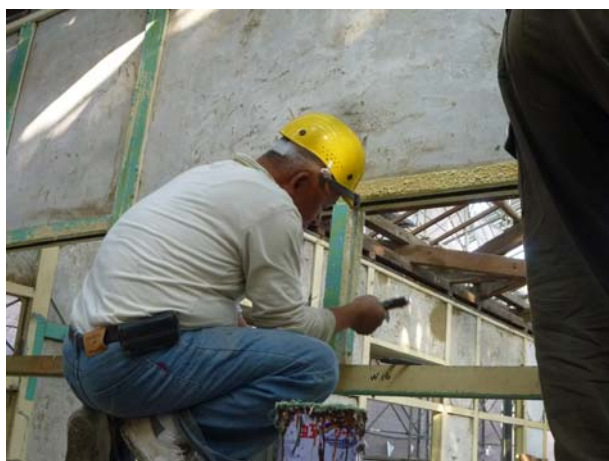
照片4-1-11 使用剝漆劑進行門窗框漆料剝離。
