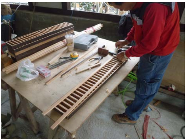
照片4-2-25 封簷天花新增橫流排風口,照片為施作過程。
