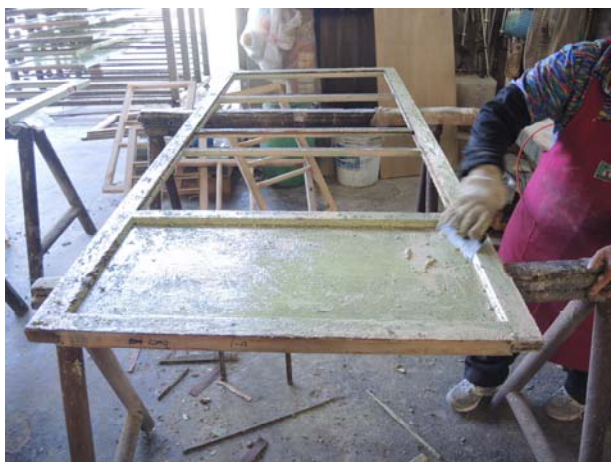
照片4-1-15 門扇於工廠進行剝漆施作。
