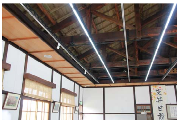
照片4-2-40 辦公室1天花修復後照片(2)。
