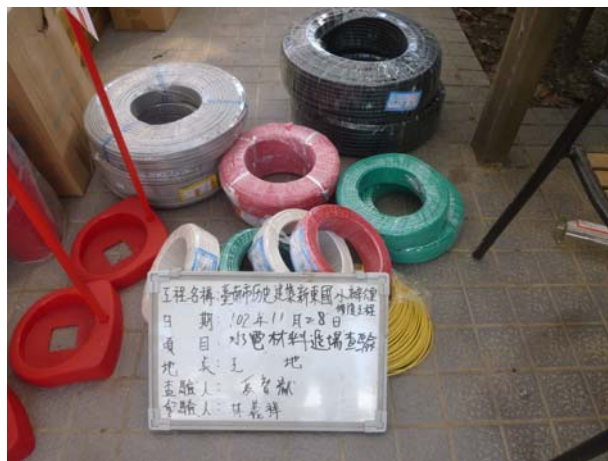
照片4-3-8 本案電器線路與消防設備材料進場查驗。
