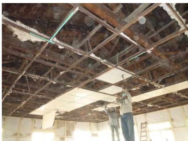
照片4-2-7 以手工方式進行木夾板拆除。
