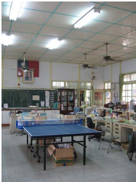
照片4-2-33 辦公室 1 天花修復前照片 (1)。
