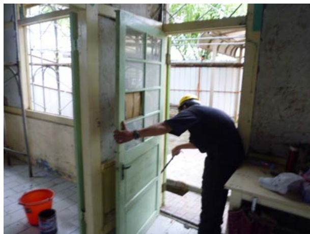
照片4-1-8 修復前門扇進行拆卸，待剝漆作業。
