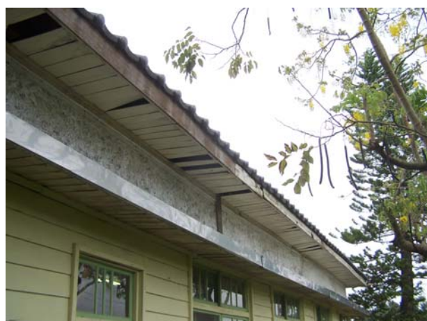
照片4-2-5 封簷天花修復前情形，局部木板損壞佚失。
