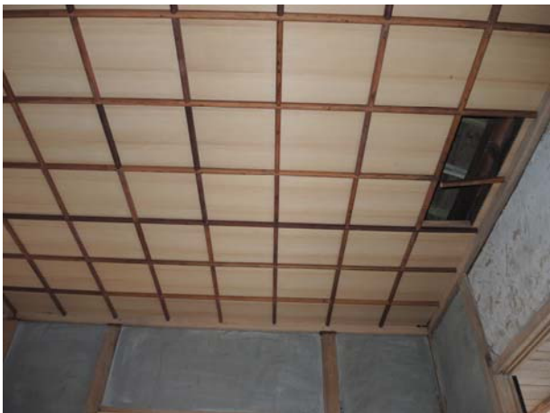
照片4-2-21 辦公室2 天花設計為4分夾板貼0.2mm檜木(台檜)皮新作,天花角材竿緣為原有天花收邊桷材去漆後留用。
