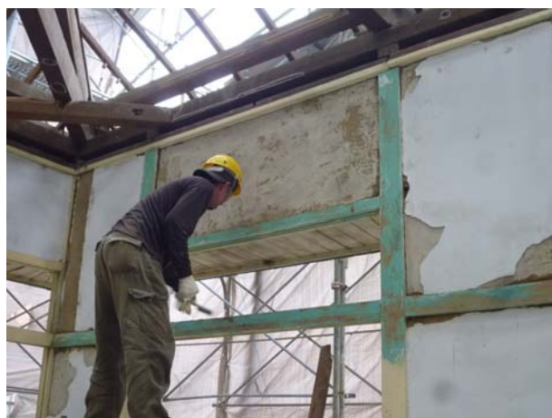
照片4-1-12 剝離後以刮刀進行刮除作業 (1)。
