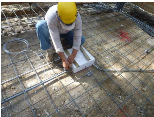
照片4-3-7 本案設計地板插座，於地坪施作時將管線進行預埋施作。
