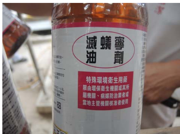
照片4-4-5 本案全區防蟲噴塗採滅蟻寧油劑。
