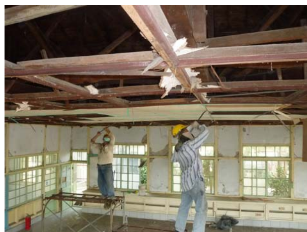
照片4-2-8 拆除後可見原天花骨料。
