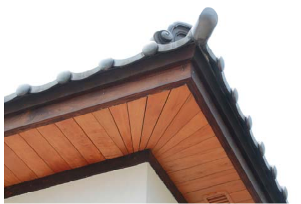
照片4-2-42 封簷天花修復後照片(1)。
