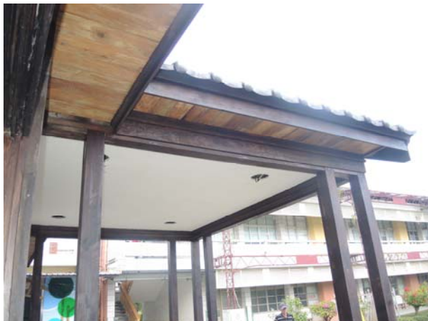
照片4-2-32 車寄木摺天花，面塗白灰層施作完成。
