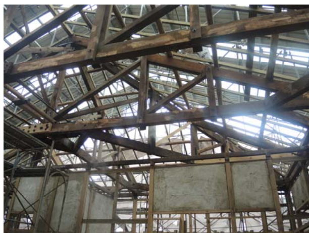
照片4-4-14 屋架防蟲蟻噴塗完成。
