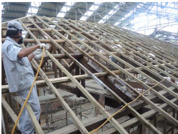
照片4-4-12 屋架噴塗作業。
