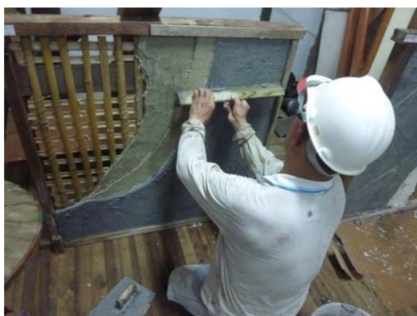
照片4-4-23 依每層進行斷面呈現施作。
