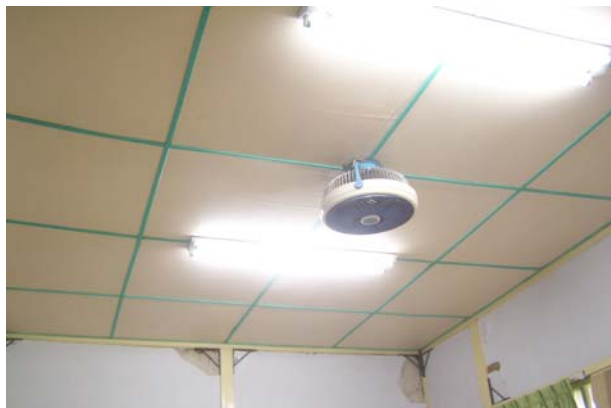
照片4-3-4 木造辦公室 2 修復前室內照明設備。
