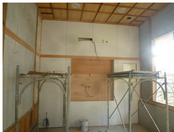
照片4-3-16 電視牆體及電氣櫃體施作完成。
