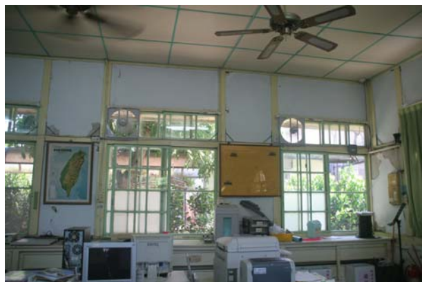
照片4-3-3 木造辦公室 1 修復前室內電器設備。
