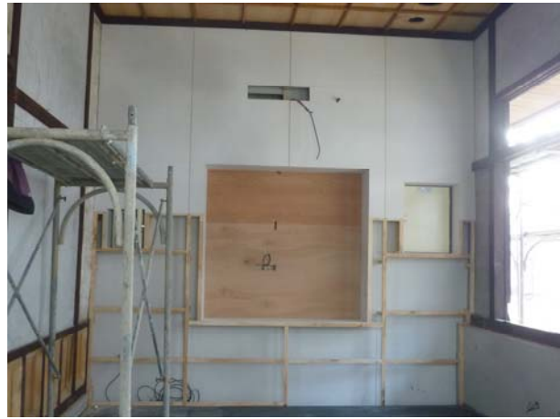
照片4-4-26 埋入式電視牆體施作。
