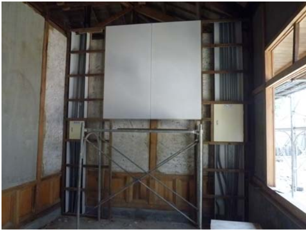
照片4-4-25 牆體兩側施作電器箱與設備箱體。
