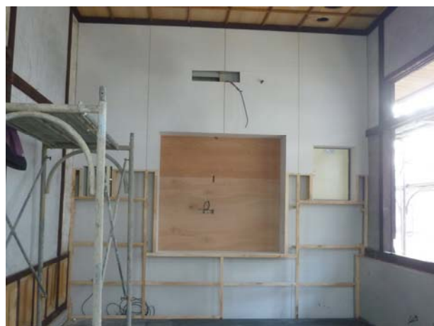
照片4-3-15 辦公室埋入牆體電視牆體施作，骨架面層施作矽酸鈣板牆板。
