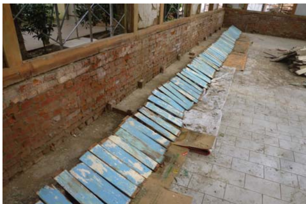
照片4-2-14 封簷天花板進行剝漆作業。
