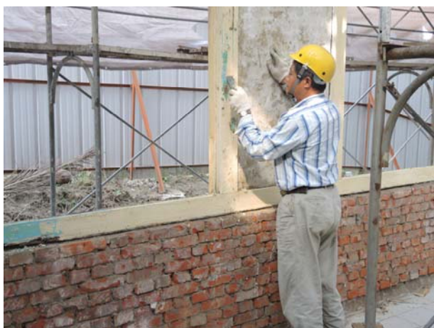
照片4-1-13 剝離後以刮刀進行刮除作業 (2)。
