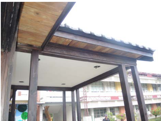
照片4-2-23 車寄封簷天花為原有木料去漆後進行回鋪施作。
