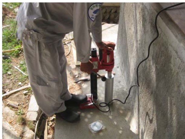
照片4-4-18 於犬走施作地下型餌站。
