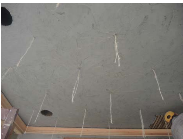
照片4-2-29 底塗灰漿塗抹施作並施作麻絨以防止面塗白灰龜裂。
