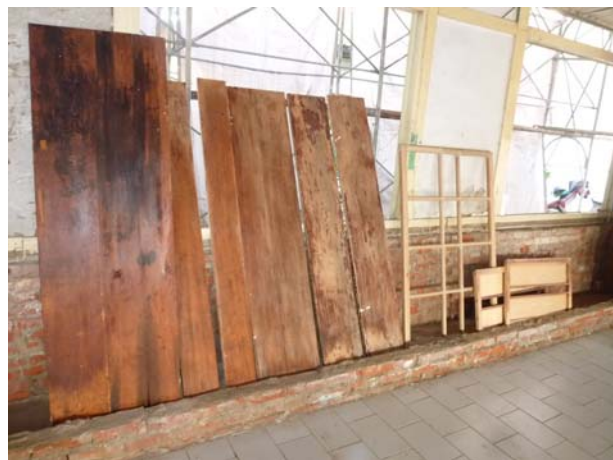
照片4-4-28 櫃體面板木料去漆完成。
