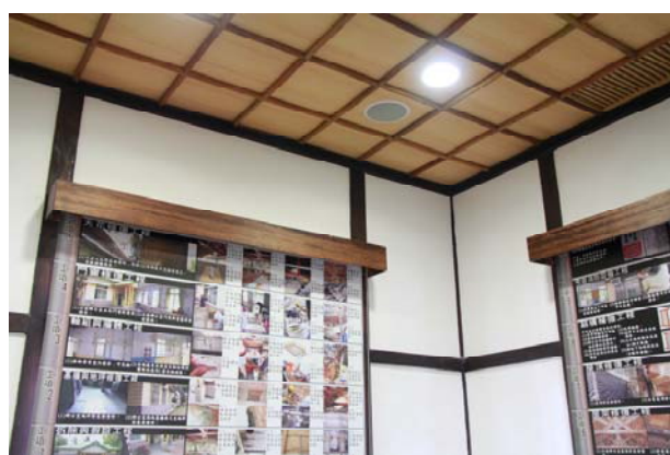
照片4-2-38 儲藏室天花修復後照片。
