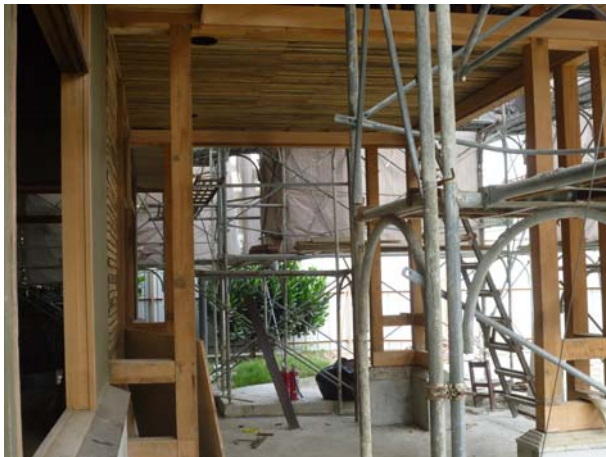
照片4-2-27 車寄天花新作，恢復原木摺天花型式。
