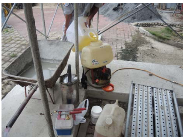
照片4-4-9 將藥劑倒入噴霧機器設備內。
