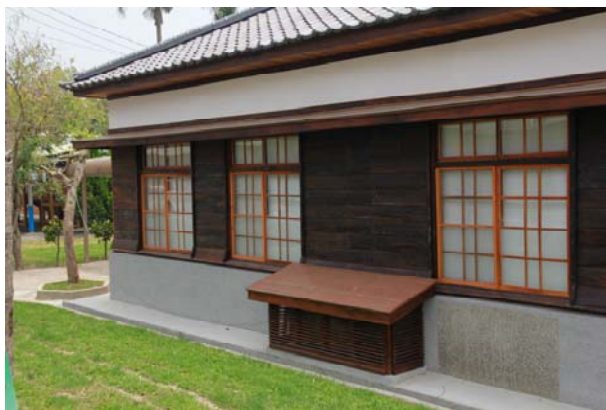
照片4-3-20 空調室外機小屋施作完成。
