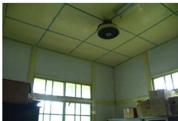
照片4-2-37 儲藏室天花修復前照片。
