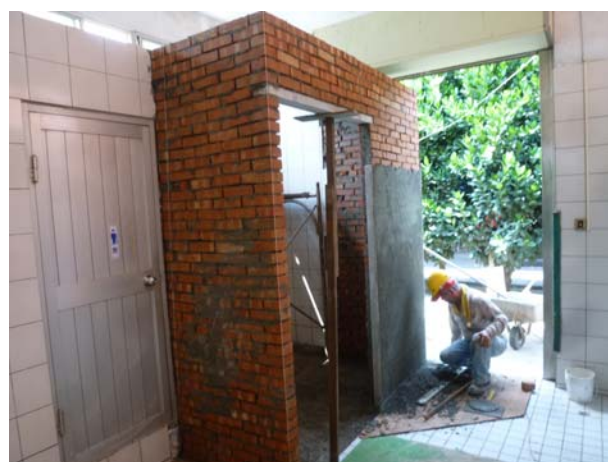
照片4-4-24 現有廁所部分改建為無障礙廁所。
