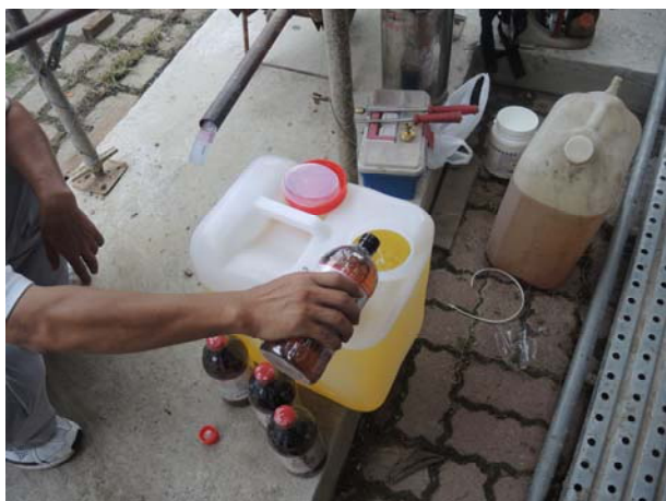
照片4-4-8 依比例進行拌和。
