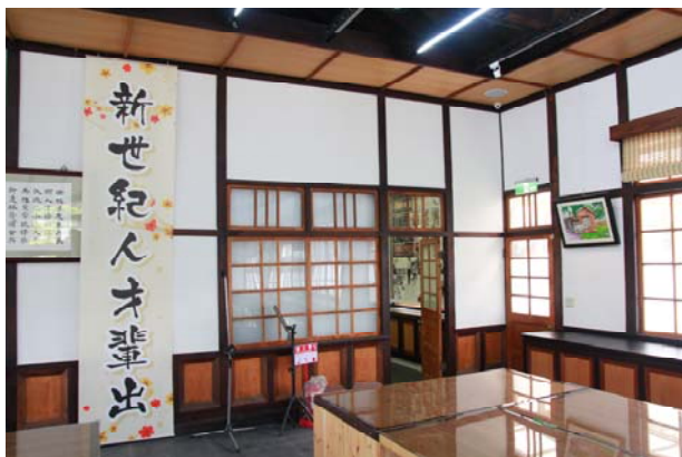
照片4-3-19 木造辦公室消防設備設置後情形。
