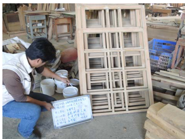
照片4-1-19 窗扇剝漆後查驗情形 (1)。
