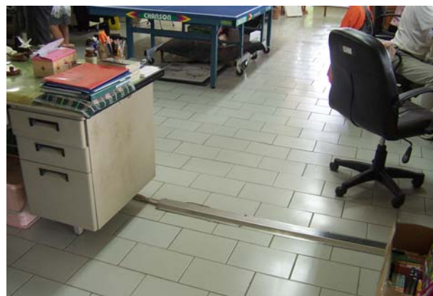
照片4-3-6 線路固定於地板情形。
