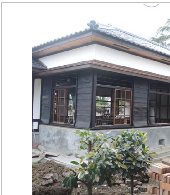
照片4-1-21 窗扇銅製軌道及窗扇試安裝。
