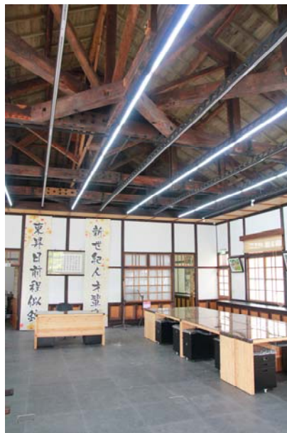
照片4-2-34 辦公室 1 天花修復後照片 (1)。
