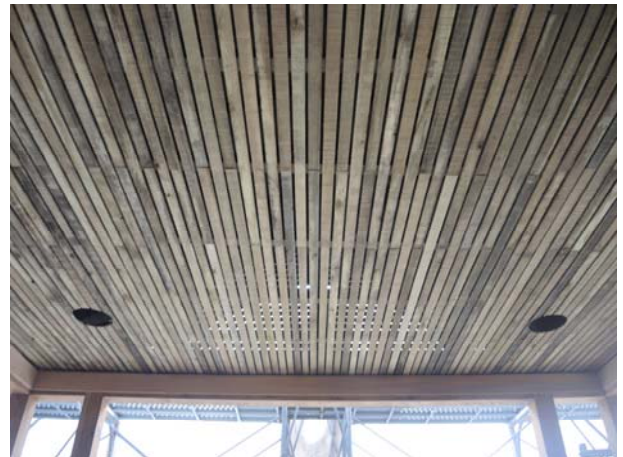
照片4-2-28 木摺條釘著施作完成。
