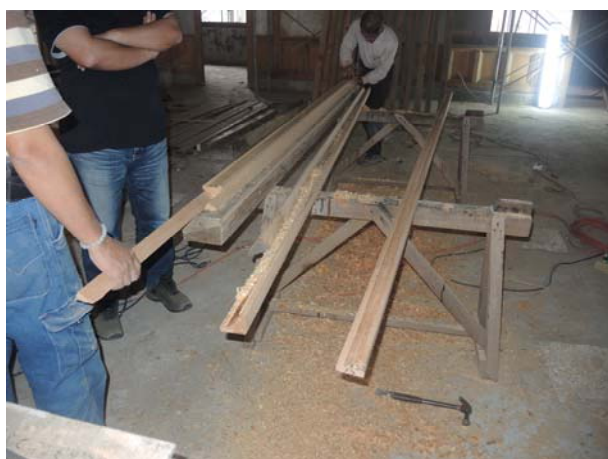
照片4-2-17 天花角材(竿緣)新作。
