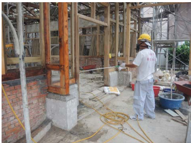
照片4-4-11 軸組噴塗作業。
