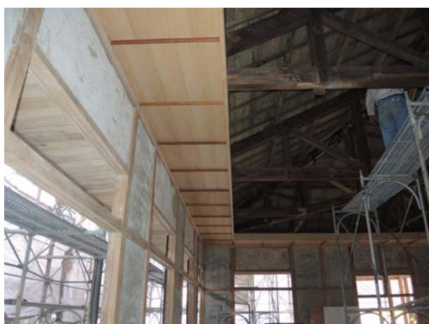
照片4-2-19 辦公室 1 天花設計為露明屋架，周圍以 4 分夾板貼 0.2 mm 檜木(台檜)新作。
