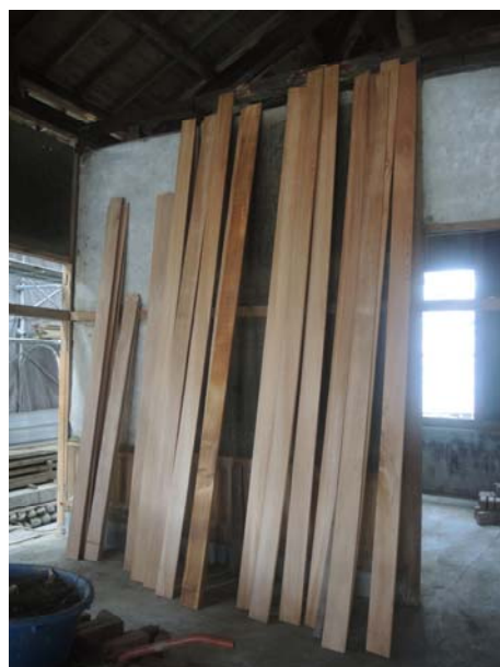
照片4-2-18 天花板材 4 分夾板貼 0.2 mm 檜木(台檜)皮新作，於工廠製作後運至工地現場待進行鋪設。
