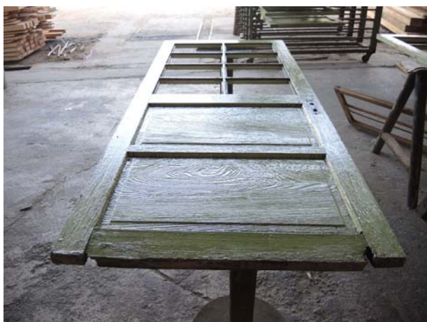
照片4-1-17 門扇剝漆施作情形。
