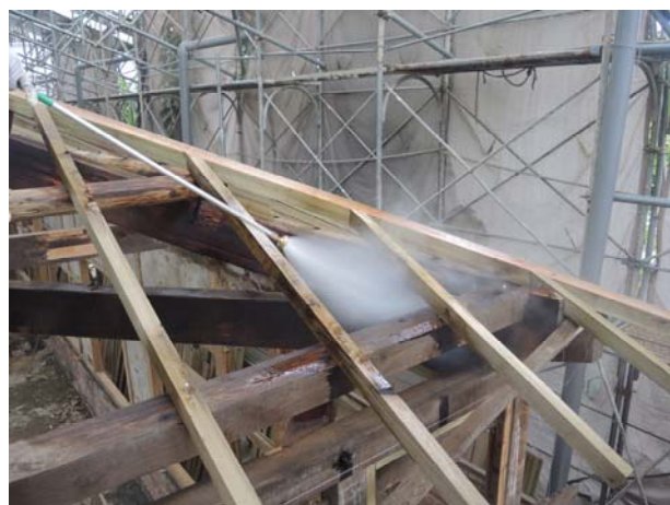
照片4-4-13 屋架角隅噴塗作業。
