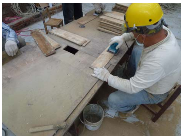
照片4-2-15 以手動研磨機進行磨平施作。
