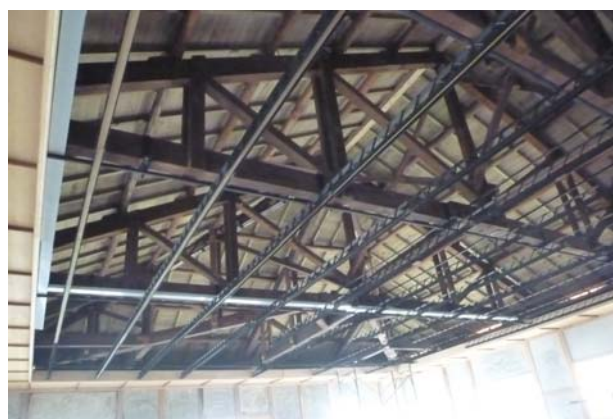
照片4-3-11 室內燈具施作完成。
