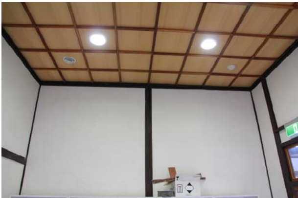
照片4-2-36 辦公室 2 天花修復後照片。
