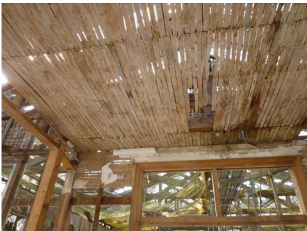
照片4-2-11 車寄天花板拆卸後，可見原構造為木摺天花型式。
