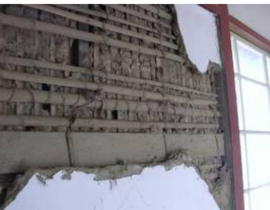
【圖7.2.4】土壁崩落破壞
