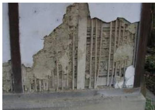
【圖7.2.2】灰泥粉刷開裂及剝離破壞
