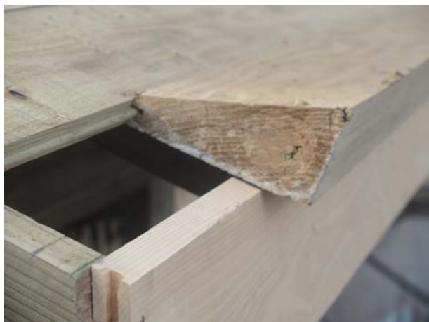
照片3-5-37 廣小舞施作，本次修復施作廣小舞先施作企口再配合屋面板一併接續。詳細尺寸詳右圖所示。
