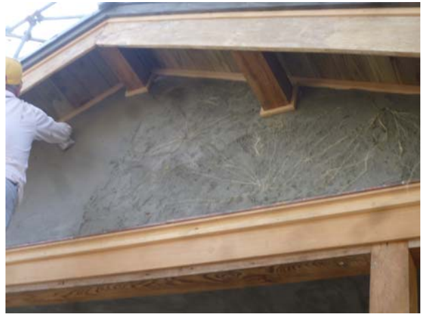
照片3-3-84 入口車寄山牆面施作。
