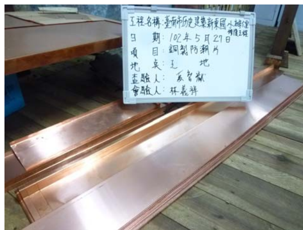
照片3-3-20 檻木底層防潮用 0.4mm 銅片進場查驗 (照片拍攝日期: 2013/5/27)。
