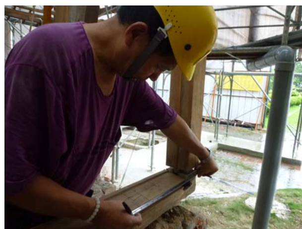
照片3-3-18 燕尾樑接續施作放樣情形 (2)。
