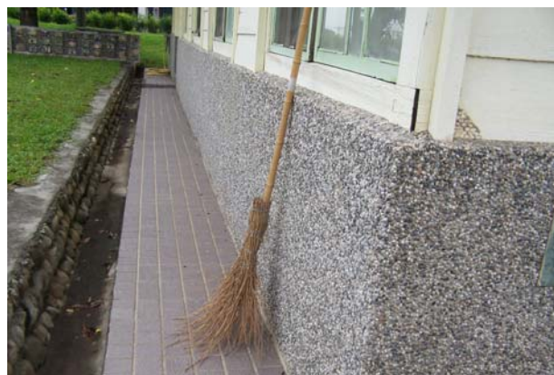
照片3-2-59 南向犬走修復前情形。
