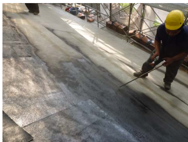
照片3-5-44 依序開始施作第二層以上油毛氈防水層。
