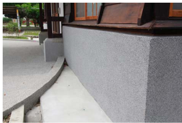
照片3-2-62 東向犬走修復後情形。
