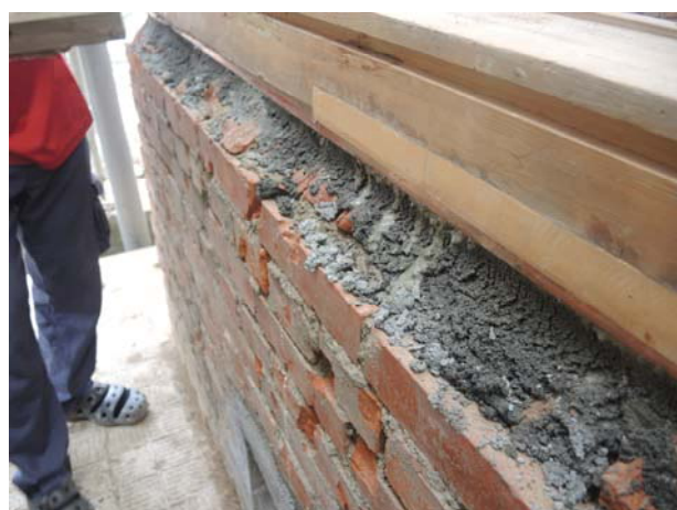
照片3-3-29 檻木底層銅片阻潮施作完成後 1 (照片 拍攝日期：2013/7/14)。
