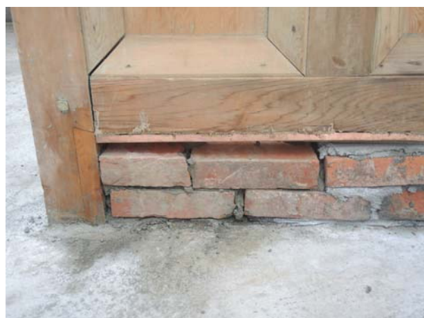
照片3-3-31 內隔間牆檻木底層銅片阻潮施作完成後 1 (照片拍攝日期：2013/7/20)。
