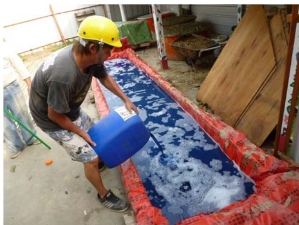
照片3-3-56 底層以塑膠帆布鋪設。藥劑使用後再收集於容器內，轉交給 ACQ 處理廠商代為處理。
