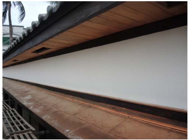
照片3-3-86 面塗白灰層施作完成。
