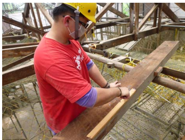
照片3-4-26 以木料加 EPOXY 進行損壞處填補修復 (2)。
