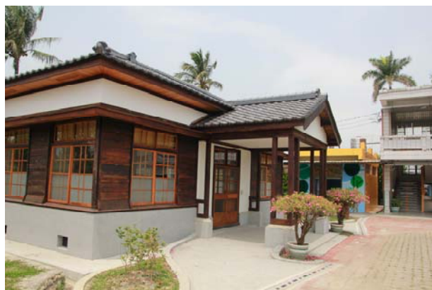
照片3-5-79 屋頂修復後照片 (3)。
