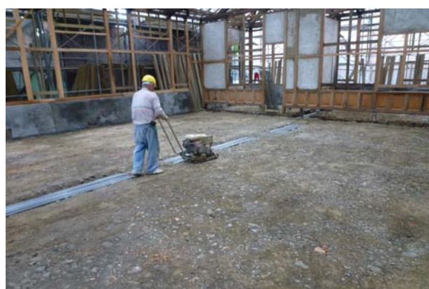
照片3-2-35 地坪進行夯實作業。
