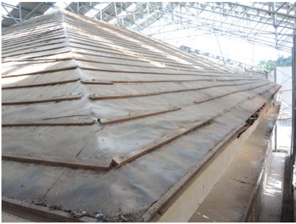
照片3-5-15 屋瓦拆卸後可見屋面防水層及掛瓦條。
