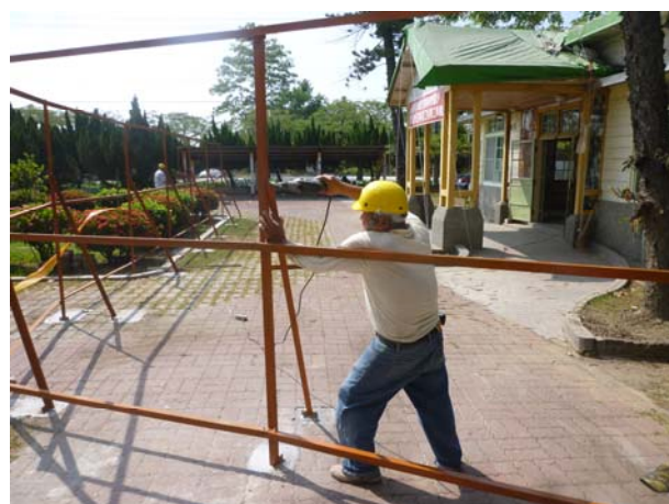
照片3-1-24 甲種圍籬角鋼施作。
