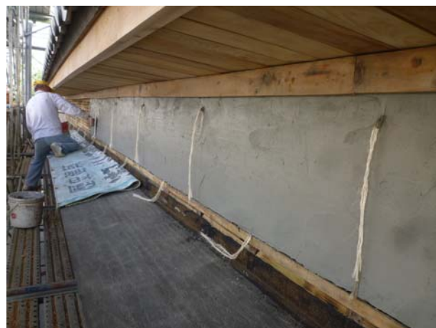
照片3-3-82 麻絨施作情形。
