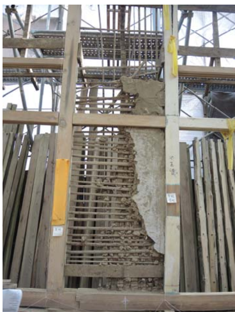
照片3-3-61 內牆編竹夾泥牆損壞處拆卸情形。
