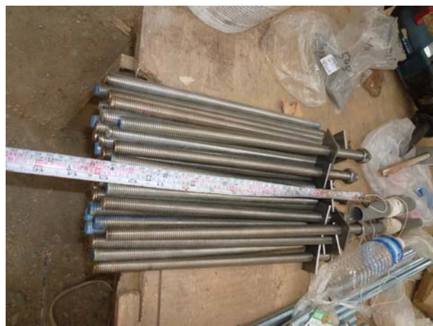
照片3-6-20 M16 化學螺栓進場 (2)。
