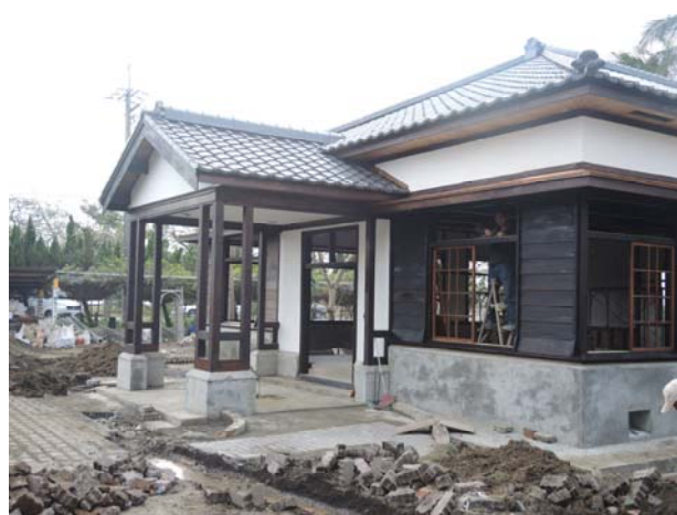
照片3-2-47 將原有車寄磁磚地坪鑿除。
