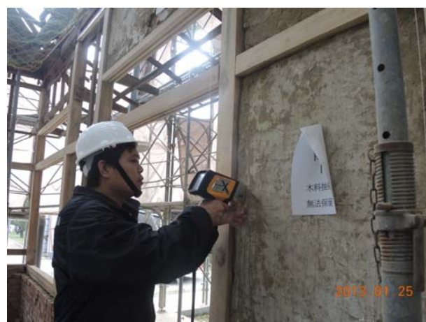
照片3-3-44 原牆體配比分析進行取樣施作。
