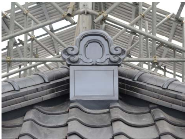
照片3-5-63 辦公室主體建築物正脊大鬼瓦頭施作完成。
