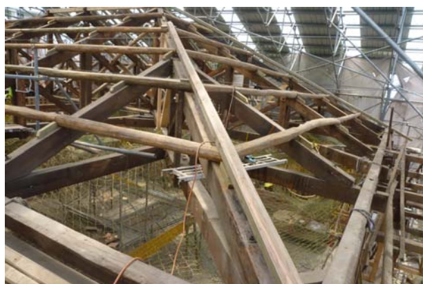
照片3-4-64 屋架修復後照片 (3)。
