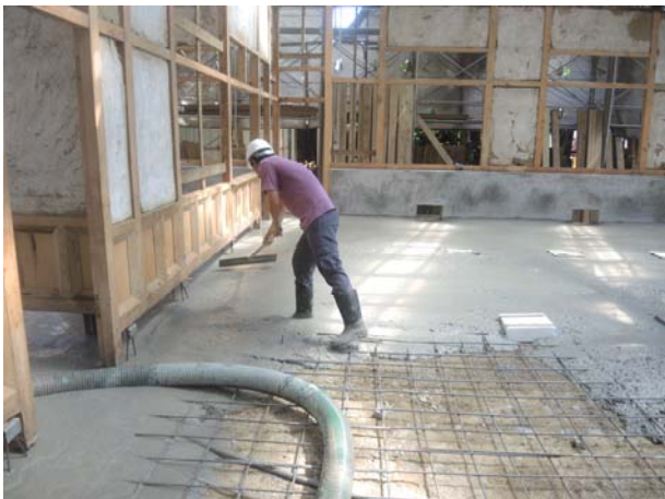
照片3-2-39 地坪灌注 3000psi 混凝土。
