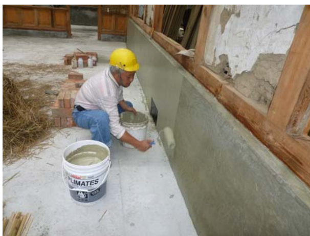
照片3-2-30 打底後抹七厘暗石並加入彈性水泥一併施作。
