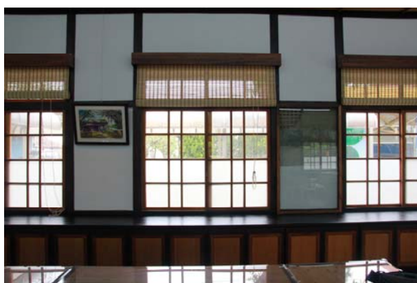
照片3-3-104 辦公室內牆修復後照片(2)。
