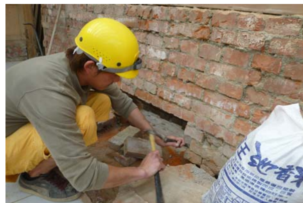
照片3-2-14 於南側與北側新增 W=40*15cm 通氣孔，共八處。
