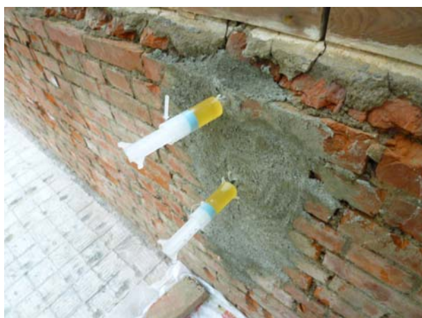
照片3-2-27 補強用環氧樹脂灌注施作 ( 1 )。
