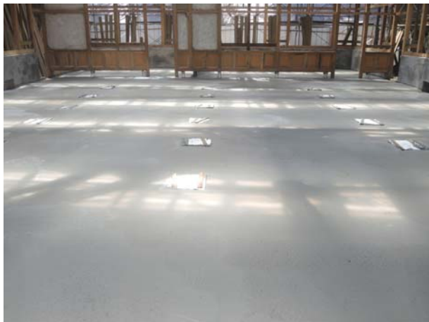
照片3-2-40 地坪灌漿完成。
