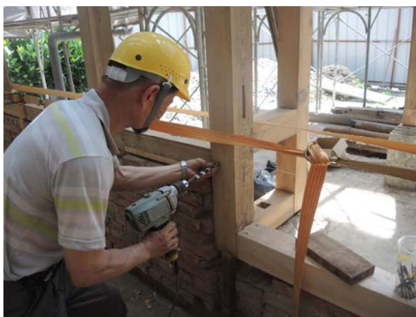
照片3-4-58 待屋架校正後，於軸組木柱一併進行校正作業，另屋架校正完成後才進行軸組與基牆檻木木楔施作。
