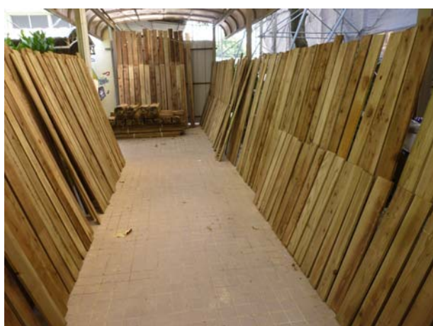
照片3-5-23 本案屋面板為杉木材質，進場進行陰乾作業。
