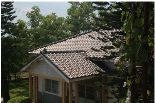
照片3-5-74 屋頂修復前照片(1)。
