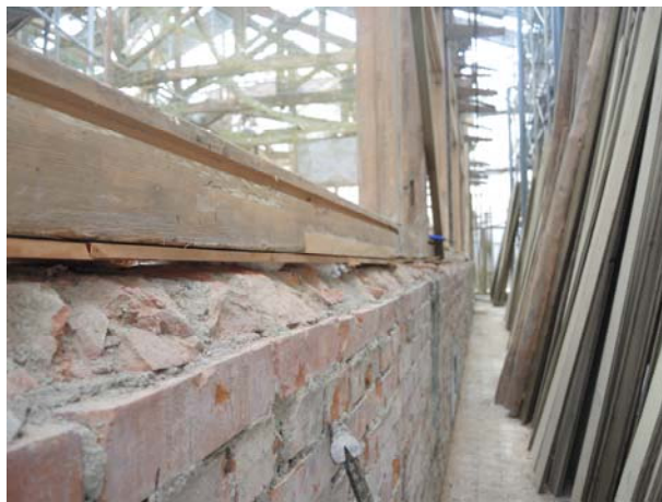
照片3-3-26 檻木底層防潮用 0.4mm 銅片施作情形 2（照片拍攝日期：2013/7/13）。
