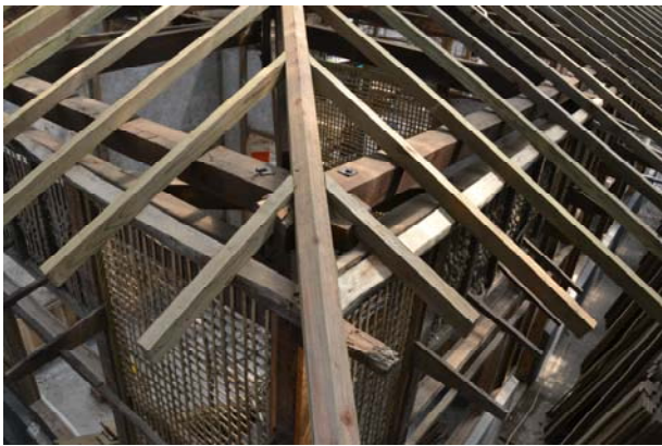
照片3-5-29 屋頂角隅處施作完成。
