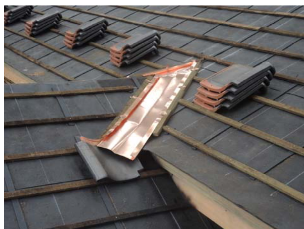
照片3-5-54 主體建築物與車寄接續處(陰角天溝)採用銅製天溝方式處理，銅製天溝可延長使用年限。
