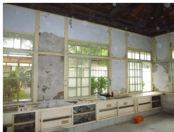
照片3-3-2 軸組與牆體修復前情形 (2)。
