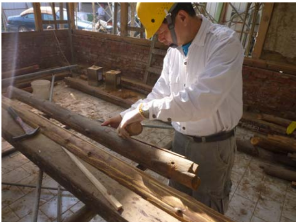
照片3-4-41 桁木損壞處以木條加 EPOXY 進行填補 (2)。
