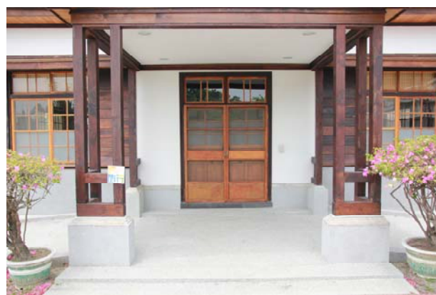
照片3-2-58 車寄地坪修復後情形。
