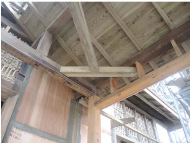
照片3-4-55 於車寄屋架角隅處新增火打樑。
