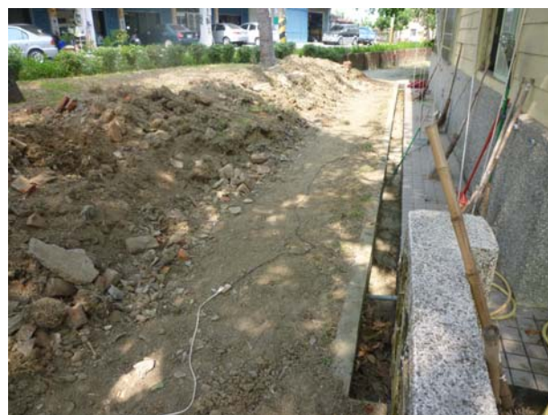
照片3-1-32 木造辦公室背向保護棚架基礎整地施作。
