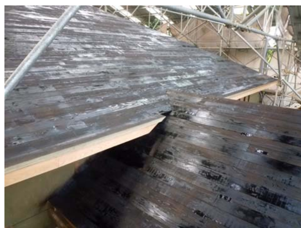
照片3-5-43 車寄屋頂第一層底油施作。
