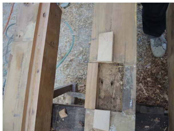
照片3-3-16 木料加 EPOXY 進行填補施作。
