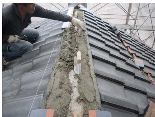
照片3-5-57 中脊施作，本家中脊為五層壓帶瓦。
