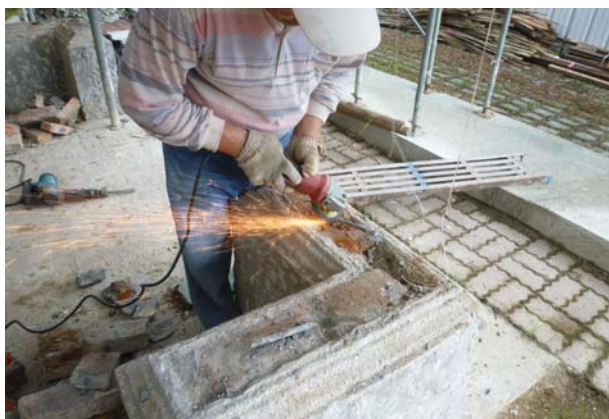
照片3-6-21 原車寄檻木螺栓切除施作。
