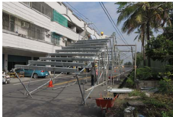
照片3-1-44 鋼管組合桁架吊裝施工。後方由基地旁道路進行吊裝施作。
