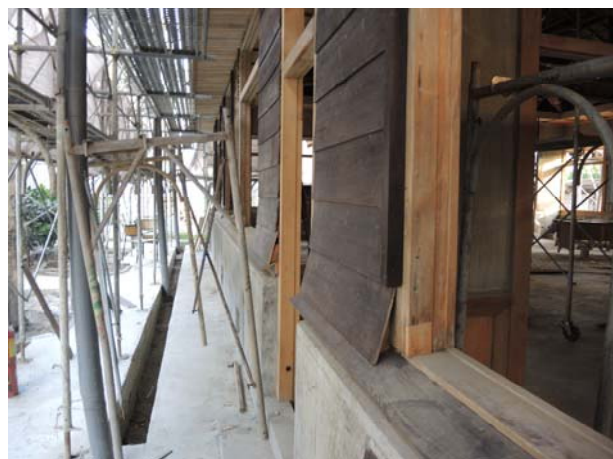
照片3-3-99 雨淋板釘著回鋪後情形 (尚未進行面層保護漆塗刷)。
