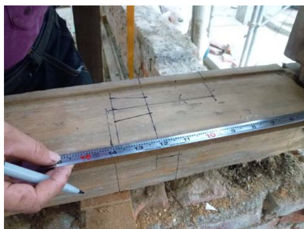
照片3-3-17 燕尾樑接續施作放樣情形 (1)。
