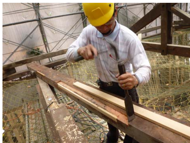
照片3-4-27 以木料加 EPOXY 進行損壞處填補修復 (3)。
