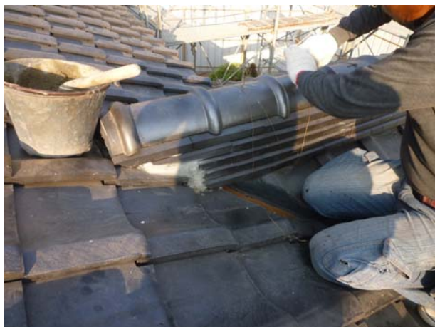
照片3-5-60 壓帶瓦與脊瓦以銅線進行固定。
