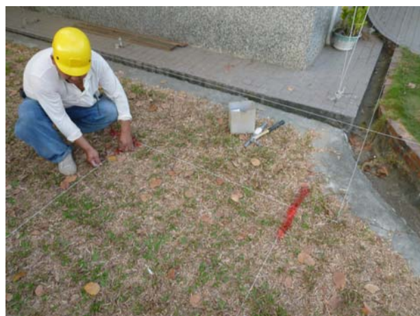
照片3-1-31 保護棚架基礎放樣施作。
