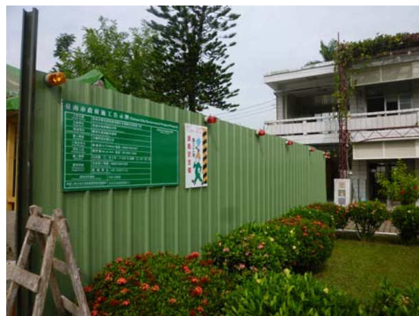
照片3-1-28 警示燈施作完成。
