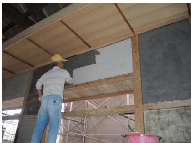
照片3-3-76 面塗白灰粉刷施作過程(2)。
