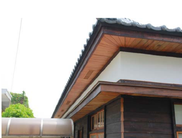
照片3-5-85 屋頂修復後照片 (6)。
