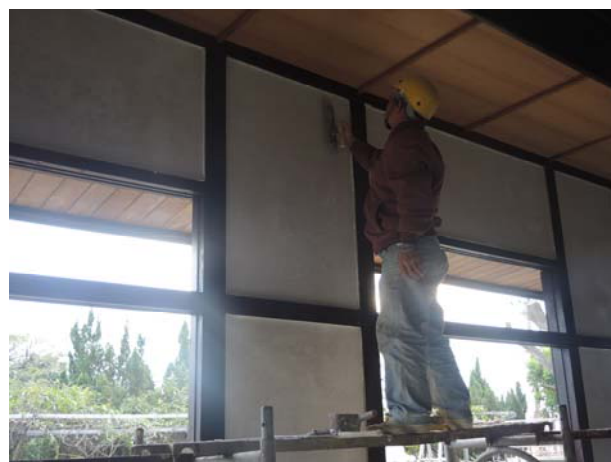
照片3-3-78 面塗白灰粉刷施作過程 (4)。
