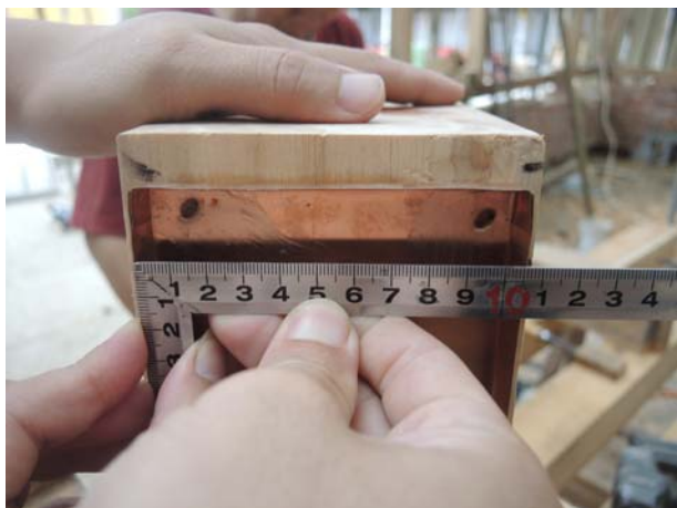
照片3-3-21 於檻木底層施作 0.4mm 銅片作為防潮介面（車寄新作檻木，照片拍攝日期：2013/6/4）。
