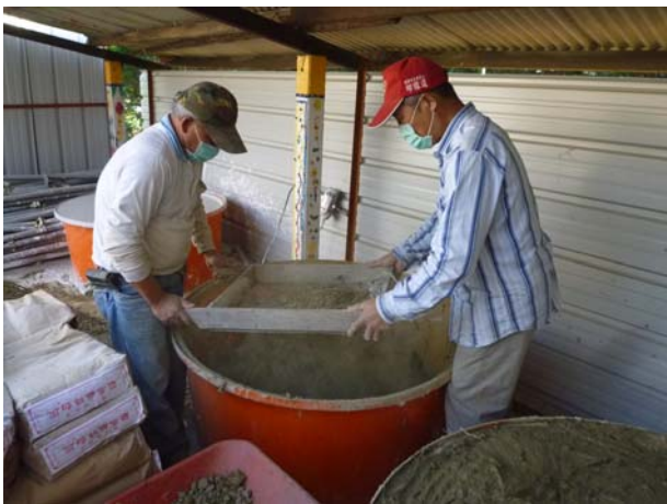
照片3-3-51 泥土篩選施作。
