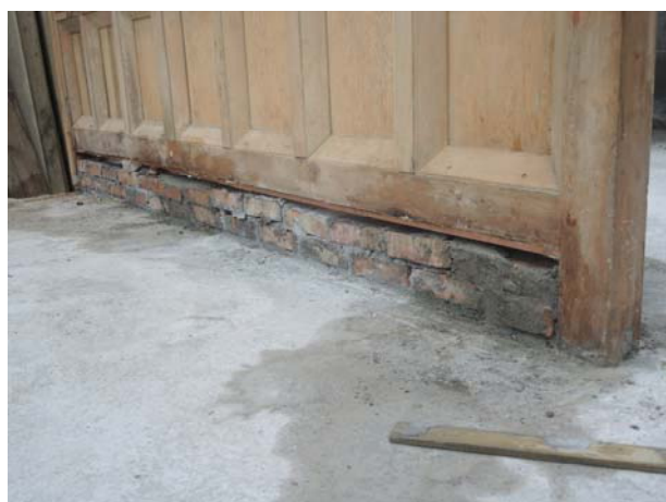
照片3-3-32 內隔間牆檻木底層銅片阻潮施作完成後 2 (照片拍攝日期：2013/7/20)。
