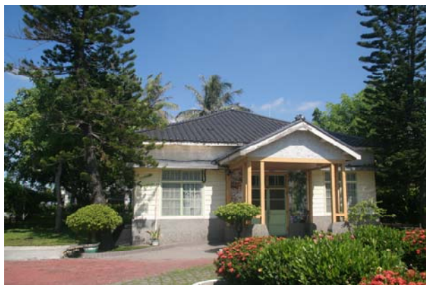
照片3-5-80 屋頂修復前照片 (4)。
