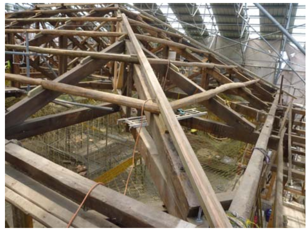
照片3-4-50 角隅處桁木仿作更新。
