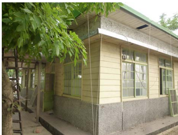
照片3-3-8 修復前左向立面外牆。
