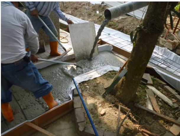
照片3-1-37 保護棚架基礎進行灌漿施作，混凝土為3000psi。
