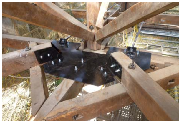
照片3-6-12 屋架接頭補強鋼板施作 (1)。
