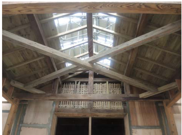
照片3-4-56 中間施作木製交叉拉桿。
