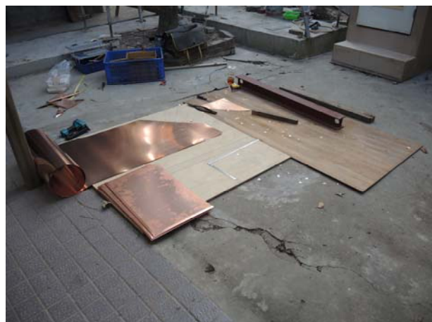
照片3-5-66 本案辦公室雨庇屋頂採銅瓦設計，先於工地底層進行裁切施作。
