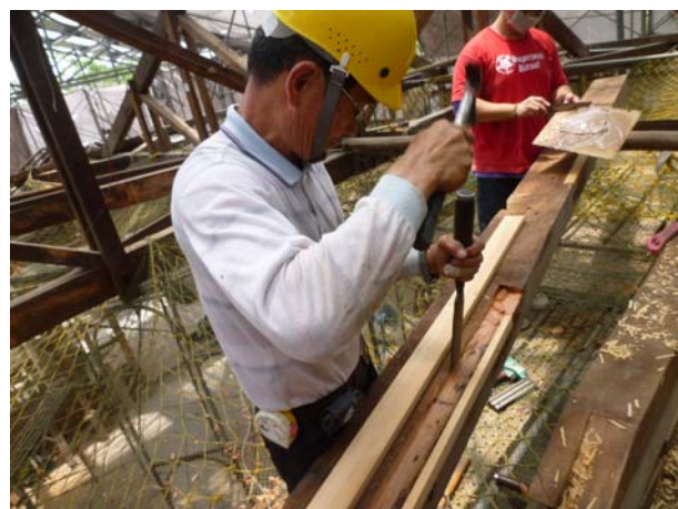
照片3-4-28 以木料加 EPOXY 進行損壞處填補修復 (4)。
