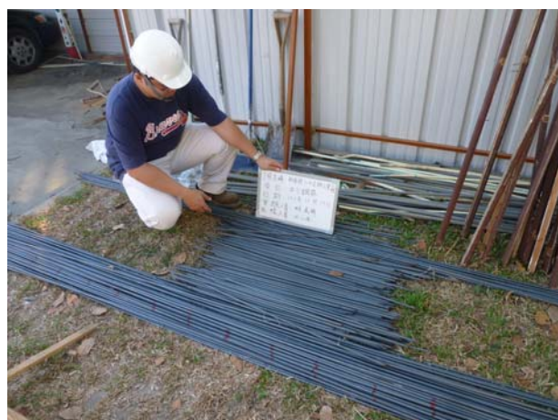
照片3-1-35 # 3 鋼筋進場取樣試驗。
