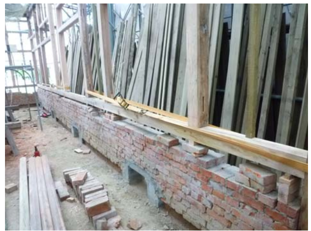
照片3-3-36 將軸組與軸組間進行固定 (軸組 A 立面圖)。
