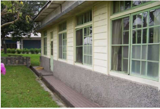
照片3-2-63 南向基牆修復前情形。
