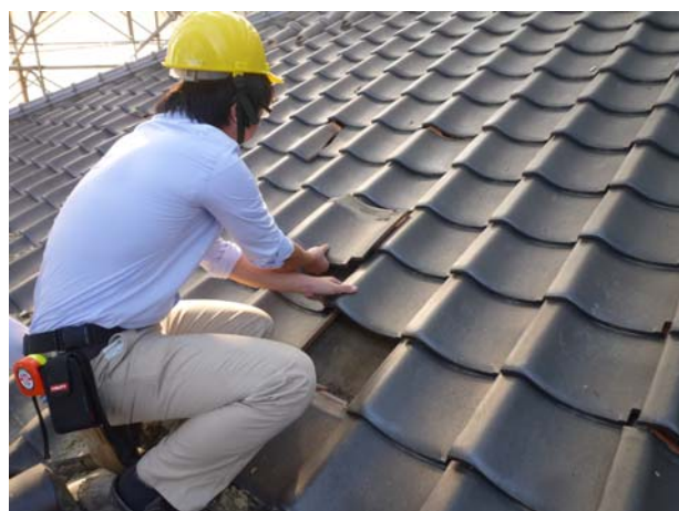
照片3-5-7 本案屋瓦設計為回鋪使用，不足以新料進行鋪設。
