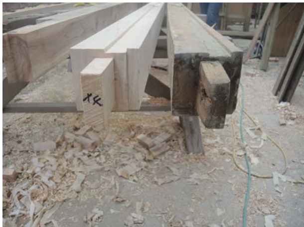
照片3-3-34 依原有樁接尺寸、型式進行原樣仿作。
