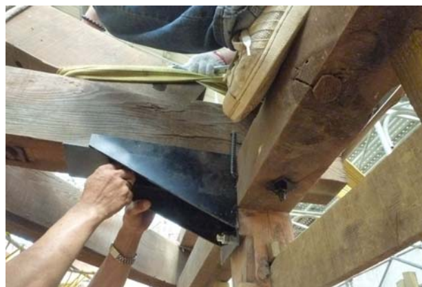
照片3-6-5 陸樑與軸組托架補強鋼板施作。
