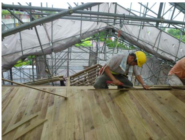
照片3-5-36 裁切使用手具進行施作。
