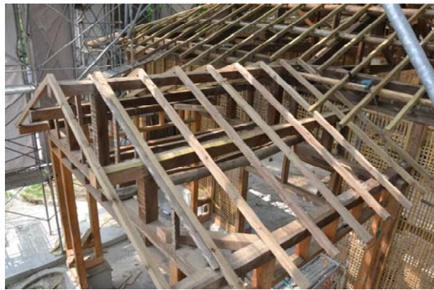
照片3-5-28 車寄屋頂桷木釘著施作完成。
