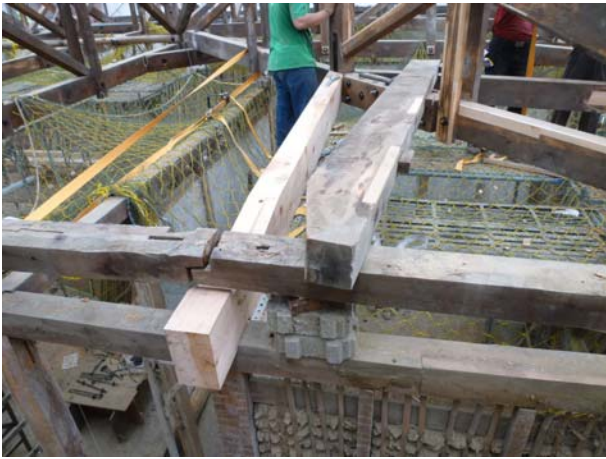
照片3-4-33 屋架組立抽換情形。
