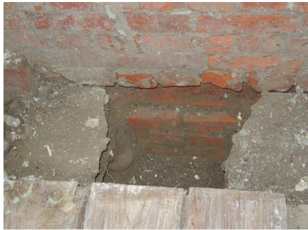
照片3-2-10 基牆內側試挖，發現其構造為底層砌三層磚，詳下圖說明。
