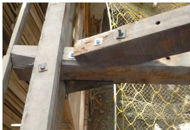
照片3-6-7 屋架固定螺栓更新施作。
