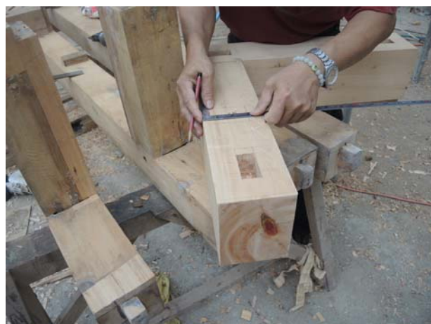
照片3-3-19 車寄新作檻木施作。
