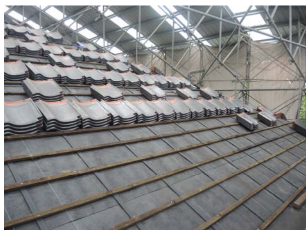
照片3-5-52 掛瓦條施作完成後，將原有文化瓦吊裝至屋頂待鋪設。
