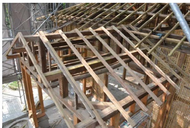
照片3-4-68 屋架修復後照片 (5)。
