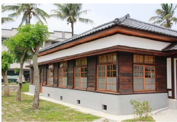
照片3-2-32 基牆施作洗石子完成後情形。
