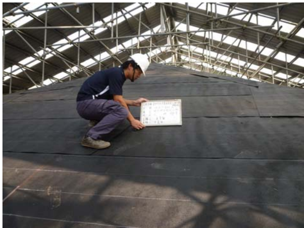
照片3-5-47 七皮油毛氈防水層施作後，進行查驗工作。
