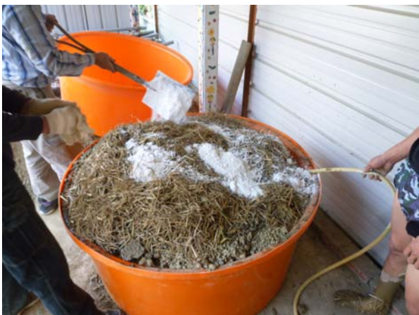
照片3-3-53 加入白灰進行拌合施作。
