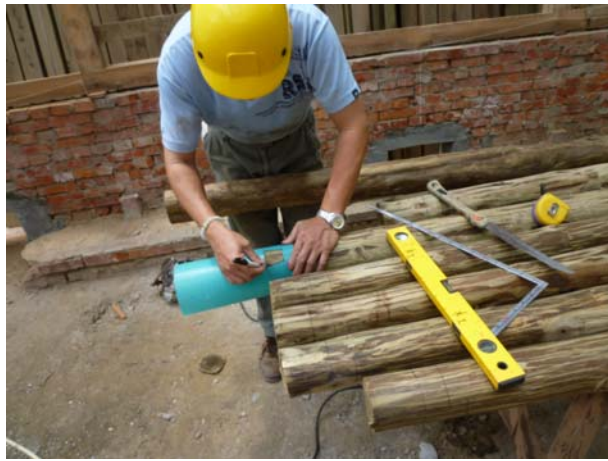
照片3-4-47 燕尾樺接放樣施作 (1)。
