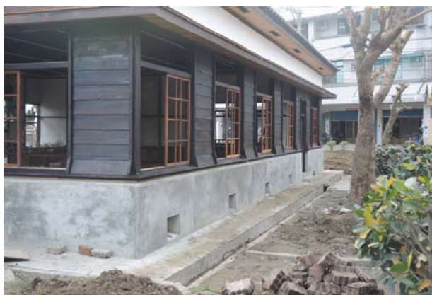
照片3-2-31 基牆外側施作 1:3 水泥砂漿打底。
