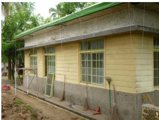
照片3-3-7 修復前背向立面外牆。
