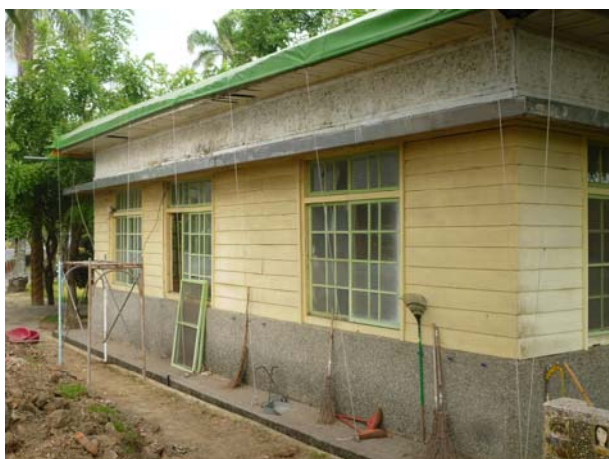
照片3-1-3 修復前背向立面。
