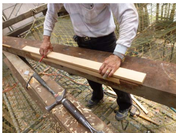
照片3-4-29 以木料加 EPOXY 進行損壞處填補修復 (5)。
