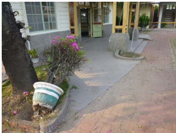
照片3-1-2 修復前入口車寄地坪。
