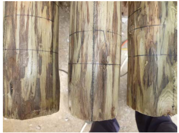
照片3-4-48 燕尾樺接放樣施作 (2)。
