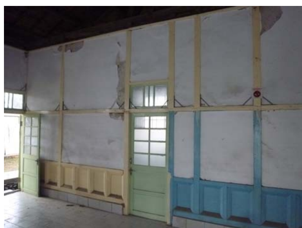
照片3-3-3 辦公室 1 與辦公室 2、儲藏室隔間牆體，拆卸原有室內裝修，可見軸組原底漆為藍色用料。
