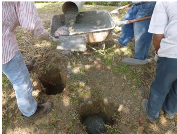
照片3-1-20 柱位灌注混凝土 3000psi。
