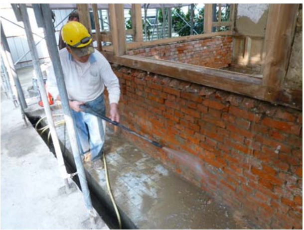
照片3-2-22 以高壓水注進行基牆清洗（1）。
