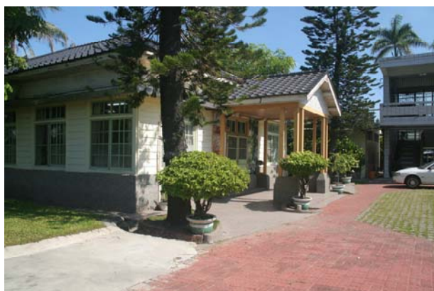
照片3-5-78 屋頂修復前照片 (3)。
