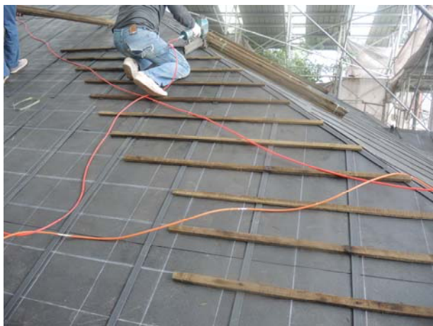
照片3-5-51 掛瓦條釘著施作情形。
