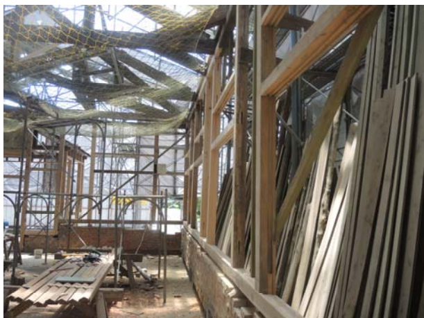
照片3-3-37 軸組抽換後情形（軸組 A 立面圖）。
