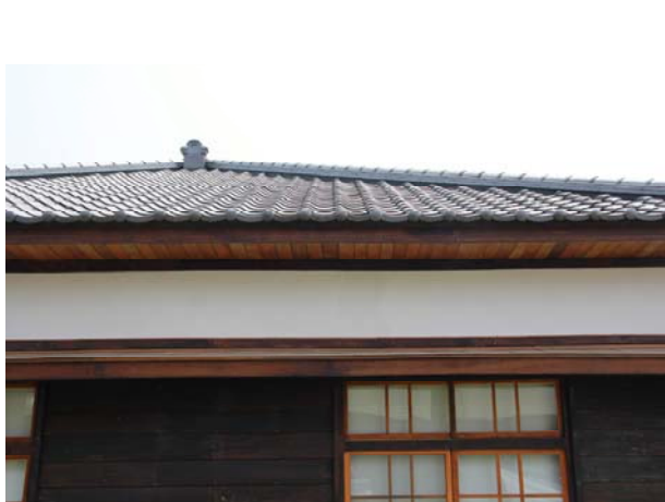
照片3-5-83 屋頂修復後照片 (5)。
