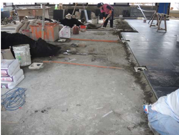
照片3-2-43 地坪鋪設施作過程，採半乾式施作。
