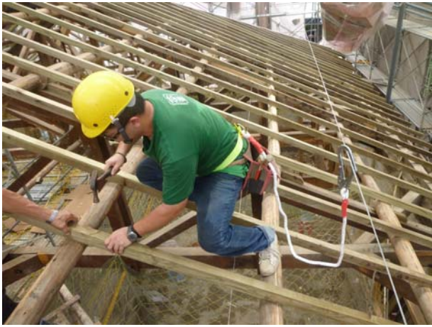
照片3-5-25 屋頂桷木釘著施作 (1)。
