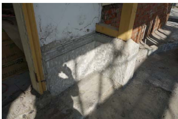
照片3-2-13 主入口基牆面層抵石子敲除後，可見原為洗石子材質。
