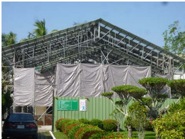
照片3-1-50 鋼管組合桁架施作完成。
