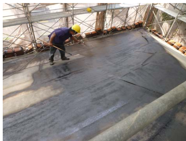
照片3-5-45 施作時以噴塗方式處理，以減少因刷塗而大量滲漏至屋面板間接滲漏至室內天花。
