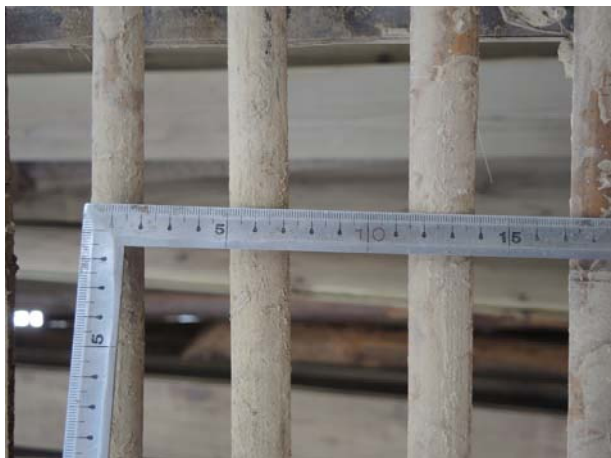
照片3-3-63 原有編竹間距紀錄約 3-4cm 寬度。
