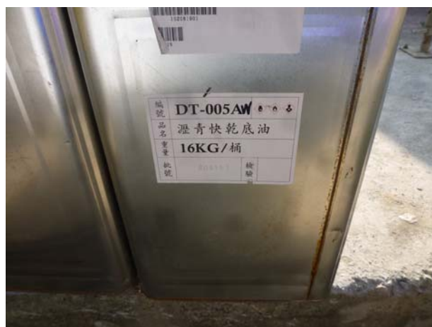
照片3-5-40 瀝青快乾底油材料進場。
