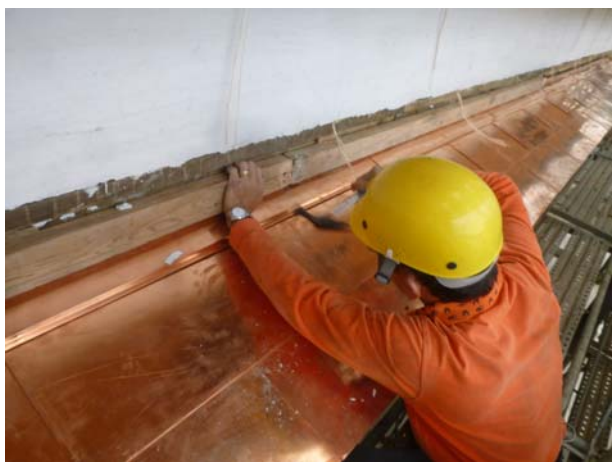
照片3-5-71 銅瓦與牆面接續處，木作匠師配合銅瓦施作後再進行飾條釘著。
