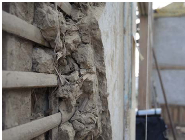
照片3-3-64 原有編竹夾泥牆斷面，可見底塗至面塗。
