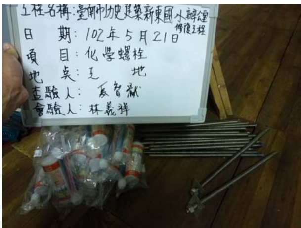
照片3-6-19 M16 化學螺栓進場 (1)。
