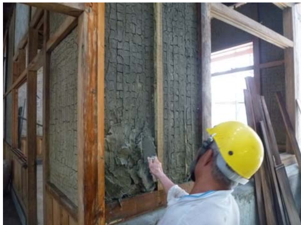
照片3-3-72 中塗使用泥土混合稻桿及少量砂後塗抹於壁體上。
