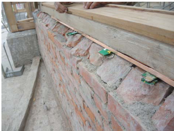
照片3-3-25 檻木底層防潮用 0.4mm 銅片施作情形 1（照片拍攝日期：2013/7/13）。
