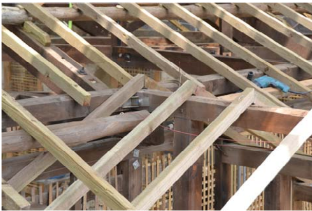
照片3-4-53 車寄屋架與主體建築銜接處施作不銹鋼鐵件補強。
