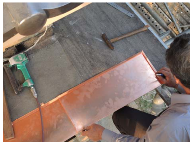
照片3-5-67 銅瓦施作情形，轉角處部位進行裁切施作 (1)。
