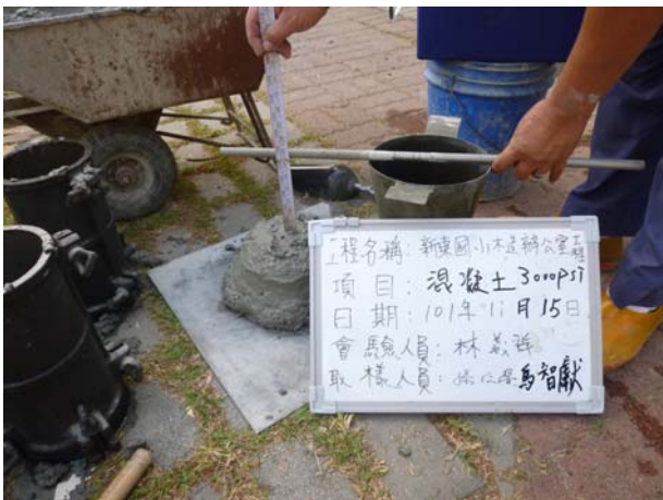
照片3-1-39 混凝土灌漿前進行坍度試驗。
