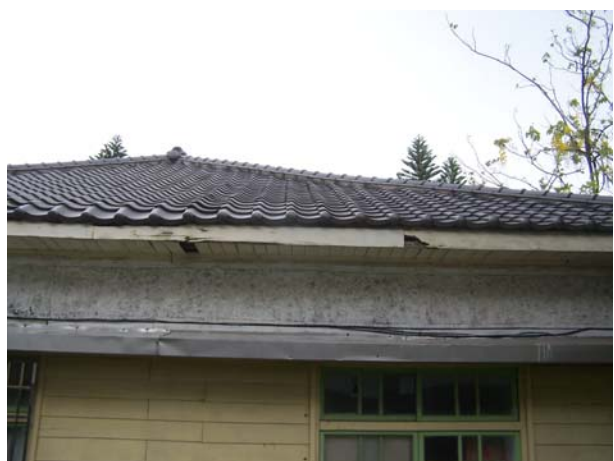
照片3-5-82 屋頂修復前照片 (5)。
