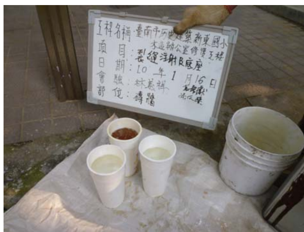
照片3-2-26 磚牆裂縫注射及底座材料進場。
