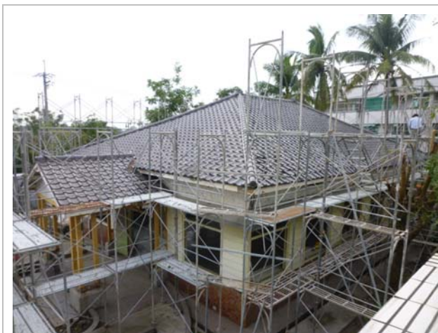
照片3-1-43 施工鋼管鷹架組裝施作 (3)。
