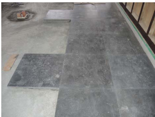
照片3-2-44 鋪貼施作過程。
