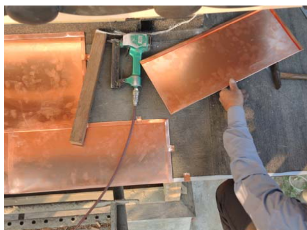
照片3-5-68 銅瓦施作情形，轉角處部位進行裁切施作 (2)。
