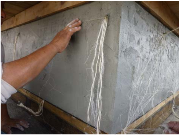
照片3-3-83 外牆角隅處施作情形。
