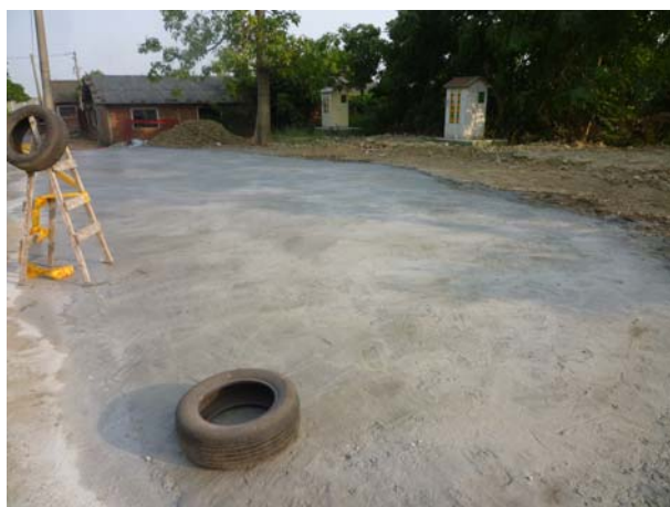
照片3-1-22 校園外空地地坪整地及灌漿，做為保護棚架臨時組裝場所。
