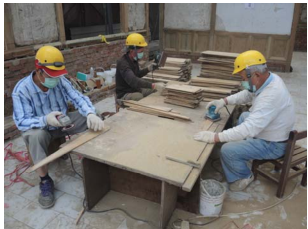
照片3-3-92 以電動研磨機進行適當磨除殘留漆料。
