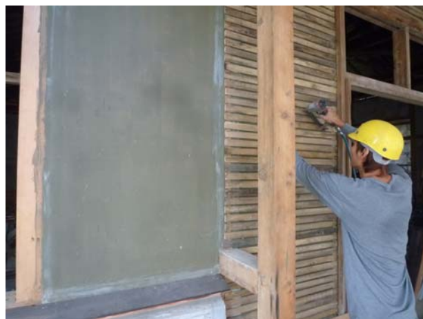
照片3-3-79 外牆木摺灰泥牆木摺條釘著施作情形。
