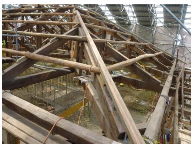
照片3-5-24 屋頂桷木施作。
