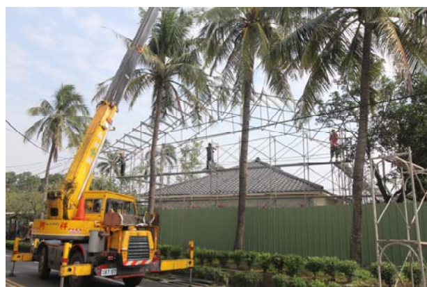
照片3-1-45 吊裝施作過程。
