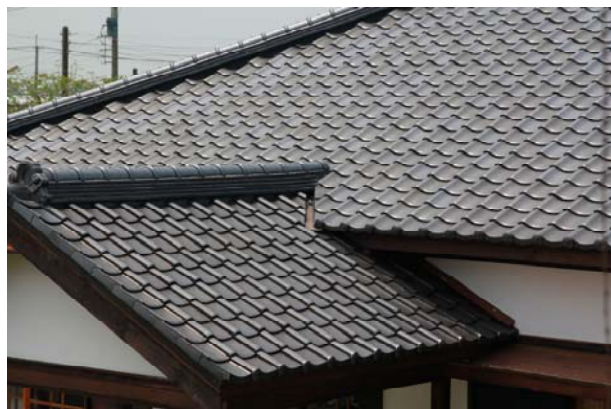
照片3-5-77 屋頂修復後照片 (2)。
