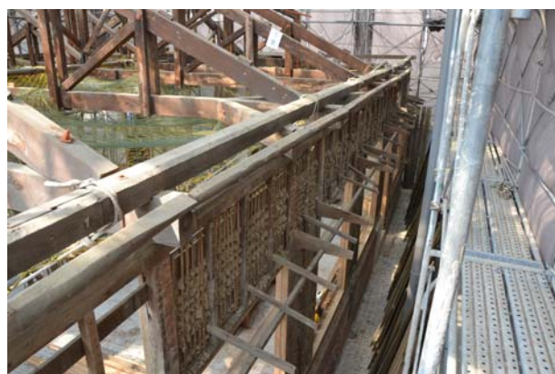
照片3-4-37 屋面板拆除後，發現陸樑末端釘著 D- \phi 12cm 管桁。此作法與安溪國小木造辦公室一樣，可參閱工作報告書第三章第六節，p3-115。
