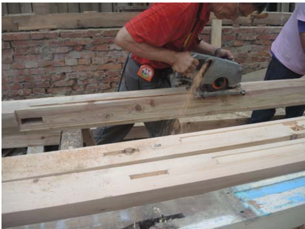
照片3-3-33 新作軸組木料進行裁切樁接施作。
