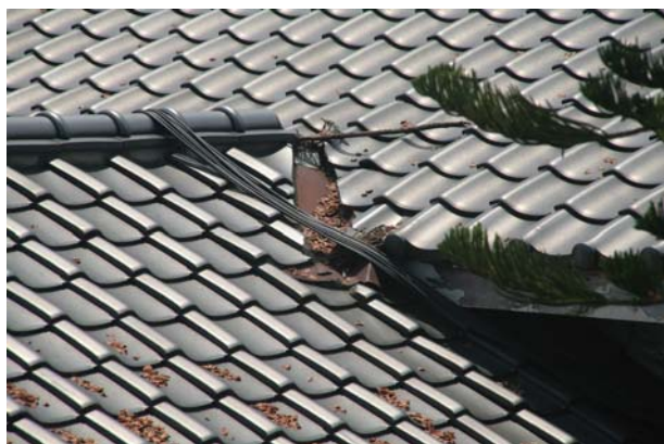
照片3-5-76 屋頂修復前照片 (2)。
