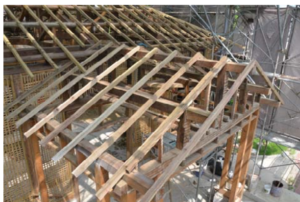
照片3-4-66 屋架修復後照片 (4)。
