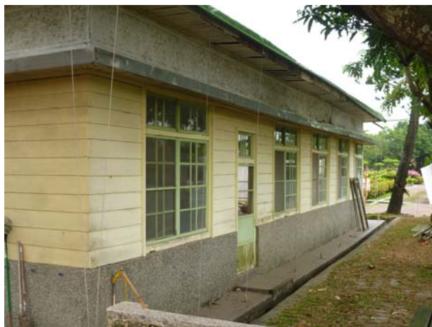
照片3-3-6 修復前右向立面外牆。
