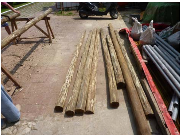
照片3-4-45 新作桁木木料進場。
