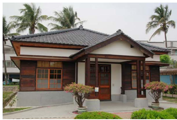
照片3-3-112 辦公室東向外牆修復後照片。
