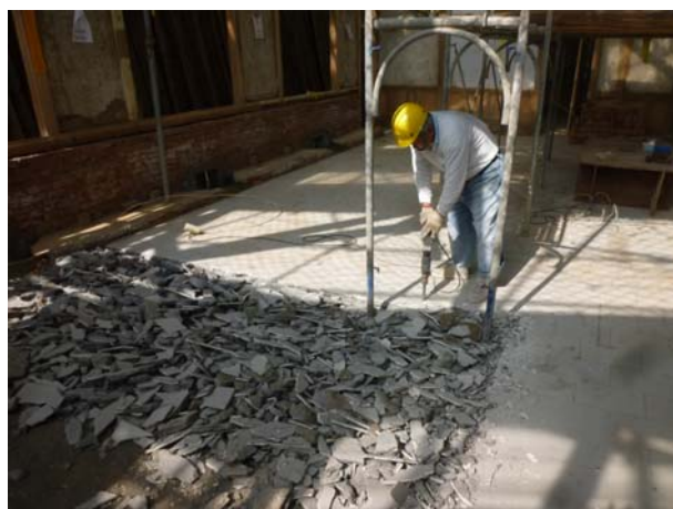
照片3-2-34 以手動電鑽進行地坪鑿除施作。
