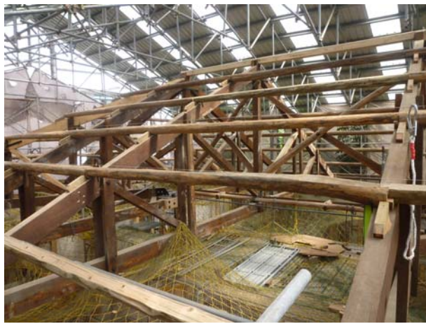
照片3-4-49 桁木抽換施作完成。
