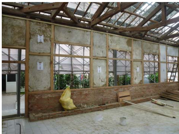
照片3-1-12 牆體面層拆除，依損壞狀況標示修復層級（2）。
