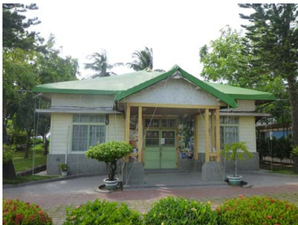
照片3-1-1 修復前正向立面。
