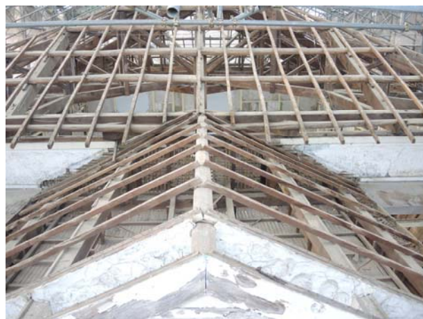
照片3-4-10 修復前車寄屋架構造 (3)。
