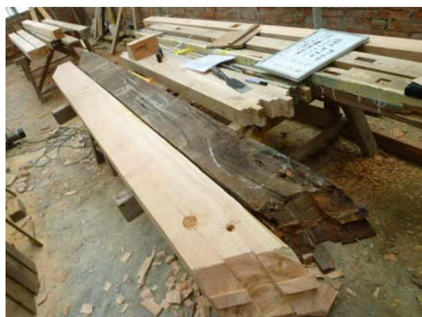
照片3-4-31 屋架損壞依原樣貌進行仿作更新。
