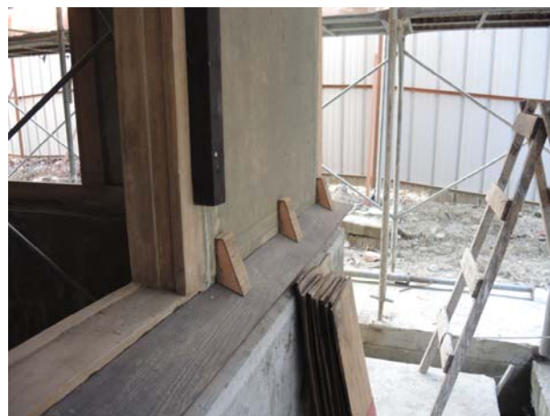
照片3-3-98 底層第一塊雨淋板新增桷木施作。
