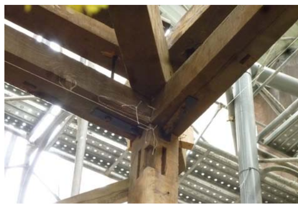
照片3-6-8 原有羽子板進行螺栓固定施作。
