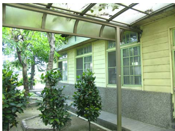
照片3-1-5 由校方增設鋁擠型遮雨過廊與木造辦公室銜接。
