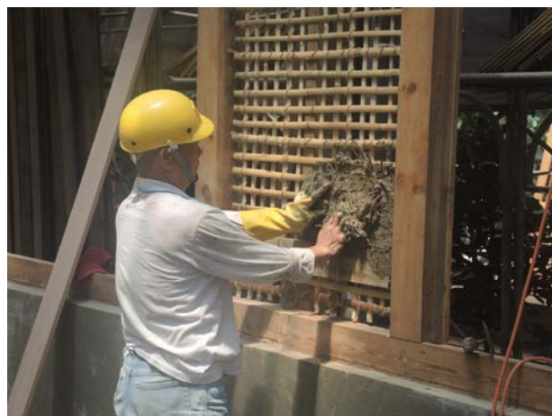
照片3-3-67 底塗泥土層施作，塗抹時將泥土擠壓至突出編竹背面，形成突出的球狀，使其與編竹能緊密咬合。
