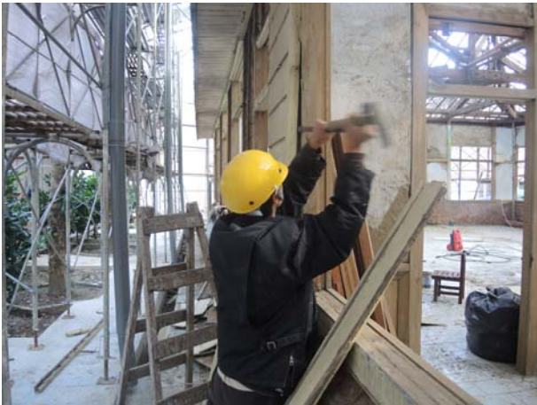
照片3-3-89 以手工具進行拆卸施作(1)。
