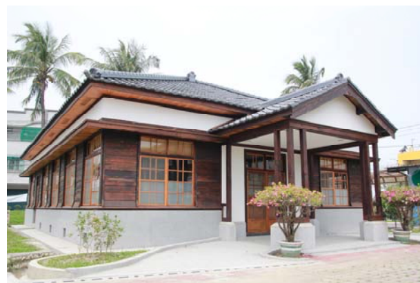
照片3-3-100 雨淋板施作完成後情形。
