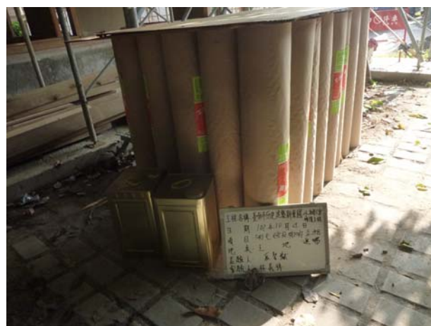
照片3-5-41 油毛氈材料進場。
