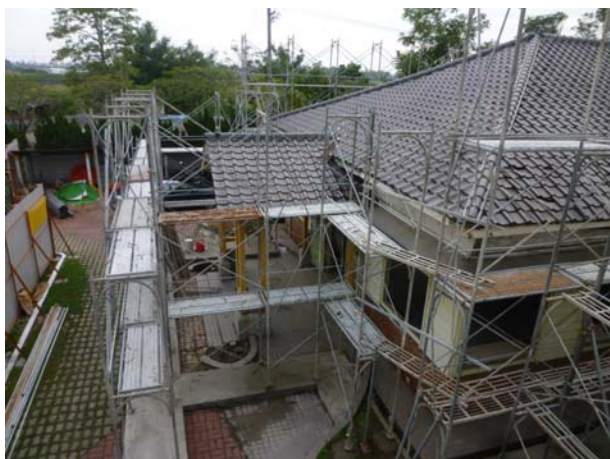
照片3-1-42 施工鋼管鷹架組裝施作(2)。
