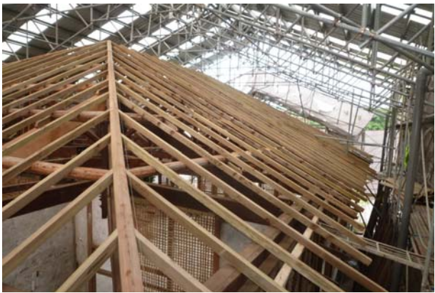
照片3-5-27 桷木釘著施作完成。
