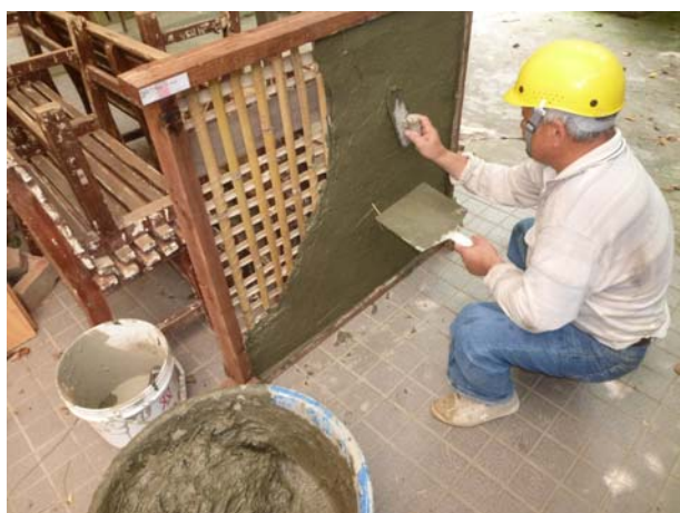
照片3-3-59 製作 100×100cm 樣品做為日後學校教學使用。照片為編竹夾泥牆樣品。
