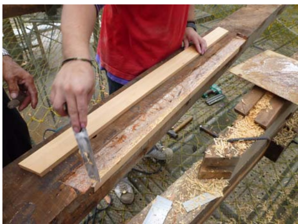
照片3-4-25 以木料加 EPOXY 進行損壞處填補修復 (1)。
