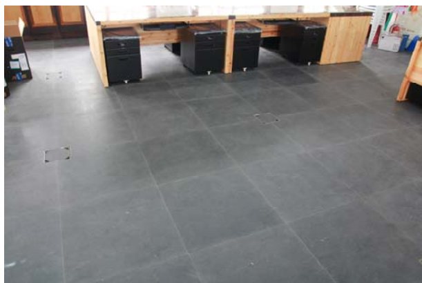
照片3-2-52 室內地坪修復後照片(1)。
