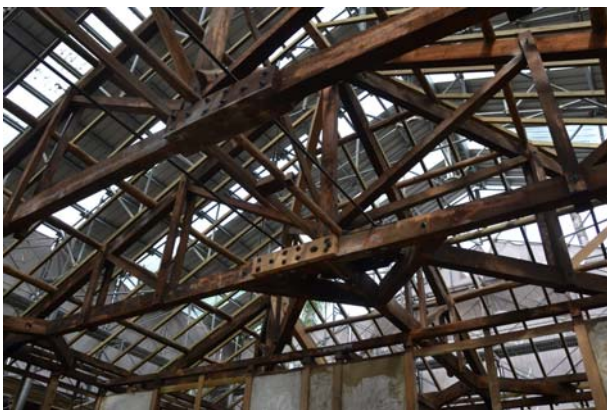
照片3-6-13 屋架接頭補強鋼板施作 (2)。
