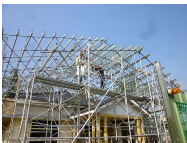
照片3-1-48 車寄上方鋼管組合桁架吊裝施作 (2)。
