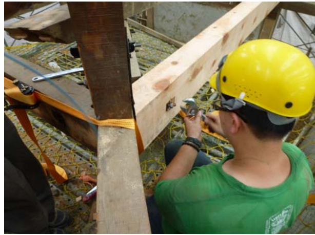
照片3-4-34 固定螺栓施作情形。
