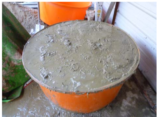
照片3-3-54 完成後情形，再於面層覆蓋帆布。
