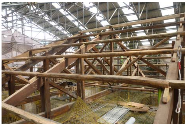
照片3-4-60 屋架修復後照片(1)。
