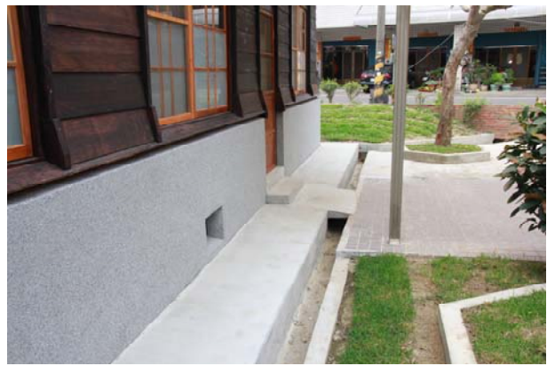
照片3-2-66 北向基牆修復後情形。
