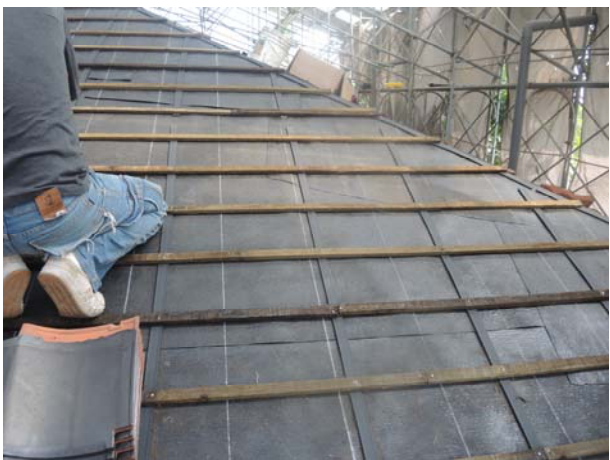
照片3-5-50 洩水條施作完成後，進行掛瓦條施作，本案掛瓦條為防腐美檜木料。
