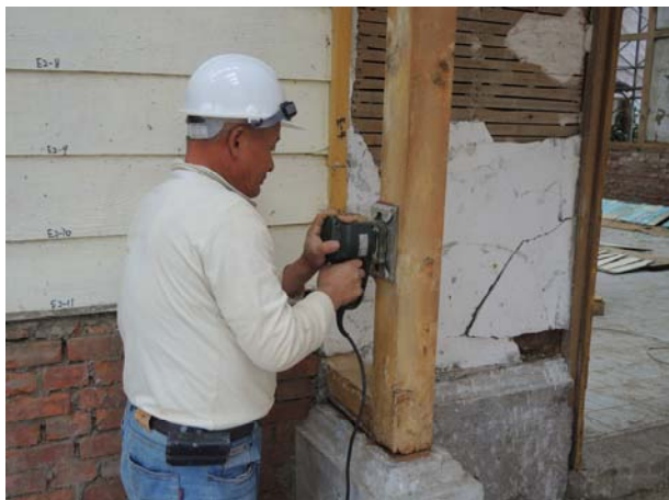
照片3-3-14 以電動研磨機進行磨平處理(車寄軸組)。
