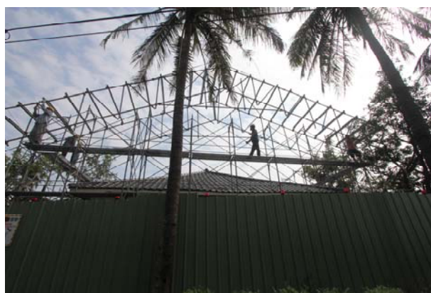
照片3-1-46 吊裝至施工鋼管鷹架上，使用金屬接續器進行固定。
