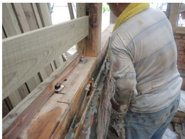
照片3-3-28 檻木縫隙灌注無收縮水泥施作情形 2 (照片拍攝日期：2013/7/14)。
