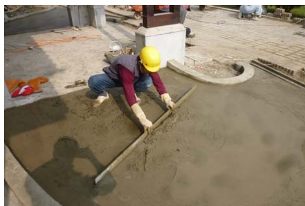
照片3-2-49 車寄地坪施作過程。
