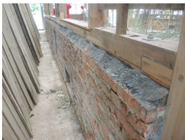
照片3-3-30 檻木底層銅片阻潮施作完成後 2 (照片 拍攝日期：2013/7/14)。
