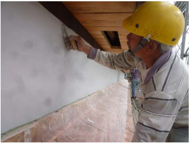
照片3-3-85 面塗白灰層施作情形。
