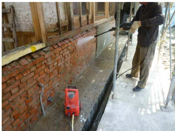
照片3-2-23 以高壓水注進行基牆清洗 ( 2 )。
