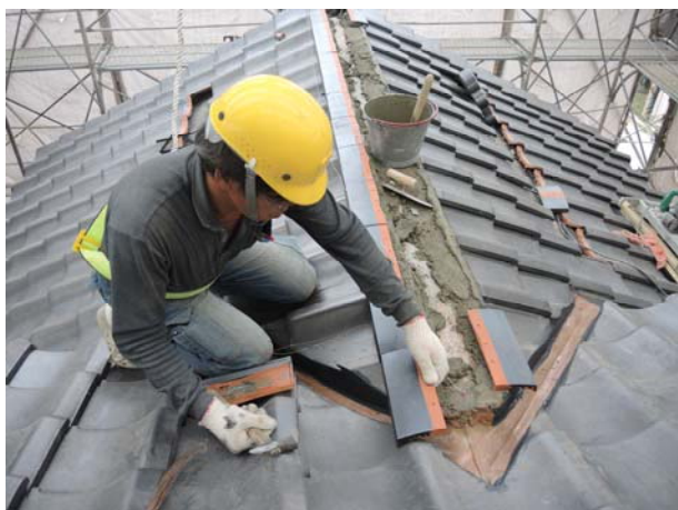
照片3-5-59 壓帶瓦施作情形。
