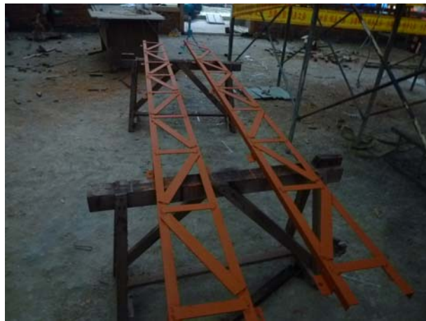
照片3-6-10 角鋼鐵件刷塗紅丹防銹漆。
