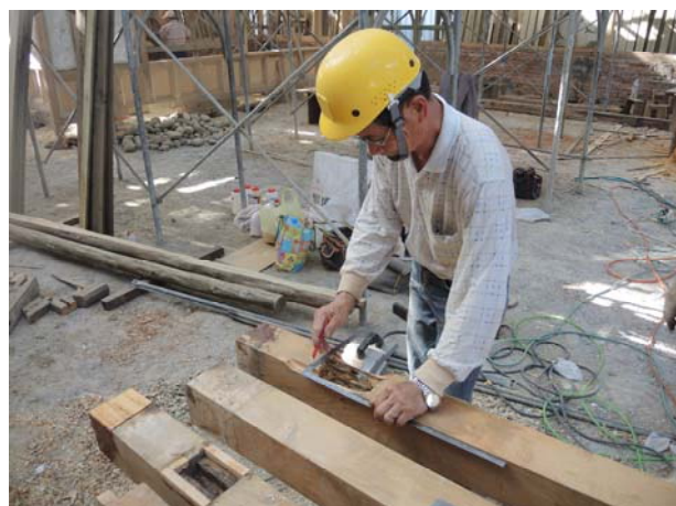
照片3-3-15 將損壞處地檻木進行鑿除，以木料加 EPOXY 進行填補施作。
