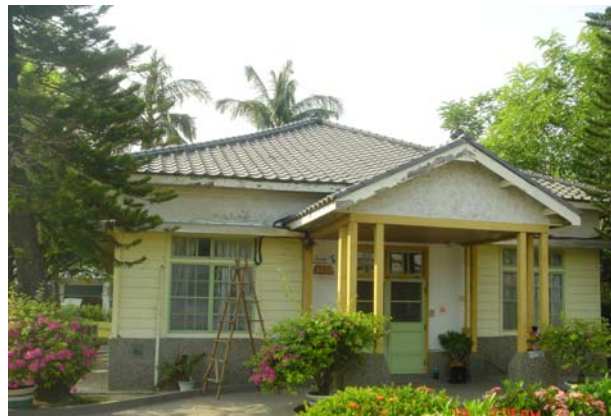
照片3-3-111 辦公室東向外牆修復前照片。
