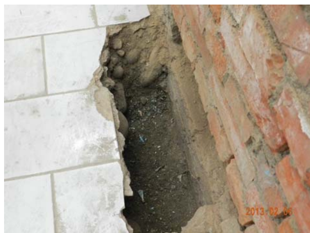
照片3-2-33 室內地坪進行開挖，可見基牆構造型式，詳圖 3-2-2。
