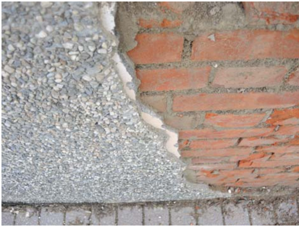
照片3-2-7 基牆外側修復前面層鑿除，可見構造磚砌、洗石子、水泥粉刷層、振石子。
