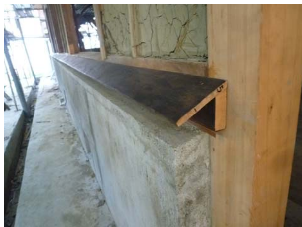
照片3-3-97 新增副土台施作，於被襯泛水銅片。
