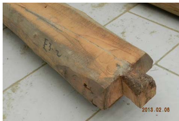
照片3-4-38 桁木接續採燕尾榫型式 (1)。
