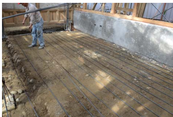
照片3-2-36 地坪配置#3 鋼筋。
