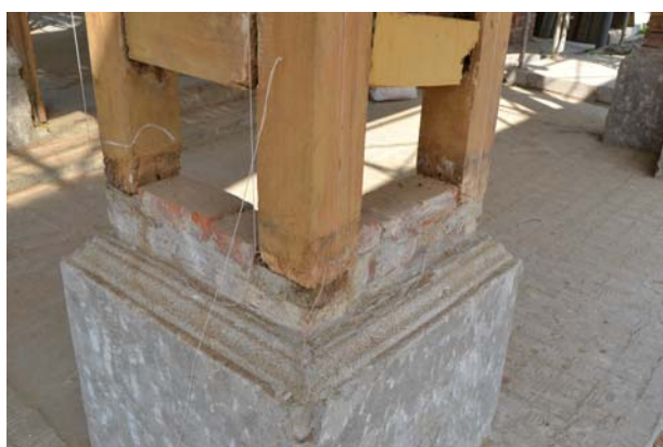
照片3-3-9 車寄基牆面層抵石子拆除後可見車寄軸組木柱直接落於基牆上。
