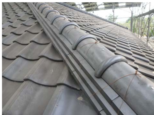
照片3-5-64 斜脊瓦施作完成。
