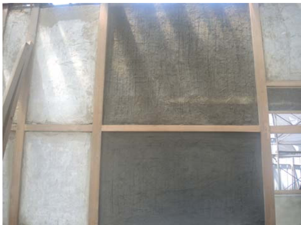
照片3-3-73 待中塗乾燥後再進行面塗白灰施作。
