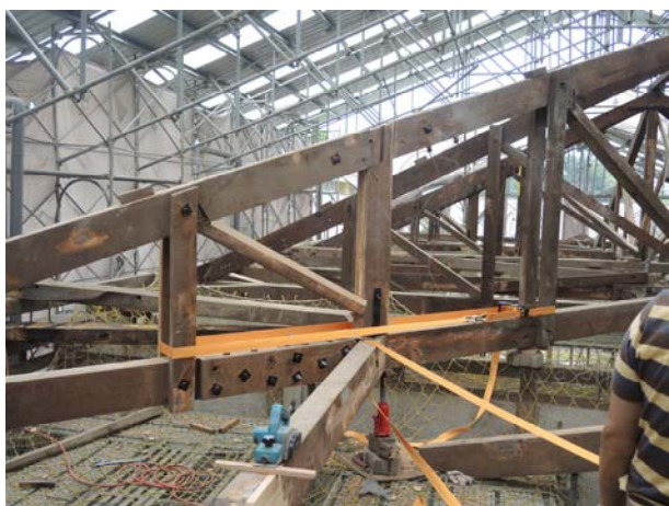
照片3-4-57 屋架木構件抽換與修補完成後進行假固定。
