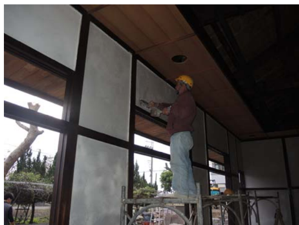
照片3-3-77 面塗白灰粉刷施作過程 (3)。
