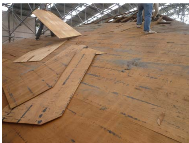
照片3-5-21 防水夾板拆除。
