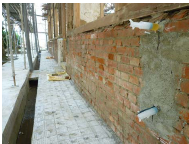
照片3-2-28 補強用環氧樹脂灌注施作 ( 2 )。
