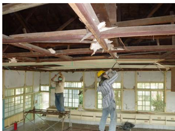
照片3-1-7 使用鐵撬將後期增設室內夾板天花拆除。
