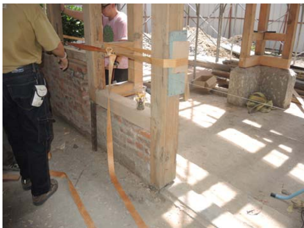
照片3-3-38 由兩側拉起水線進行校正作業（軸組 14 立面圖）。
