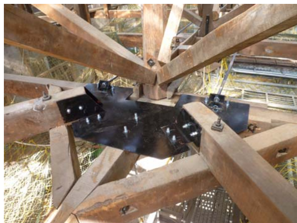
照片3-6-15 屋架接頭補強鋼板及拉桿施作。
