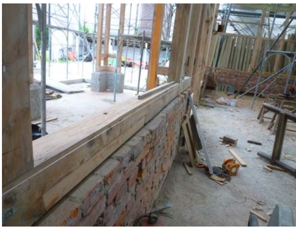
照片3-3-35 軸組修補與仿作抽換後，進行校正作業 (軸組 14 立面圖，詳圖 3-3-23)。
