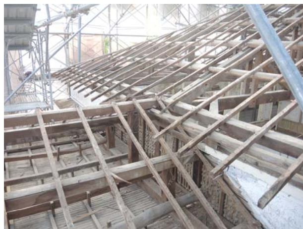
照片3-4-8 修復前車寄屋架構造 (1)。
