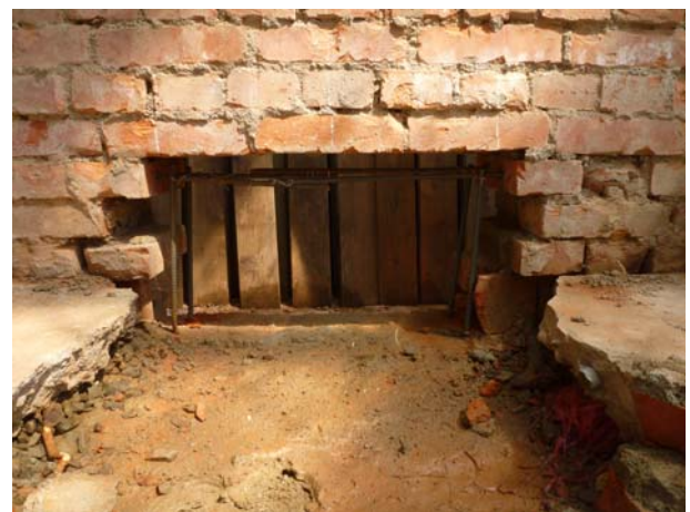
照片3-2-18 #3 鋼筋施作 (2)。
