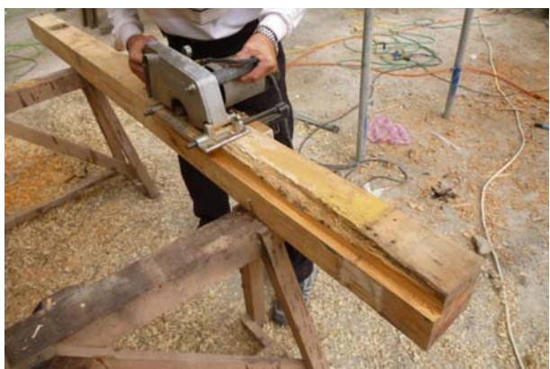
照片3-4-23 將損壞處木料以電鋸進行鋸除。
