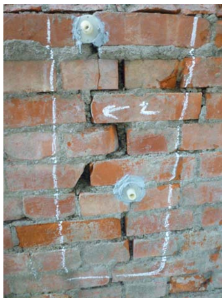
照片3-2-24 裂縫處灌注補強用環氧樹脂。
