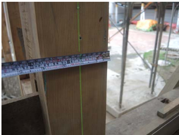
照片3-3-40 進行軸組水平度與垂直度校正作業（軸組 14 立面圖）。
