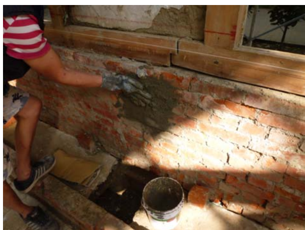
照片3-2-25 勾縫剝落處以無收縮水泥砂漿進行填補。
