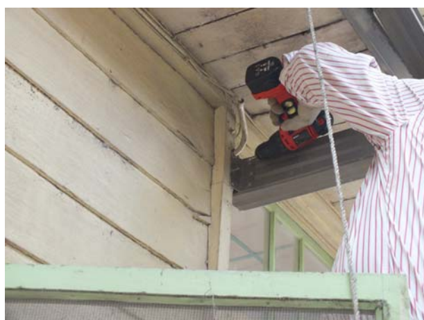
照片3-1-6 以手動機具將固定螺絲拆除。
