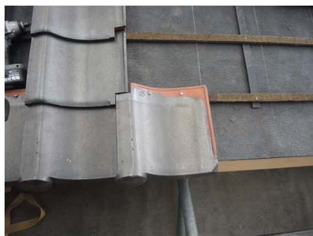
照片3-5-55 屋瓦鋪設，由簷口往中脊方向依序施作。
