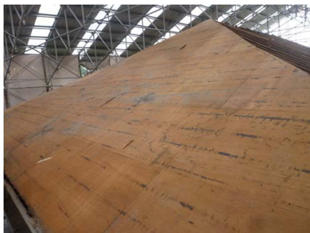
照片3-5-20 防水層拆卸後，屋面板上層為後期鋪設防水夾板。
