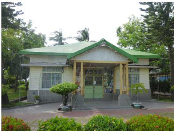
照片3-3-5 修復前正向立面外牆。
