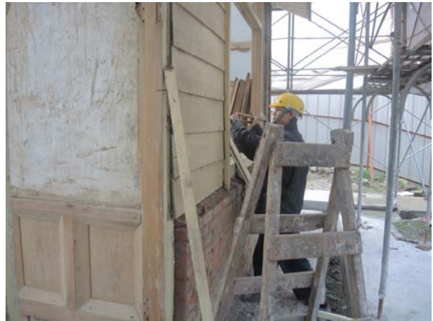
照片3-3-90 以手工具進行拆卸施作(2)。
