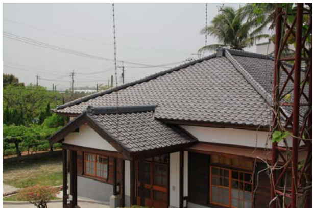
照片3-5-75 屋頂修復後照片(1)。
