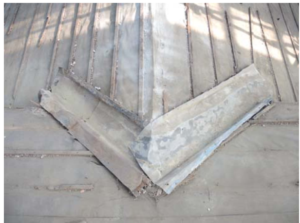
照片3-5-18 陰角天溝為亞鉛板材質所構成。(詳圖請參閱第四章第四節)
