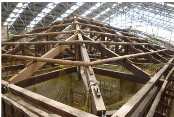
照片3-4-62 屋架修復後照片(2)。
