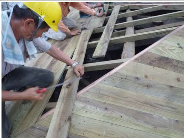
照片3-5-35 屋面板釘著鋪設，屋頂陽角處進行適當裁切。
