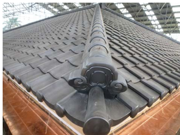
照片3-5-65 斜脊瓦與馬蹄施作完成。
