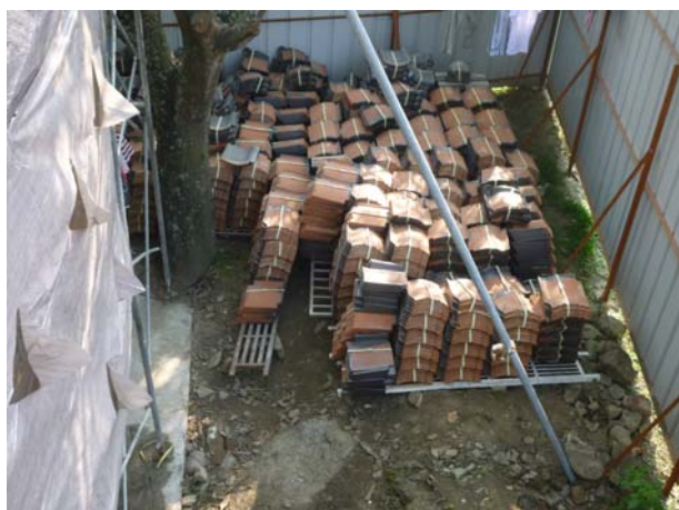
照片3-1-16 拆卸整理後屋瓦置放於地面層，待回鋪使用。
