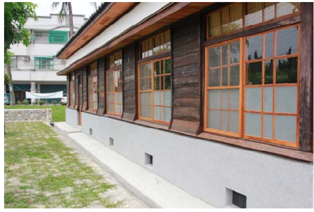
照片3-2-64 南向基牆修復後情形。
