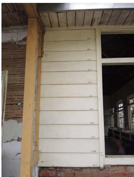
照片3-3-87 外牆雨淋板拆卸前，先進行編碼作業。
