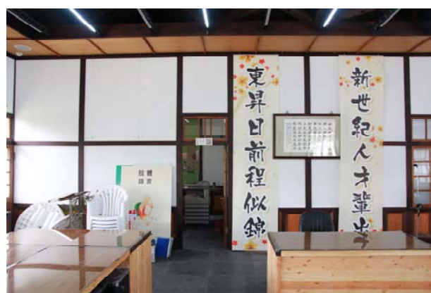
照片3-3-110 辦公室內牆修復後照片 (5)。
