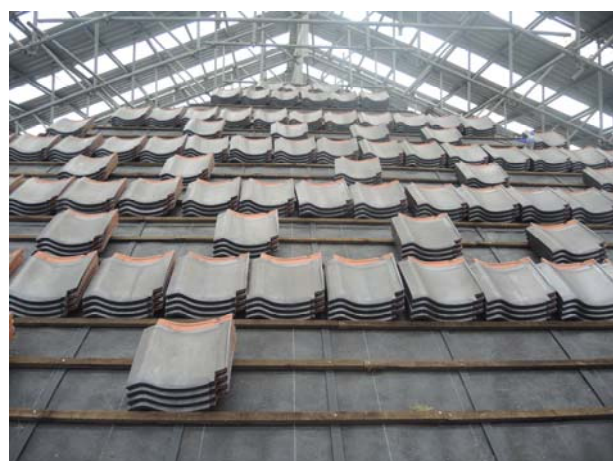
照片3-5-53 本案屋瓦為原文化瓦回鋪施作，不足數量以新料施作。
