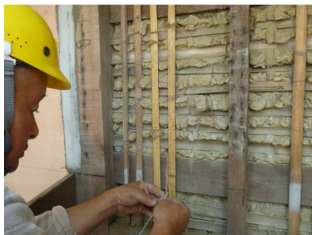
照片3-3-65 將原有損壞竹子抽換，新編竹子施作。
