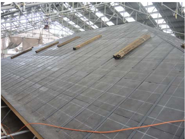
照片3-5-48 屋頂洩水條施作，洩水條為塑膠條材質。
