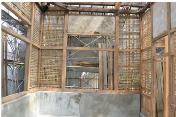
照片3-3-41 軸組修復後情形（軸組 P 立面圖）。
