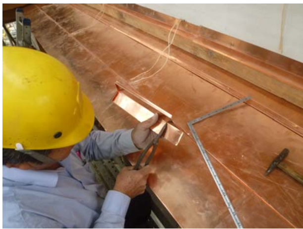
照片3-5-72 收邊飾條再進行銅瓦包覆施作。
