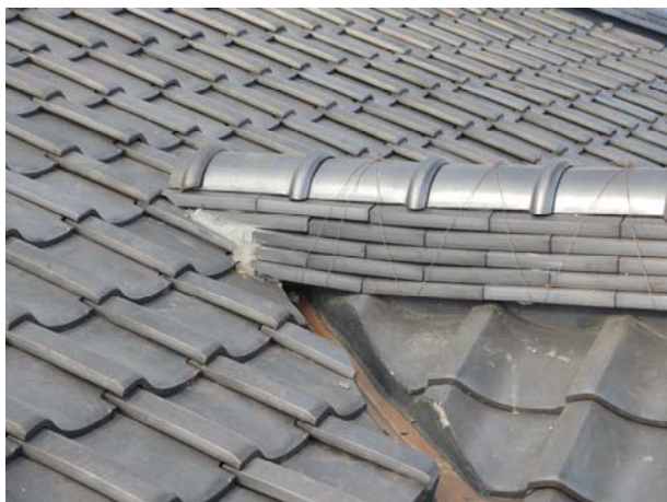
照片3-5-61 車寄正脊瓦與陰角天溝施作完成後情形。
