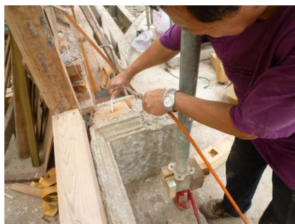
照片3-6-18 將磚牆孔清理乾淨，待進行植筋作業。
