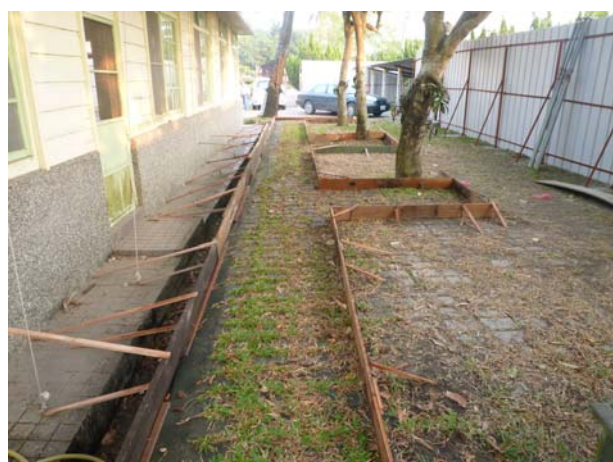
照片3-1-33 保護棚架基礎模板施作，寬度為 120 cm。
