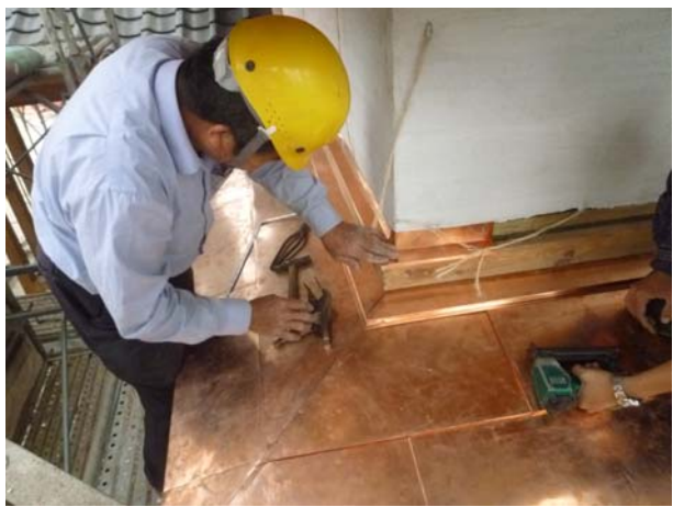
照片3-5-73 牆體轉角處施作。
