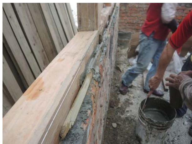
照片3-3-27 檻木縫隙灌注無收縮水泥施作情形 1 (照片拍攝日期：2013/7/14)。
