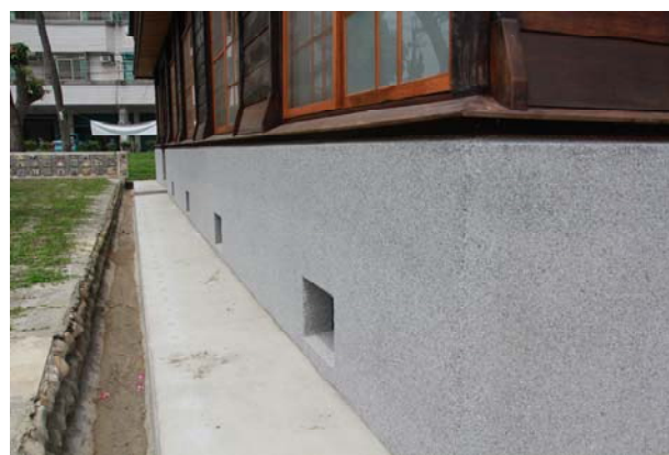
照片3-2-50 犬走為 1:3 水泥砂漿打底抹七厘暗石。
