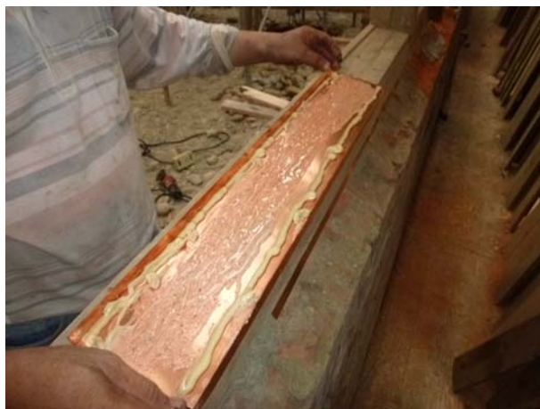
照片3-3-24 刷塗 EPOXY 於銅片上再填設於原有檻木內（照片拍攝日期：2013/7/13）。
