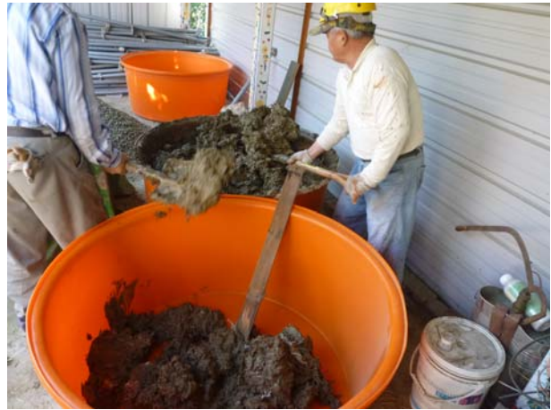
照片3-3-50 進行養土作業，以大塑膠桶進行裝設。
