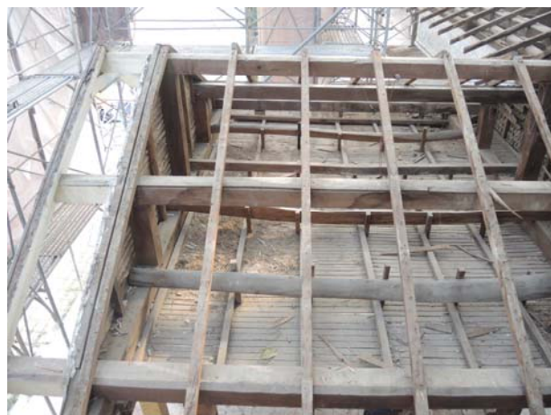
照片3-4-9 修復前車寄屋架構造 (2)。
