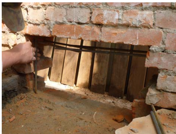
照片3-2-17 #3 鋼筋施作 (1)。
