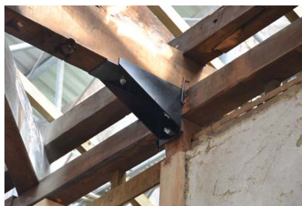
照片3-6-6 陸樑與軸組托架補強鋼板施作完成，共計 12 處。
