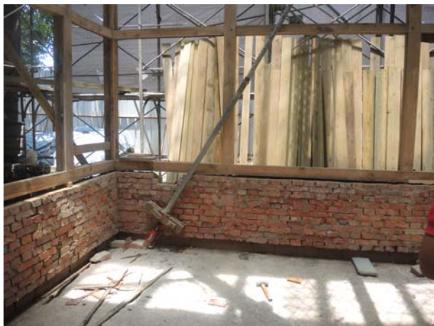
照片3-3-39 以鐵管進行軸組與屋架支撐作業（軸組 A、14 立面圖）。
