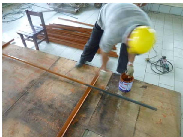
照片3-1-23 甲種圍籬角鋼塗刷紅丹防銹漆。
