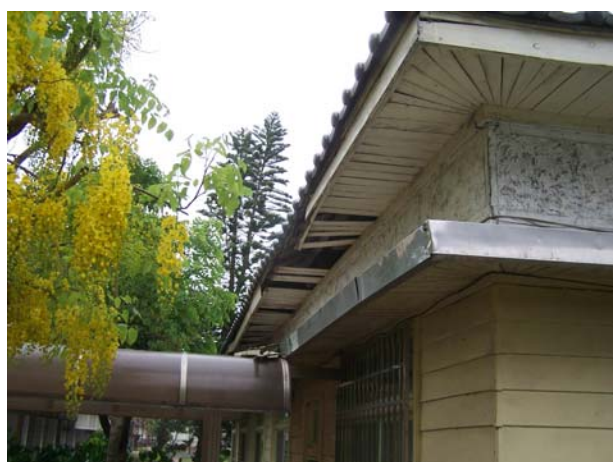
照片3-5-84 屋頂修復前照片 (6)。
