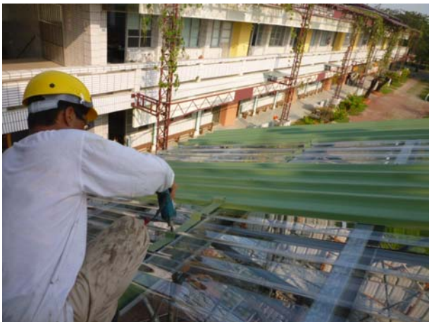
照片3-1-49 屋頂烤漆鋼浪板施作，以自攻螺絲固定。
