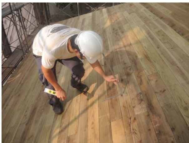
照片3-5-39 屋面板釘著完成後進行平整度之查驗工作，於兩端拉起水線進行分段查驗。
