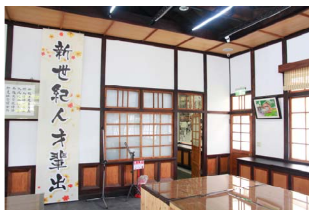
照片3-3-108 辦公室內牆修復後照片 (4)。
