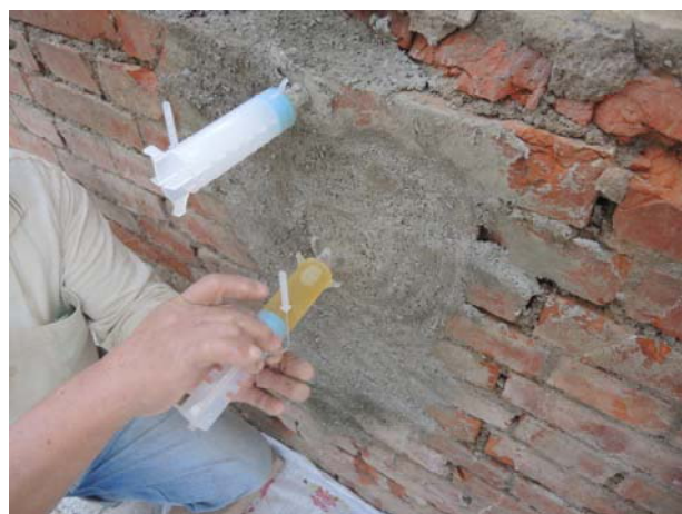
照片3-6-3 磚牆裂縫灌注 (1)。
