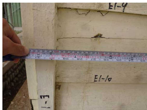
照片3-3-88 原有雨淋板修復前尺寸丈量。
