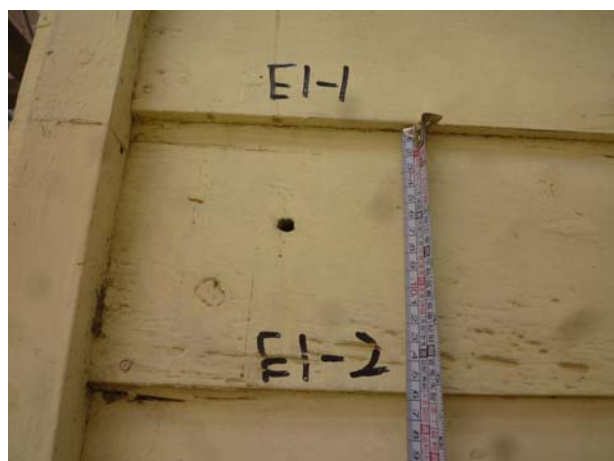
照片3-1-9 雨淋板拆卸前編碼紀錄。
