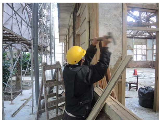
照片3-1-10 以手工工具將雨淋板押條先行拆除，再進行雨淋板拆卸。
