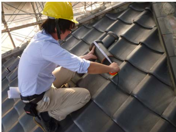
照片3-1-13 屋瓦拆卸，脊瓦尺寸紀錄。
