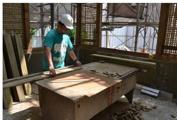
照片3-5-33 於地面層先行將屋面板尺寸裁切完整。
