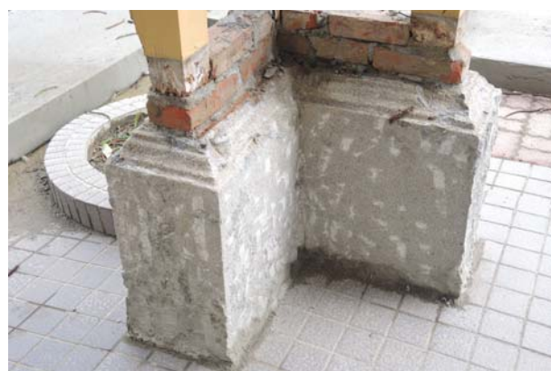
照片3-2-12 車寄基座面層抵石子敲除後，可見原洗石子材質。
