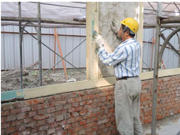
照片3-3-13 使用剝漆劑將軸組漆料進行剝離施作 (軸組 A 立面圖)。
