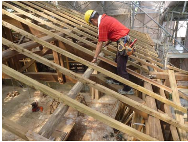
照片3-5-26 屋頂桷木釘著施作 (2)。
