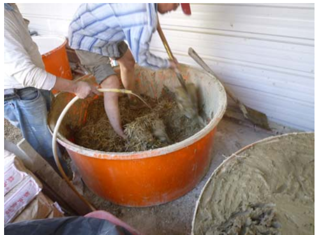
照片3-3-52 加入稻草與水進行拌合施作。
