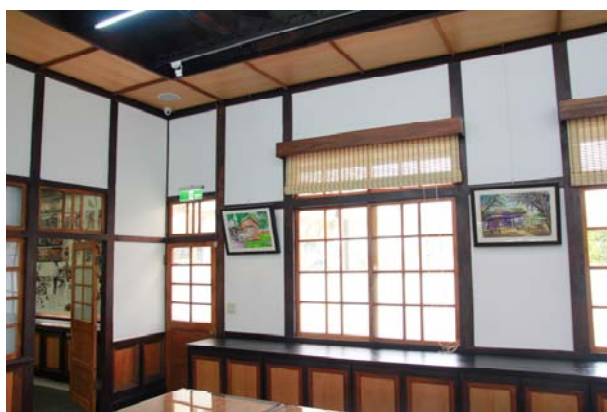
照片3-3-106 辦公室內牆修復後照片(3)。
