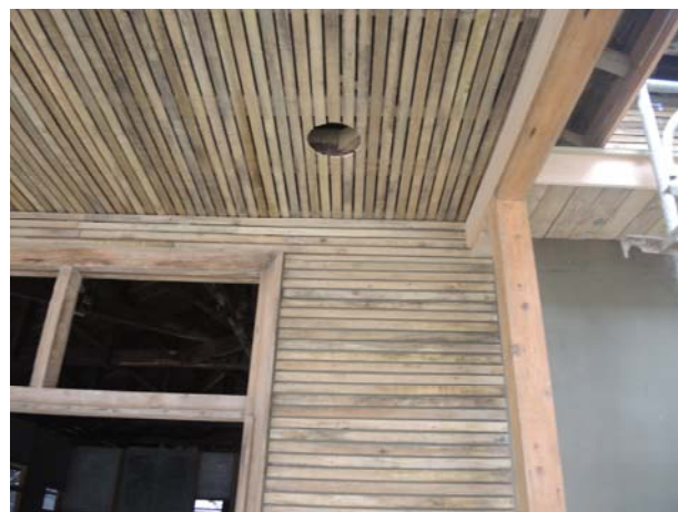
照片3-3-80 正向立面外牆木摺條釘著施作完成。
