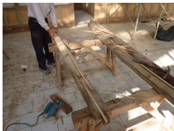
照片3-4-40 桁木損壞處以木條加 EPOXY 進行填補 (1)。
