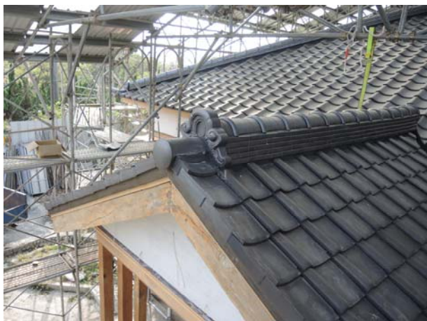
照片3-5-62 車寄屋瓦施作完成。
