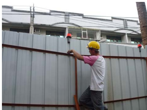
照片3-1-27 警示燈施作。
