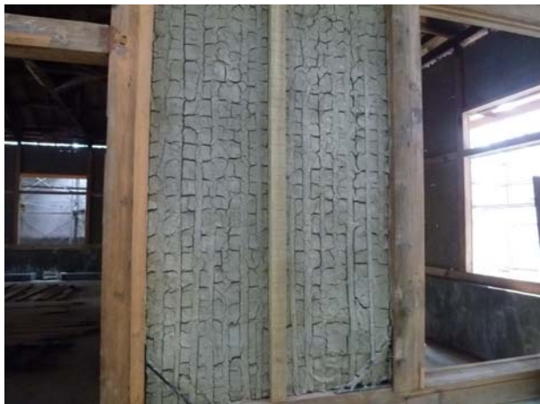
照片3-3-71 原有底塗噴灑少許水份以利中層泥土結合。
