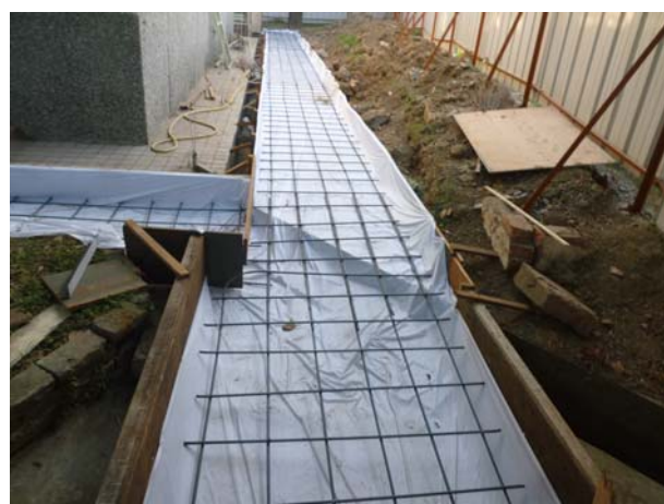
照片3-1-34 保護棚架基礎配筋施作，底層鋪設塑膠帆布。
