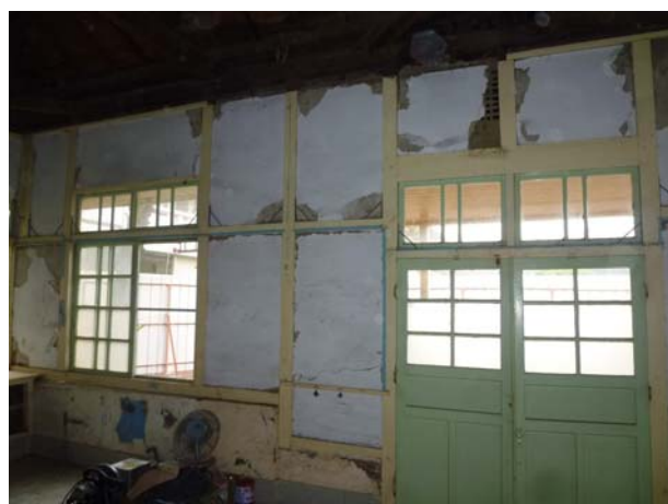
照片3-3-1 軸組與牆體修復前情形 (1)。牆體於修復前因地震產生角隅處灰泥牆剝落。
