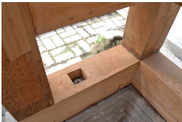
照片3-6-23 M16 化學螺栓施作完成。
