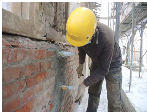
照片3-6-4 磚牆裂縫灌注 (2)。
