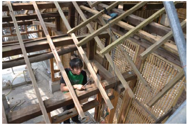
照片3-4-52 於車寄屋架四周施作火打樑，斷面 9×9 cm。
