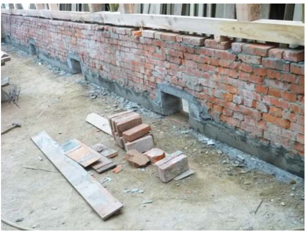
照片3-2-21 無收縮水泥砂漿灌注完成後。
