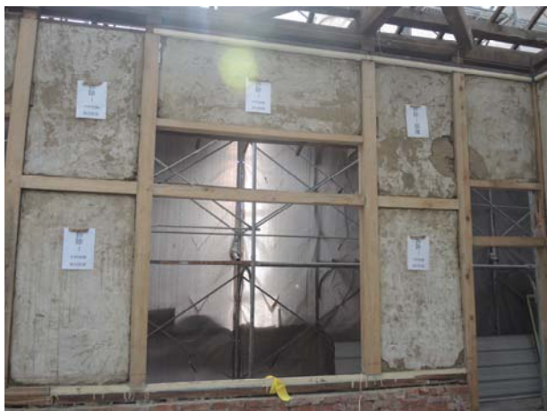
照片3-1-11 牆體面層拆除，依損壞狀況標示修復層級（1）。
