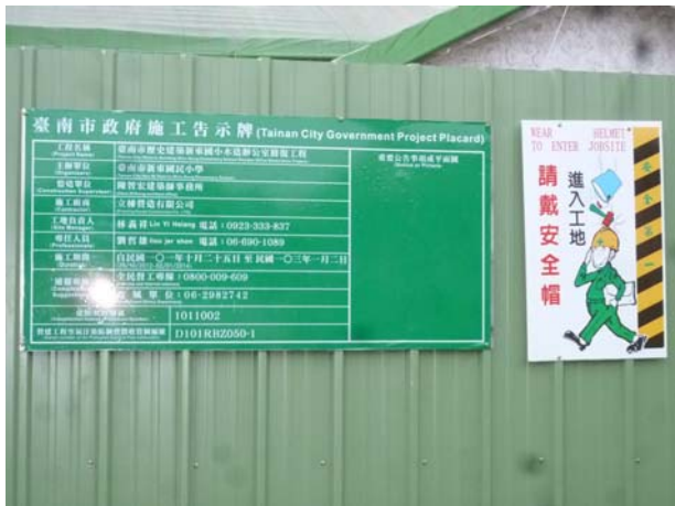
照片3-1-29 工程告示牌及警示標語施作完成。
