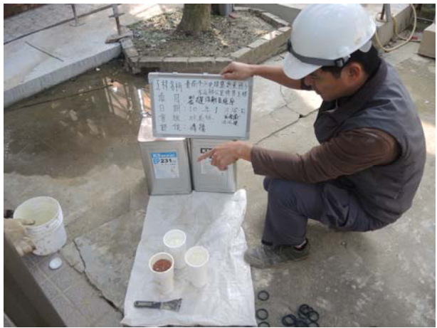
照片3-6-2 磚牆裂縫補強用 EPOXY 進場。
