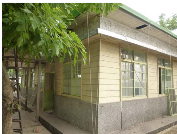
照片3-1-4 修復前左向立面。
