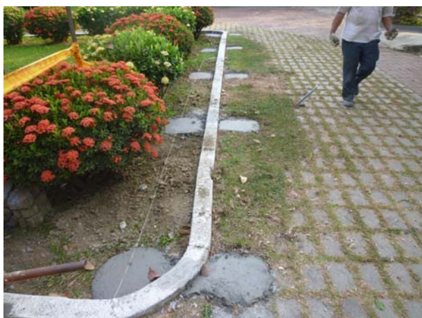
照片3-1-21 甲種圍籬柱位灌漿後。
