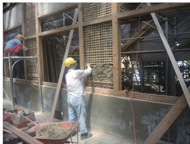
照片3-3-68 底塗泥土層施作情形。
