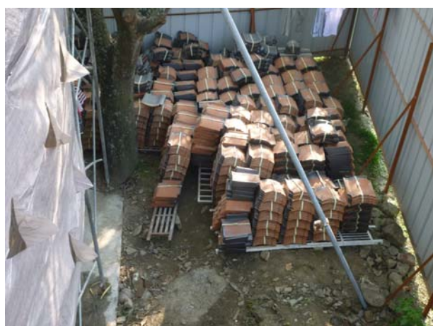
照片3-5-12 屋瓦整理於地面層，待回鋪使用。
