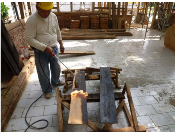
照片3-3-93 原有雨淋板進行碳化處理。
