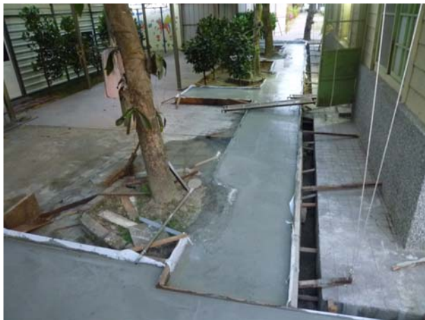
照片3-1-38 基礎灌漿施作完成。
