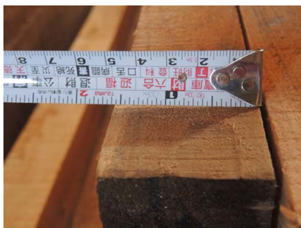
照片3-4-16 屋頂桷材尺寸確認。
