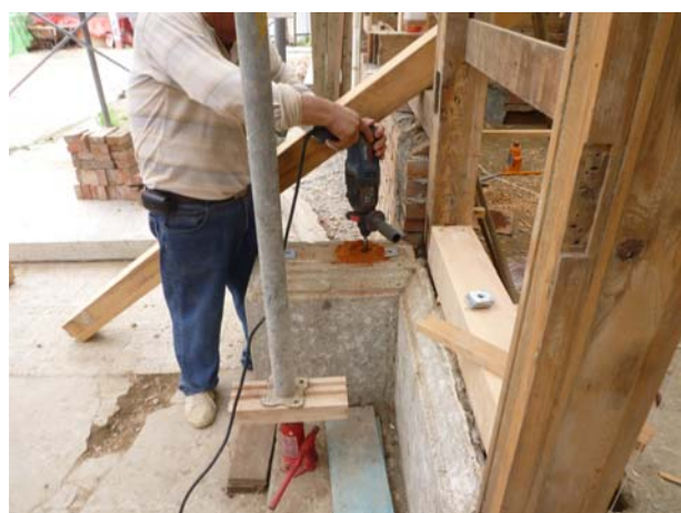
照片3-6-17 檻木埋設不銹鋼螺栓。
