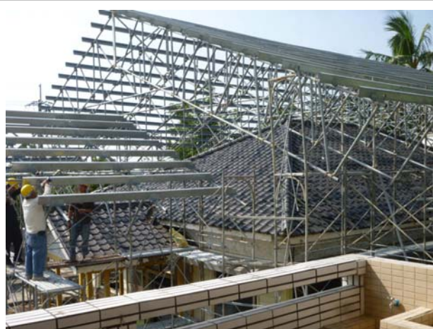
照片3-1-47 車寄上方鋼管組合桁架吊裝施作 (1)。
