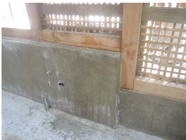
照片3-2-29 基牆內側施作 1:3 水泥砂漿打底。
