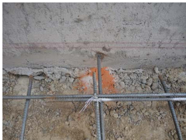
照片3-2-37 與基牆進行植筋接續。
