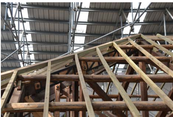
照片3-6-11 人字樑進行角鋼固定補強。
