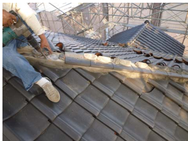
照片3-5-9 脊瓦拆卸，以手動電鑽機進行拆除。
