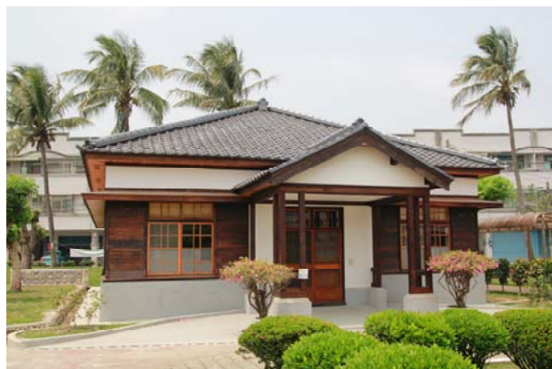
照片3-5-81 屋頂修復後照片 (4)。
