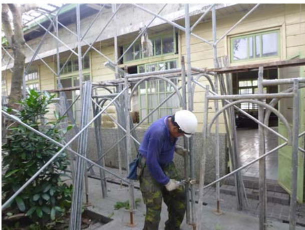
照片3-1-41 施工鋼管鷹架組裝施作(1)。
