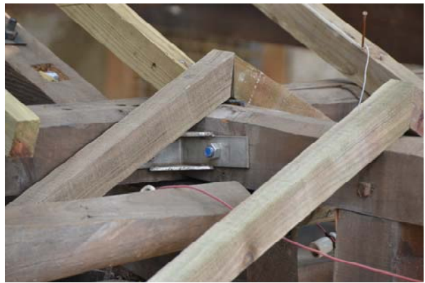
照片3-4-54 兩側各施作角鋼及 M16 螺栓固定。
