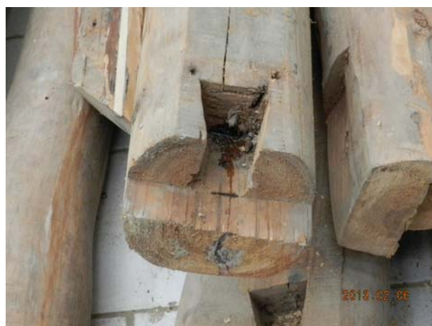
照片3-4-39 桁木接續採燕尾榫型式 (2)。
