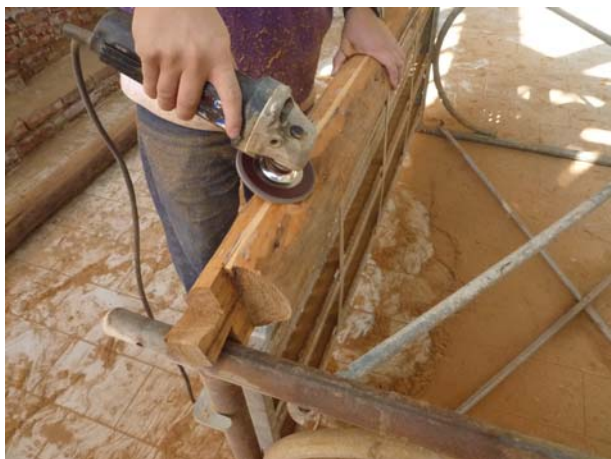
照片3-4-44 使用電動研磨機進行磨平作業。
