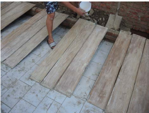
照片3-3-91 拆卸後於地面使用剝漆劑進行剝漆施作。
