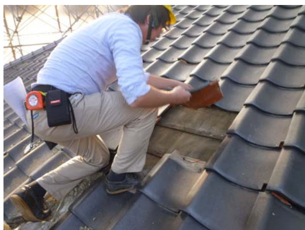
照片3-5-8 屋瓦拆卸。
