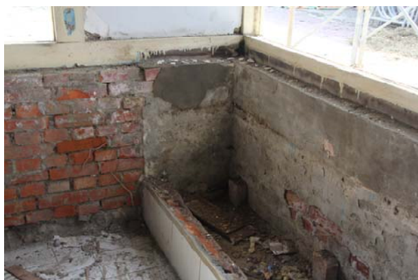
照片3-2-11 室內壁櫃拆除後。
