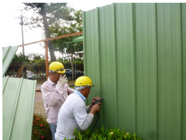
照片3-1-25 烤漆鋼板施作，以自攻螺絲固定 (1)。
