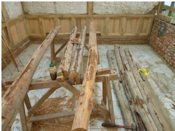
照片3-4-42 桁木損壞處以木條加 EPOXY 進行填補 (3)。
