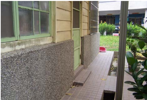
照片3-2-65 北向基牆修復前情形。
