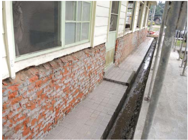
照片3-2-8 基牆外側面層鑿除後情形。
