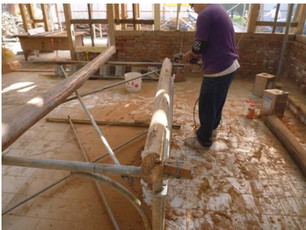
照片3-4-43 以電動鉋到進行鉋平，再使用電動研磨機進行磨平作業。
