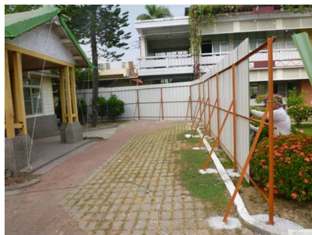
照片3-1-26 烤漆鋼板施作，以自攻螺絲固定 (2)。
