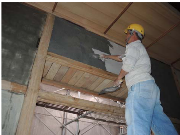
照片3-3-75 面塗白灰粉刷施作過程(1)。
