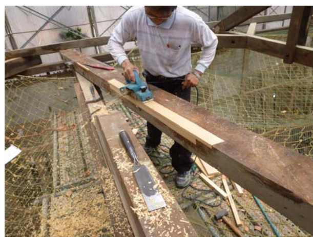
照片3-4-30 以電鉋刀進行鉋平修整。
