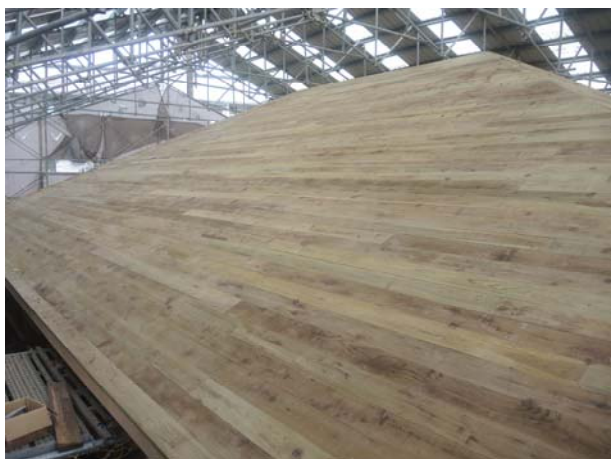
照片3-5-38 屋面板釘著完成。
