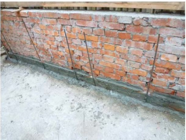
照片3-2-20 灌注無收縮水泥砂漿，以模板及#3 鋼筋做為阻擋（北向內側基牆）。
