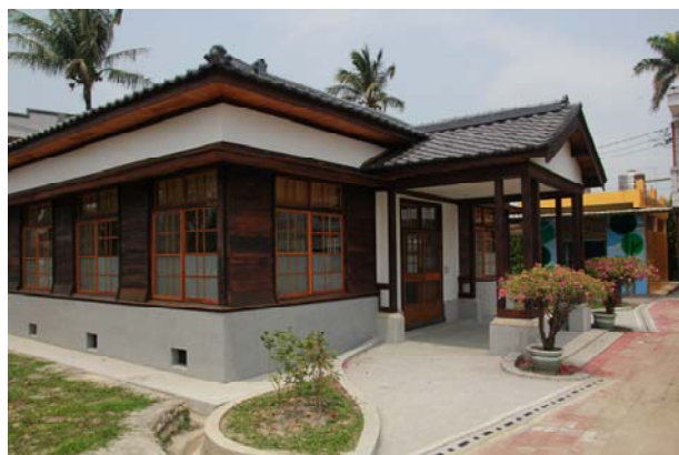
照片5-3-21 東向立面外觀修復後照片 (2)。
