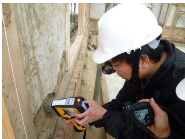
照片5-2-1 原有牆體成份試驗施作（1）。
