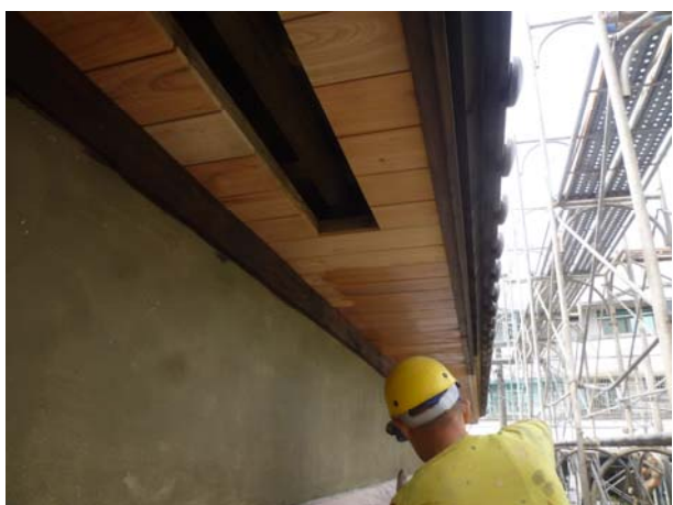
照片5-3-7 封簷天花刷塗透明護木漆施作情形（2）。
