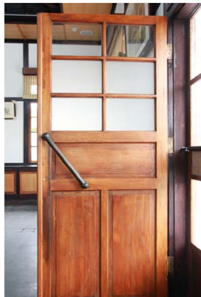
照片5-3-15 主入口大門修復後情形 (2)。
