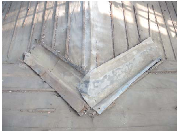
照片5-4-10 陰角天溝為亞鉛板材質所構成。
