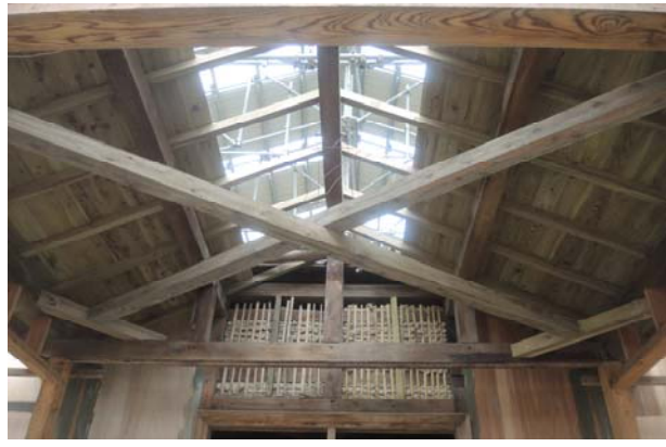
照片5-1-10 中間施作木製交叉拉桿。
