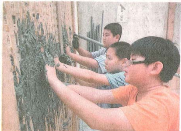
新東國小學童參與歷史建物編竹夾泥牆修復工程，認識古早建物構造。(記者王涵平攝)
