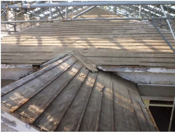
照片5-4-9 屋頂陰角天溝修復前情形。
