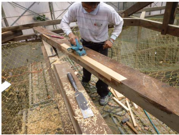
照片5-1-7 敲擊確實固定後，再將多餘木料鉋除。
