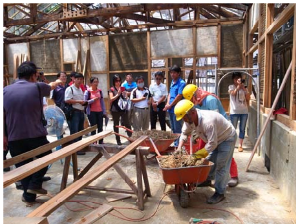
照片5-4-16 解說編竹夾泥牆底塗泥土施作過程。
