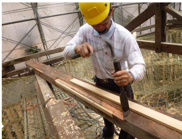
照片5-1-4 木構件裂縫處以 EPOXY 加檜木木條進行修補。
