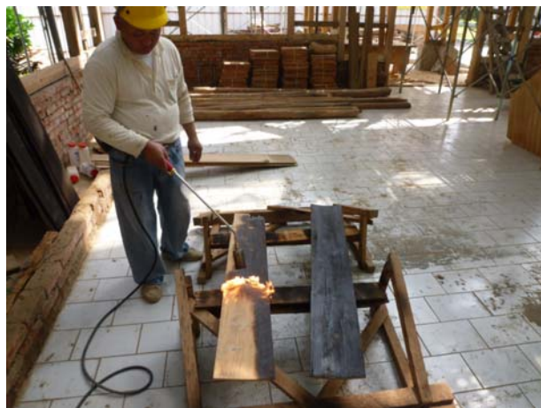
照片5-3-17 雨淋板碳化施作情形 (2)。
