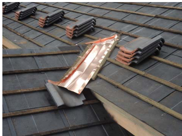
照片5-4-12 本次修復新作銅製天溝，比較原先使用亞鉛板材質可延長使用年限。
