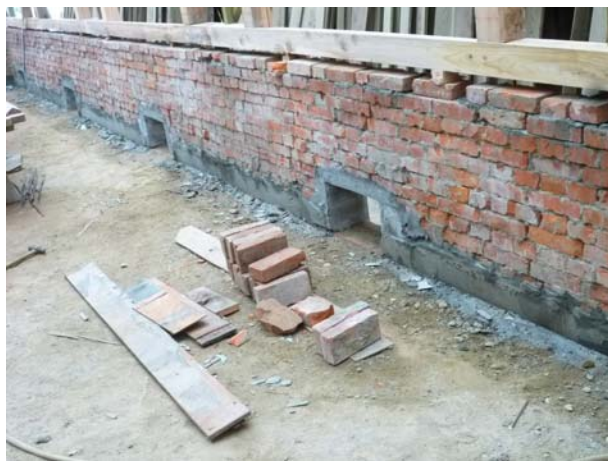
照片5-4-4 本次修復配合新增通氣孔，以無收縮水泥砂漿填補，並粉刷平整處理。
