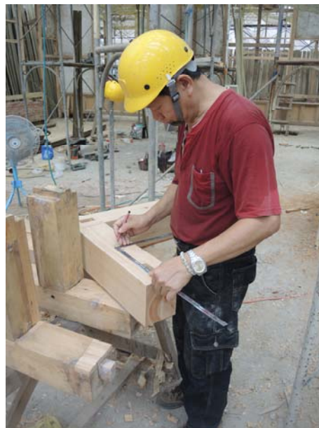
照片5-4-18 木作匠師劉源生先生於工地現場進行木料仿作情形。
