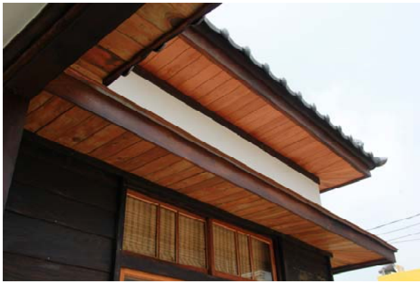
照片5-3-10 封簷天花及雨遮天花修復後情形。
