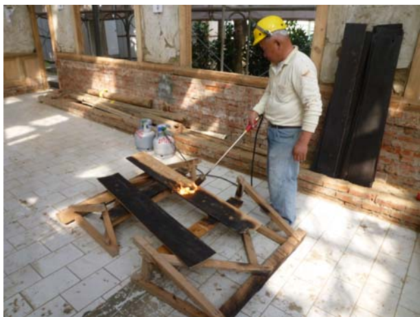
照片5-3-16 雨淋板碳化施作情形 (1)。
