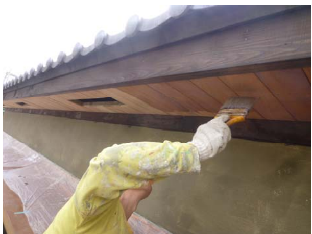
照片5-3-6 封簷天花刷塗透明護木漆施作情形（1）。
