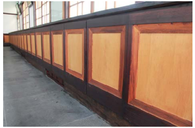
照片5-3-11 室內矮櫃修復後情形。
