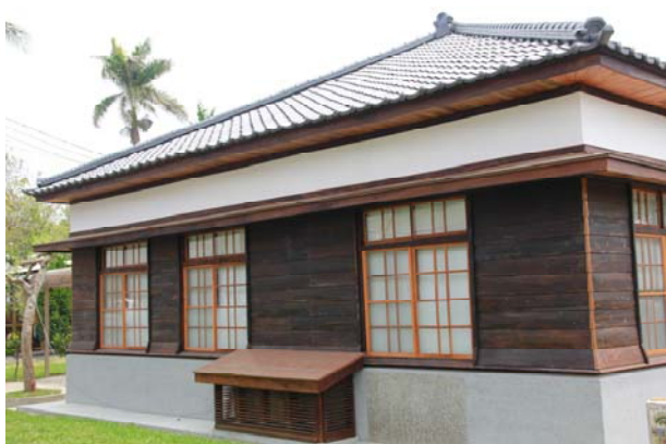
照片5-3-9 西向外觀修復後情形。
