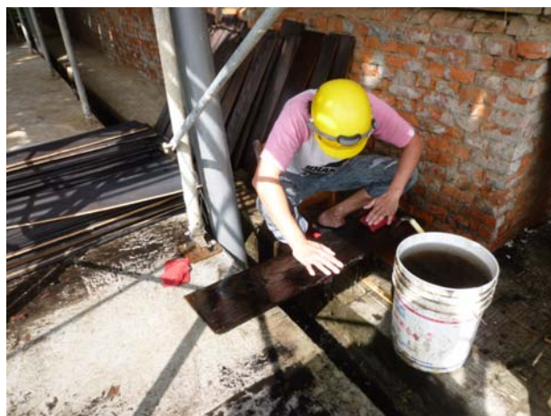
照片5-3-19 以水柱進行清洗作業 (2)。
