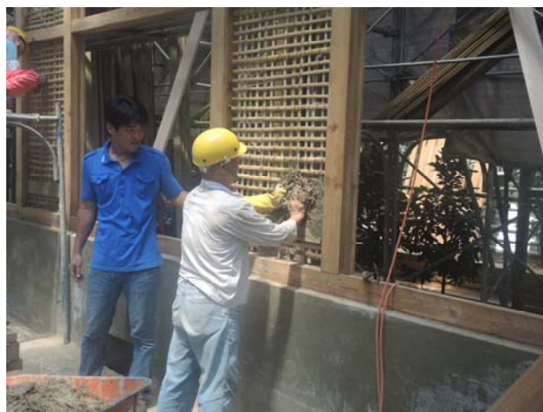
照片5-4-14 解說編竹夾泥牆底塗施作過程。
