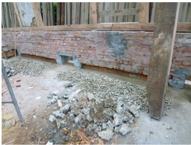
照片5-4-3 內基牆底層為紅磚直立排放。
