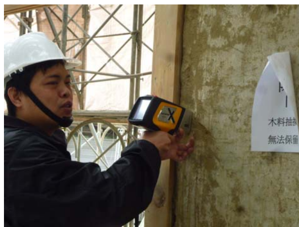
照片5-2-2 原有牆體成份試驗施作（2）。
