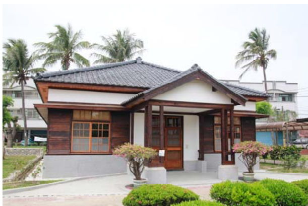
照片5-3-20 東向立面外觀修復後照片 (1)。
