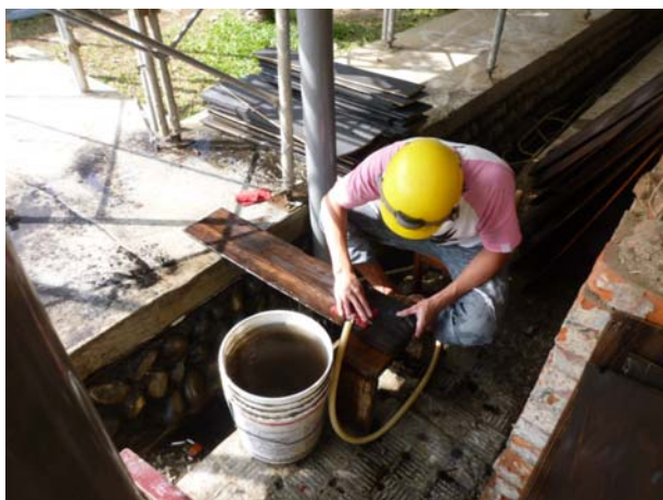
照片5-3-18 以水柱進行清洗作業 (1)。
