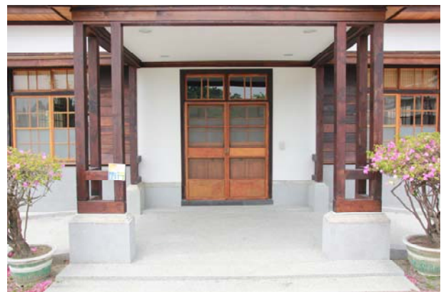
照片5-3-13 車寄軸組修復後情形。
