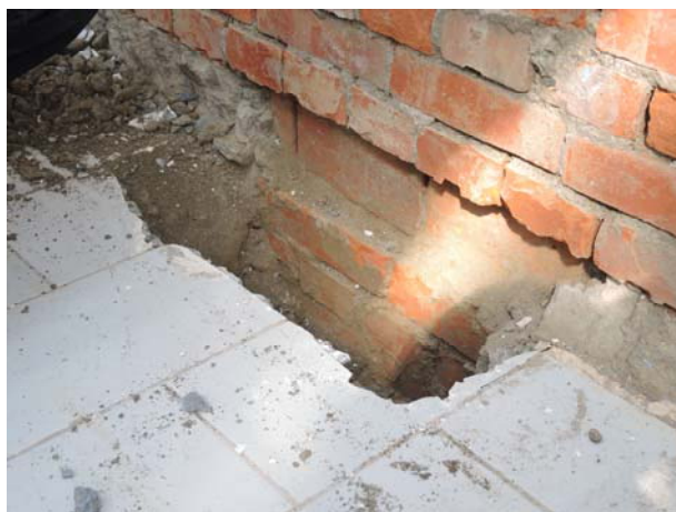
照片5-4-2 內基牆基礎底層為三層磚所構成。
