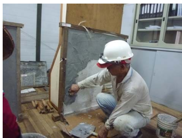
照片5-4-20 泥作匠師林惠榮先生於工地現場進行木摺灰泥牆試體施作情形。
