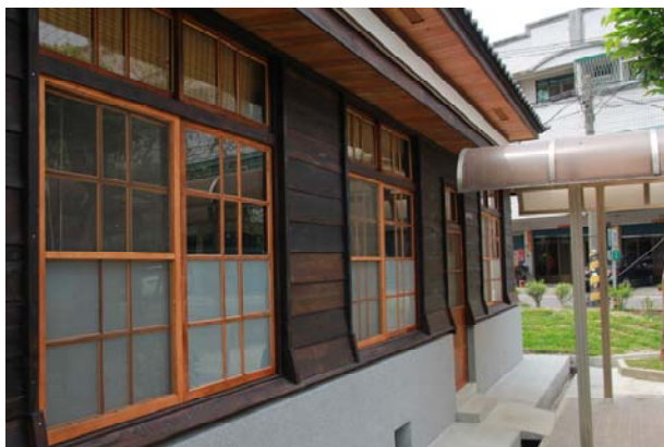
照片5-3-12 外牆雨淋板與窗戶修復後情形。
