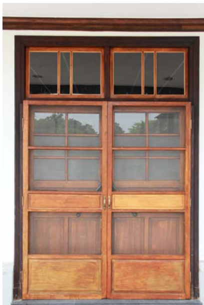
照片5-3-14 主入口大門修復後情形 (1)。
