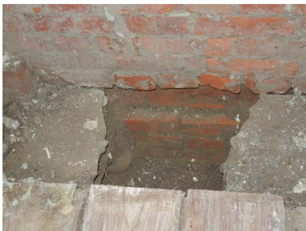
照片5-4-1 內基牆基礎試挖。
