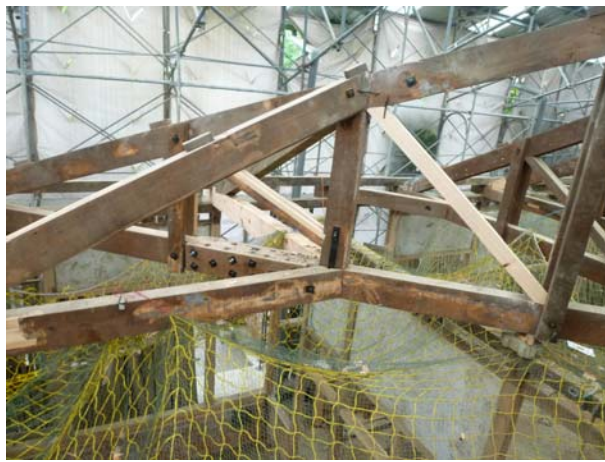
照片5-1-8 屋架修補及抽換後情形。
