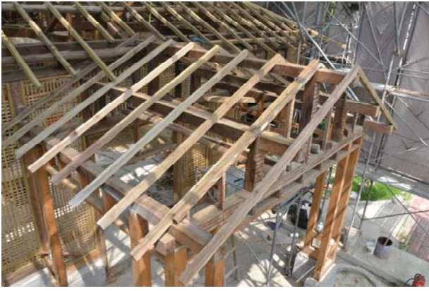
照片5-1-9 車寄屋架與主體建築銜接處施作不銹鋼鐵件補強。
