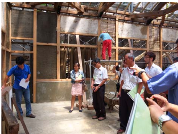
照片5-4-15 解說軸組木料修復情形。
