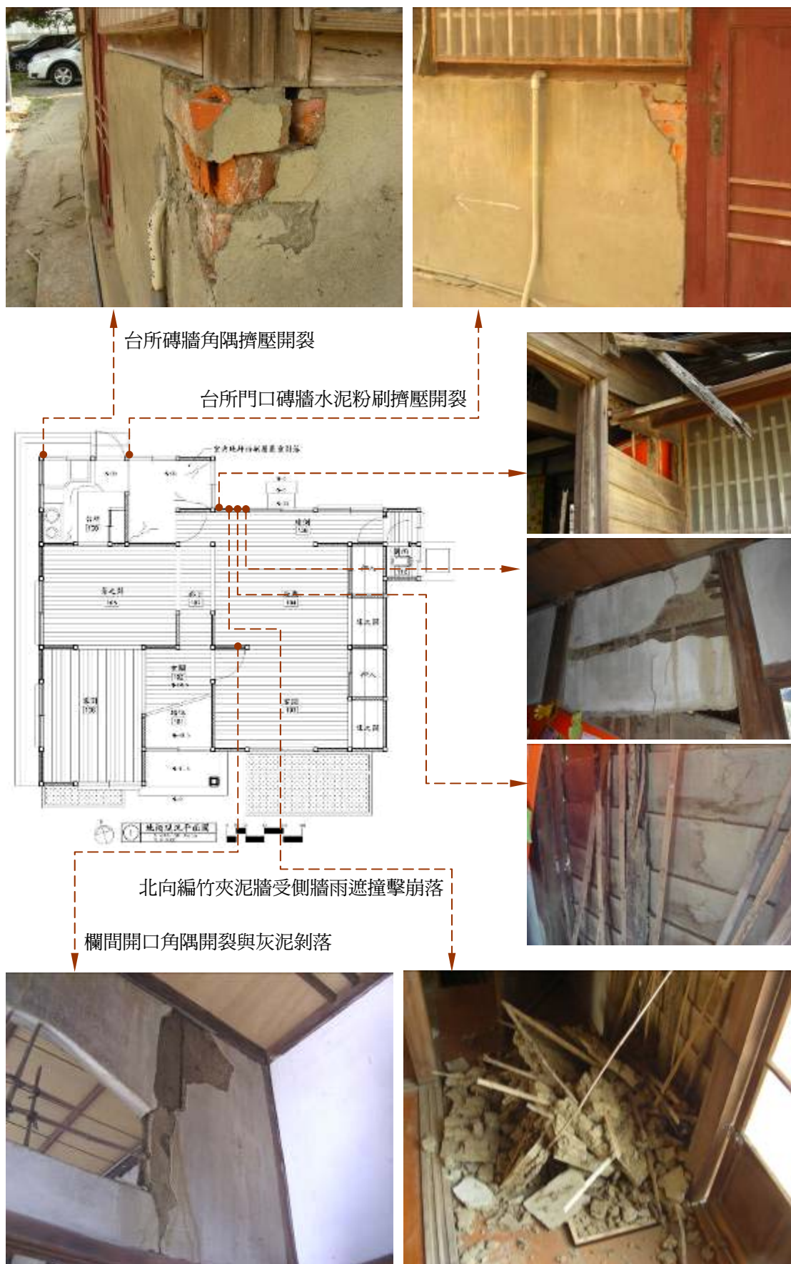
【圖 5.4.6】新東國小校長宿舍之甲仙地震震損記錄（二）
