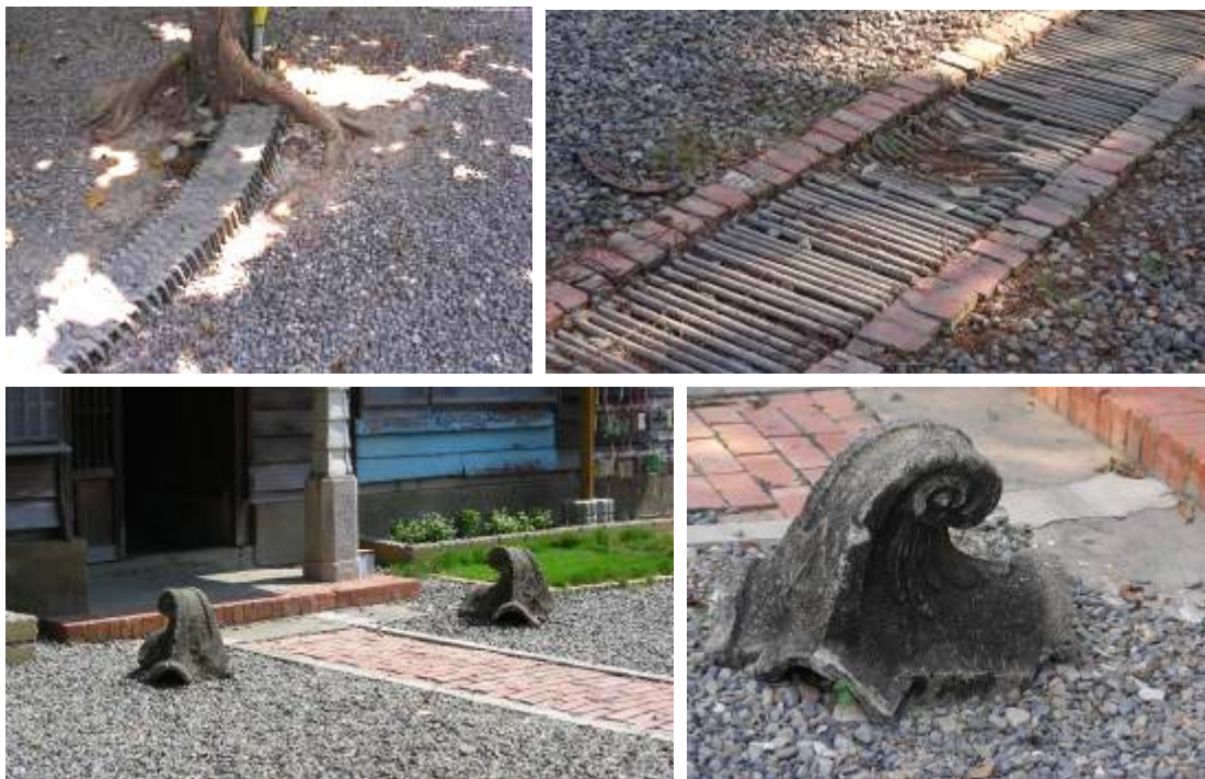
【圖 8. 4. 3】台南縣歷史建築新東國小校長宿舍廢棄水泥瓦片使用於鋪面
