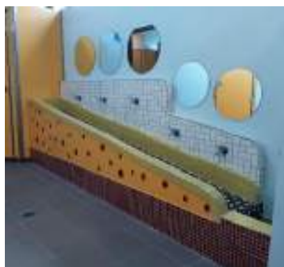
設置全齡可使用洗手台
