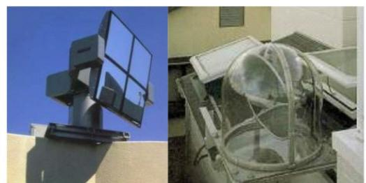
適用大型空間的智慧型導光系統
