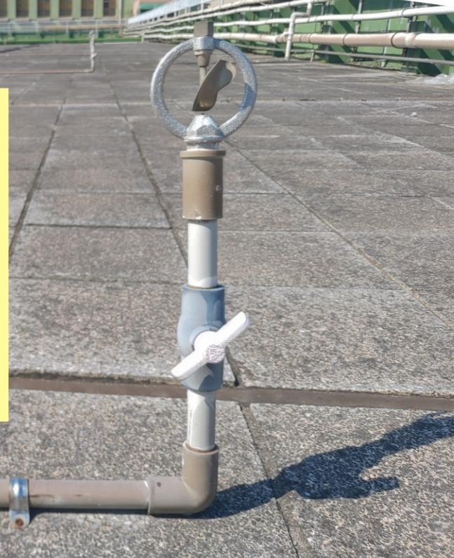
透過屋頂灑水系統有效降低建築物結構體溫度
