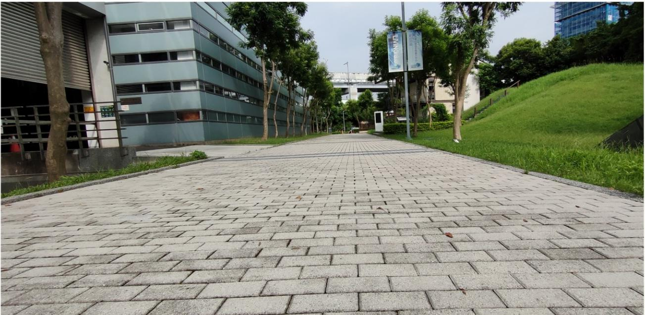
步道採用透水磚鋪面達到透水功能（上）、潭美國小人行步道透水鋪面（下）
