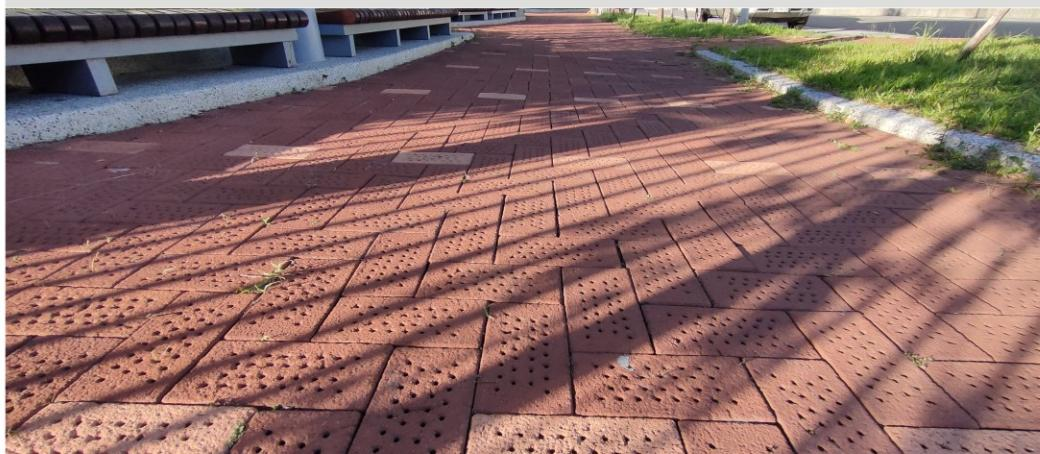
車道的鋪面則以採用防滑之整體型透水鋪面為宜，如透水性瀝青、透水性混凝土、多孔性混凝土版構造或透水性樹脂混合天然石砂粒等，並確保其能承受車輛行經之重壓。
