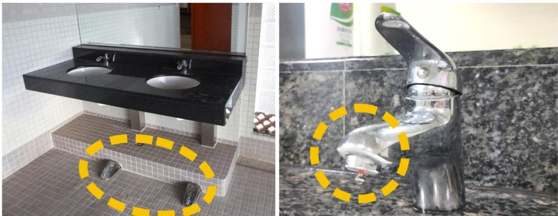
採用腳踏式給水設備(圈選處)或選用氣泡型省水器(圈選處)以節省水資源
