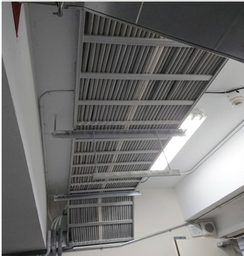
校舍內空間的佈線通常利用天花板佈放，即利用樓頂板，以圓形管、纜架或線槽等方式設置；吊掛於樓頂板的下方，再於適當的位置沿牆側、柱或引線管而下。若樓頂板下方尚裝潢了天花板，則其配管系統應設置於樓頂板與天花板之間，且其配置與天花板的垂直距離不得小於7.5公分。
