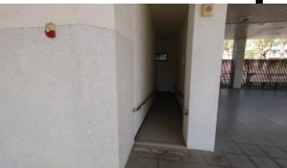
科學館一樓 無障礙坡道
