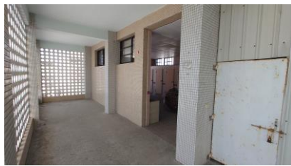
篤行樓西側三樓女廁
