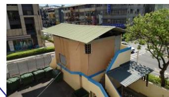
回收室二樓樓樓梯 間
