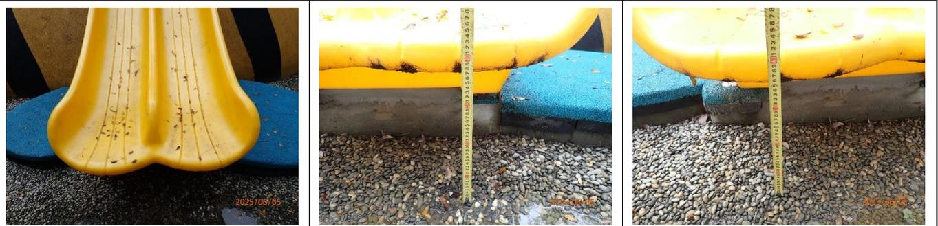
以下未符合規範第 9.1.1 章節要求。(設備使用區防護鋪面易造成絆倒危害)
