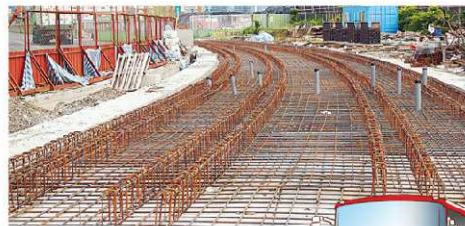
▲輕軌道床的鋼筋網，是道床很重要的基礎結構。
