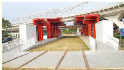
▲以穩定的道床為基礎，就能因應不同需求鋪設不同的路面。
