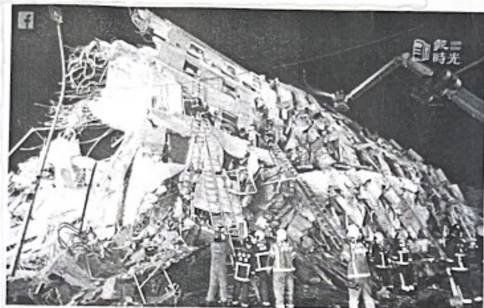
維冠大樓倒塌圖
