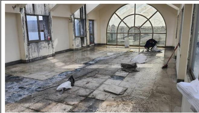
室內磁磚冷熱差異而爆開，打除後做防水鋪面
