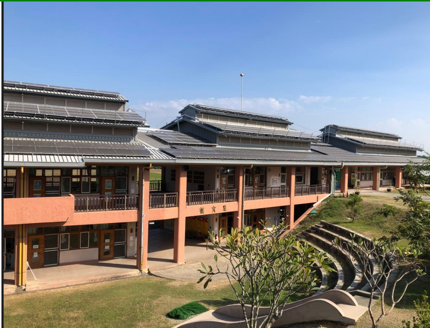
惠育樓南面屋頂設置自有太陽能光電設施
